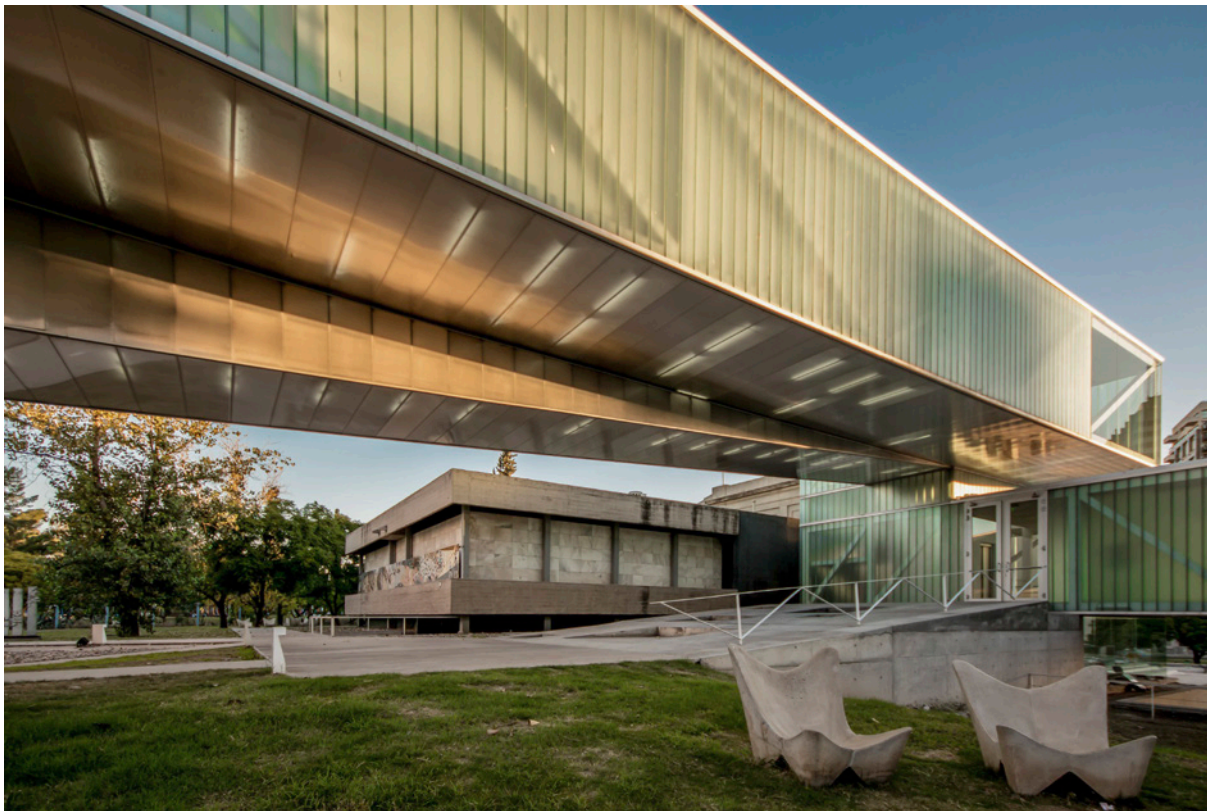
Vista externa del Museo Provincial de Bellas Artes Emilio Caraffa (patio interno-oficinas-puente). Fotografía: Arq. Gonzalo Viramonte.
