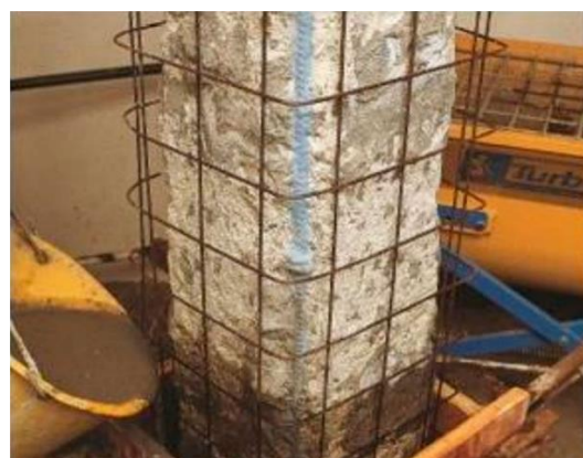
Figura 52/ Rearmado externo/ Google
