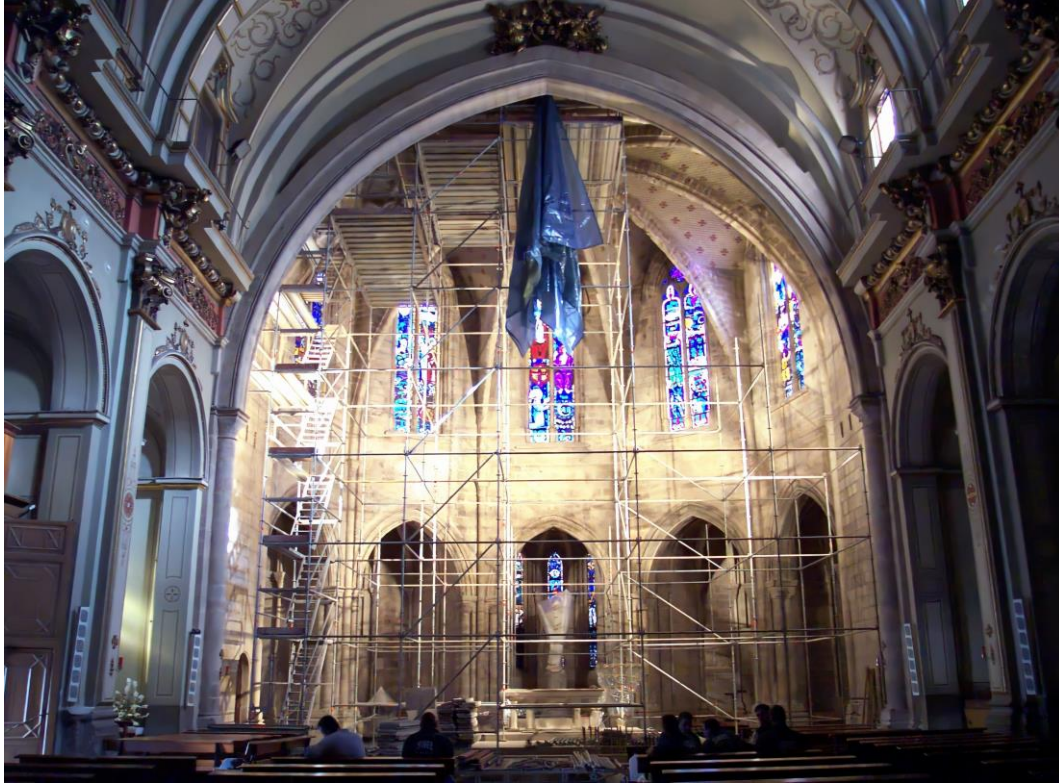
Figura 166/ Andamiaje del ábside/ Guillermo Ríos
