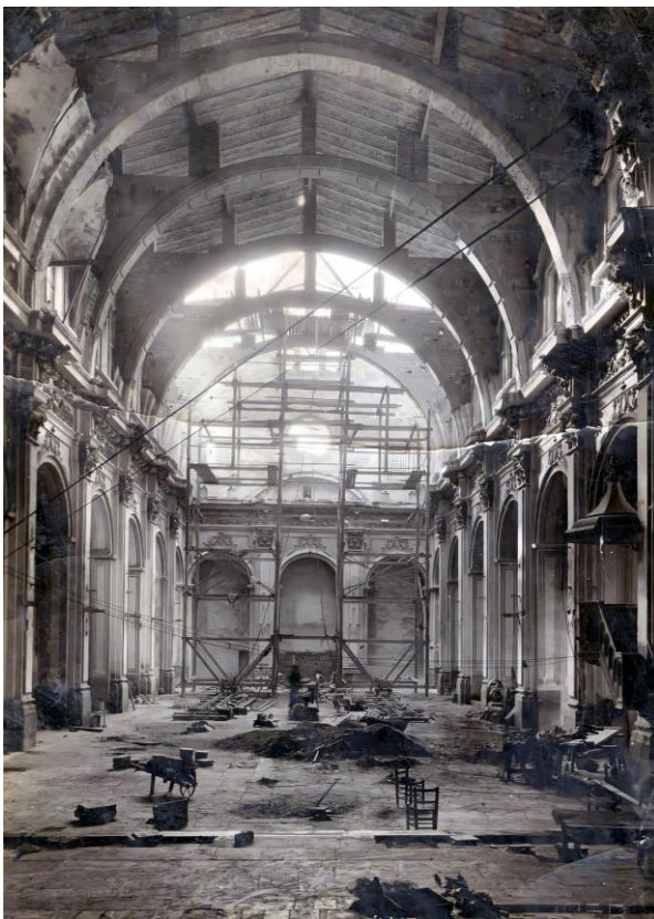
Foto 17/ Reconstrucción Cubierta/ 1945/ Archivo Municipal
