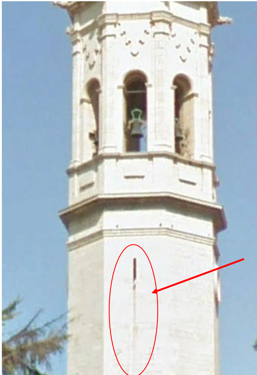
Figura 103/ Desembocadura de canalización en ventana/ Google Earth
