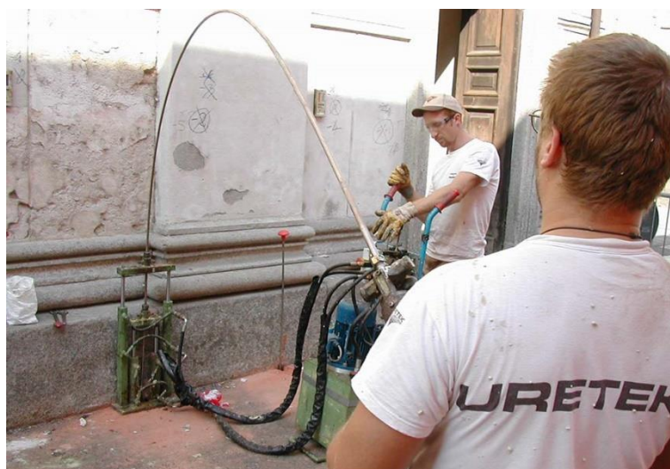
Figura 106/ Mangueras de inyección/ Uretek
