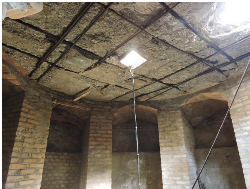
Figura 102/ Cámara entre techo de sala de campanas y suelo de cubierta/ Diócesis Segorbe Castellón
