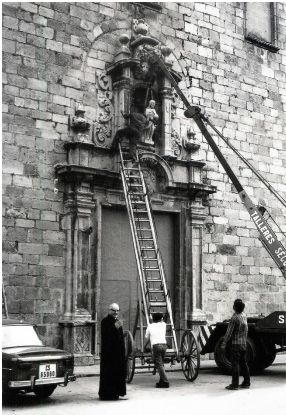
Foto 12/ Restauración Este de fachada principal
