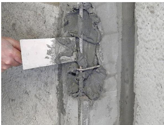
Figura 52/ Recubrimiento de armado/ Google
