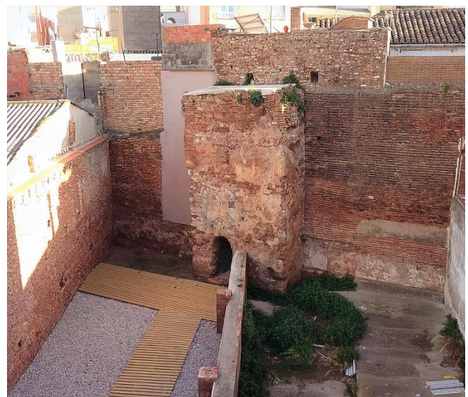
Foto 4/ Torre baluarte Calle San Pascual
