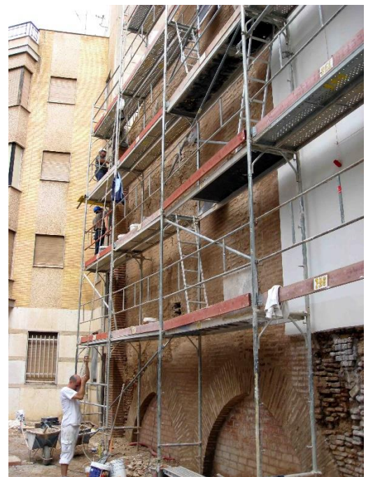
Figura 172/ Paramentos perimetrales/ Guillermo Ríos
