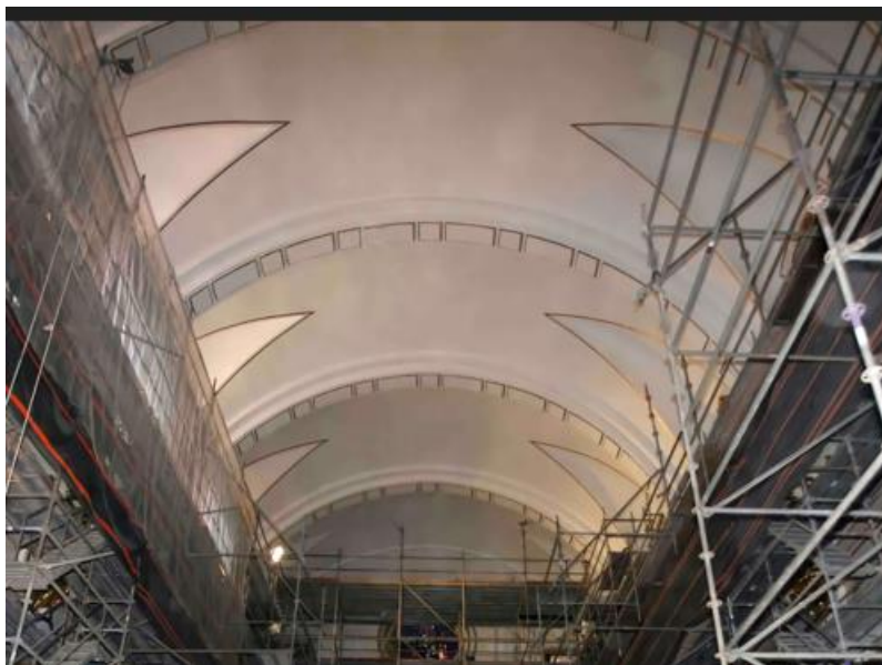
Figura 160/ Bóvedas nave central/ Guillermo Ríos
