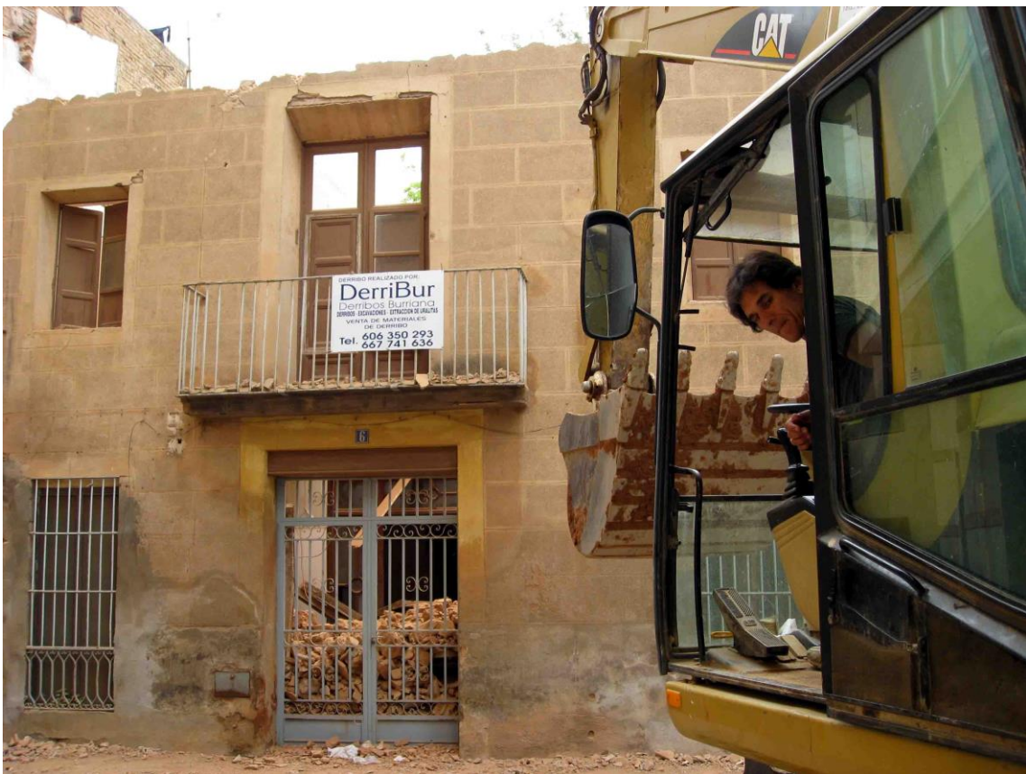
Foto 9/ Derribo de Casa de la Abadía
