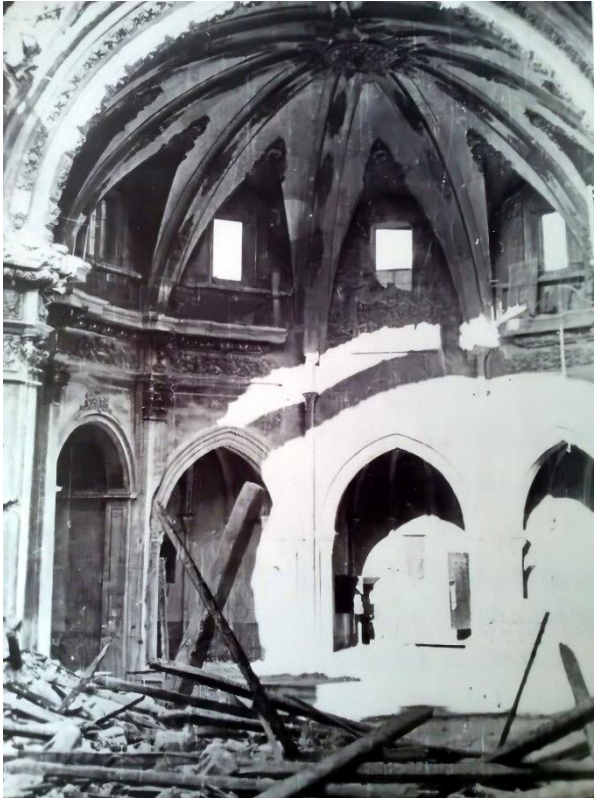
Foto 12/ Escombros después de explosión/ Archivo municipal
