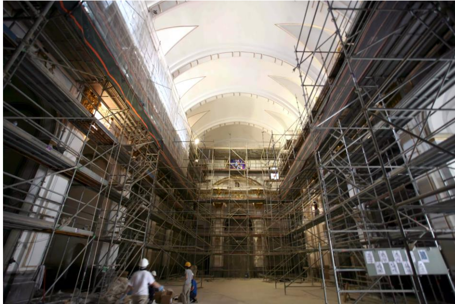
Figura 170/ Laterales nave principal/ Guillermo Ríos
