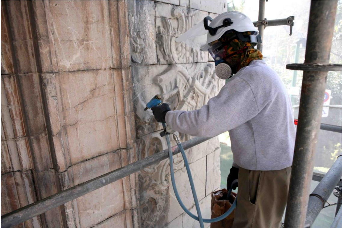
Figura 155/ Limpieza abrasiva en seco/ Guillermo Ríos
