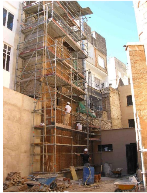
Foto 2/ Restauración torre baluarte
