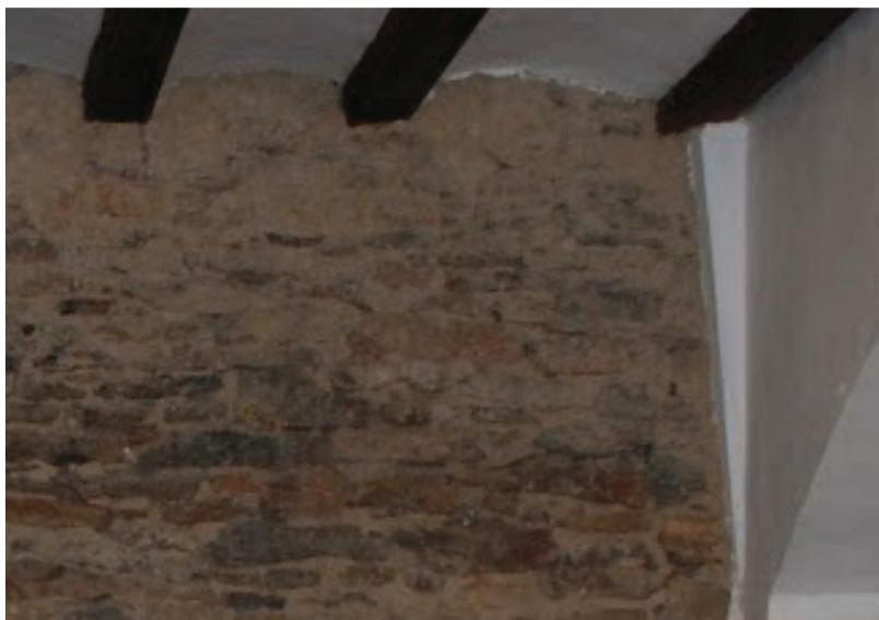
Figura 86. Imagen de muro de carga de la Casa dels Santjoans.
