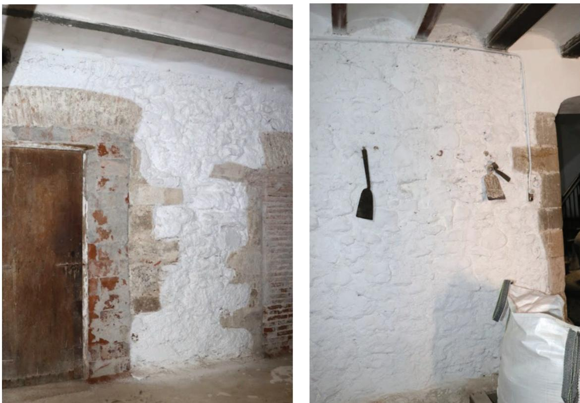
Figuras 57 y 58. Imágenes de muros de carga de la Casa de los Miquel.
