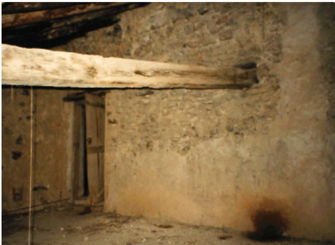
Figura 100. Imagen de muro de carga de la Casa Polo de Vistabella.
