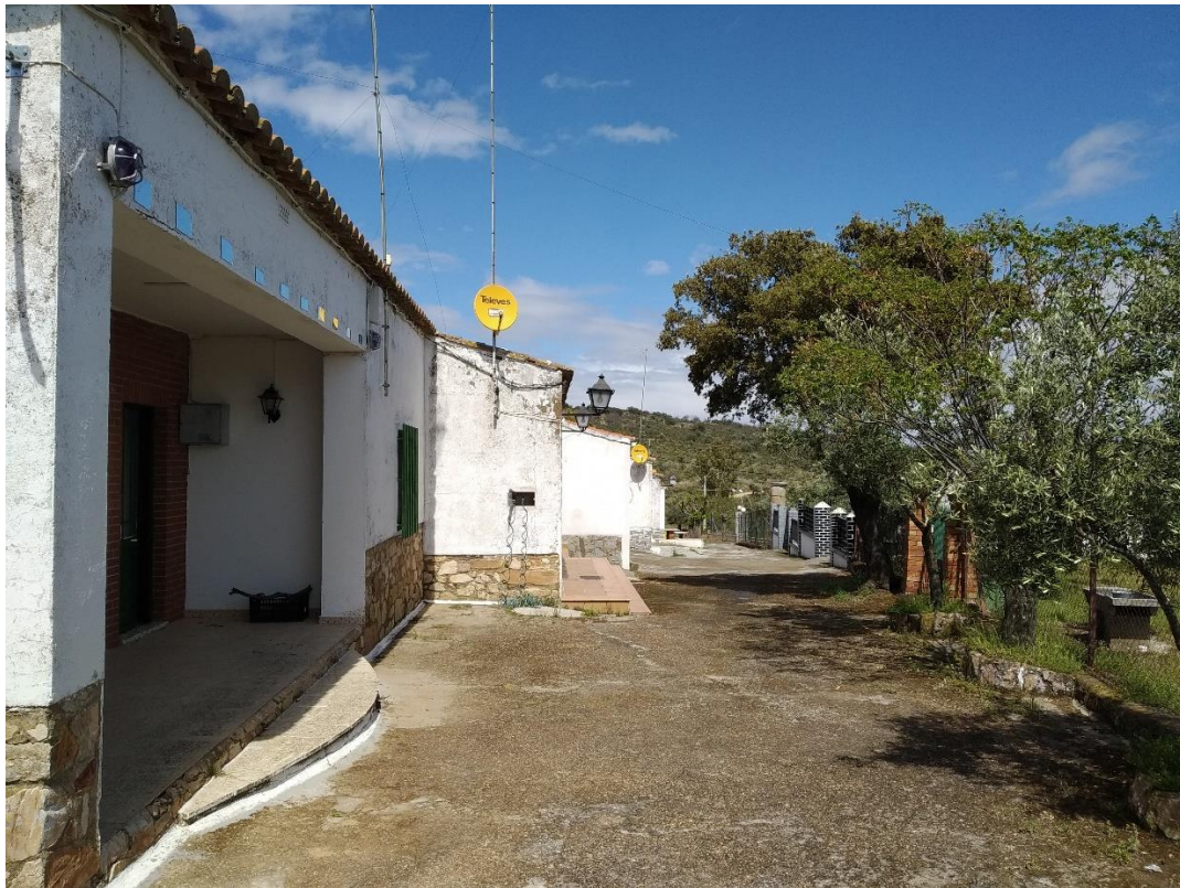
Imagen 1. Vista lateral del conjunto de viviendas, dirección Ermita de la Charca. El camino de la imagen es una cañada real que discurre frente a las viviendas.
