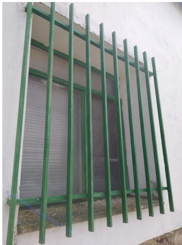
Imagen 10 - Vivienda 969: carpintería metálica.
