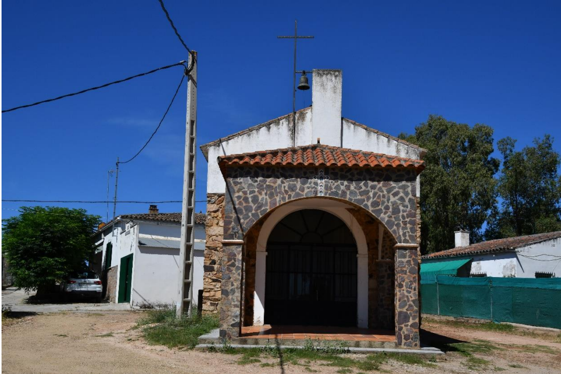
Imagen 2. Fotografía frontal de la Ermita de San Cristóbal.
