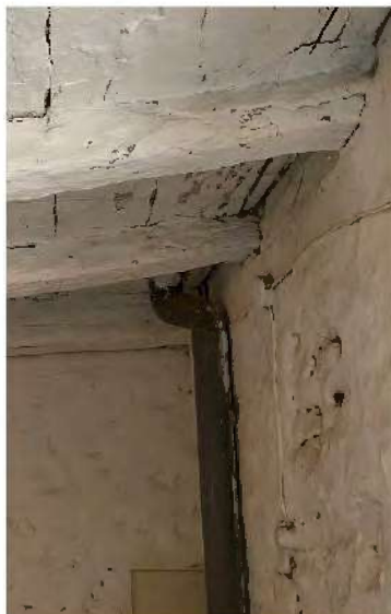
Ilustración 21. Tubería de desagüe de PVC, instalación de saneamiento. Fuente: propia.
