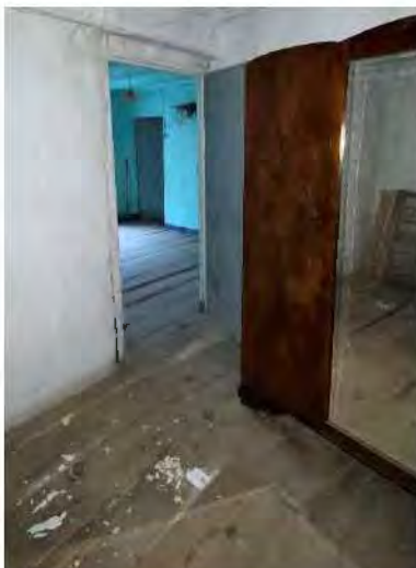
Ilustración 18. Solado planta primera, entablado de madera. Fuente: propia.
