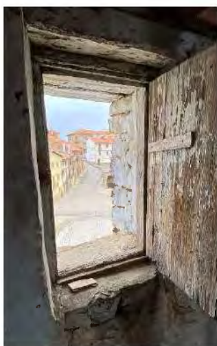
Ilustración 14. Carpintería exterior de madera. Fuente: propia.
