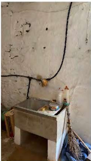
Ilustración 20. Tubería de polietileno, instalación de fontanería. Fuente: propia.
