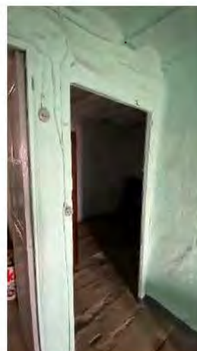
Ilustración 16. Partición interior planta primera. Fuente: propia.
