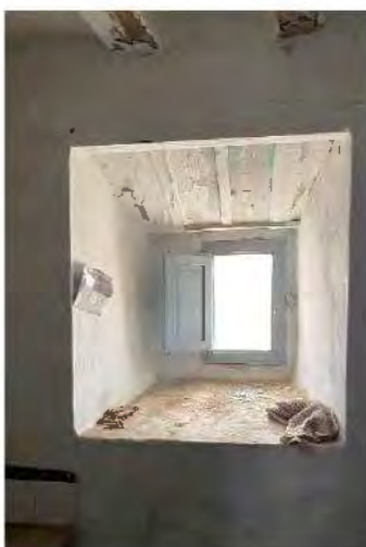
Ilustración 15. Carpintería exterior de madera. Fuente: propia.
