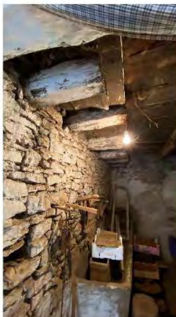
Ilustración 13. Muro de carga planta baja. Fuente: propia.
