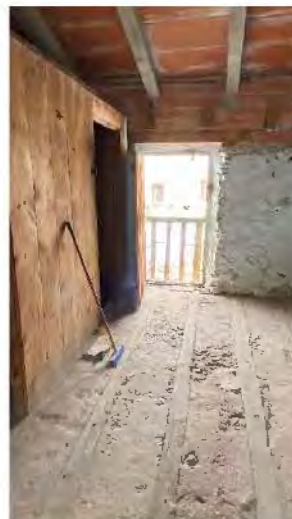
Ilustración 19. Solado planta bajo cubierta. Fuente: propia.
