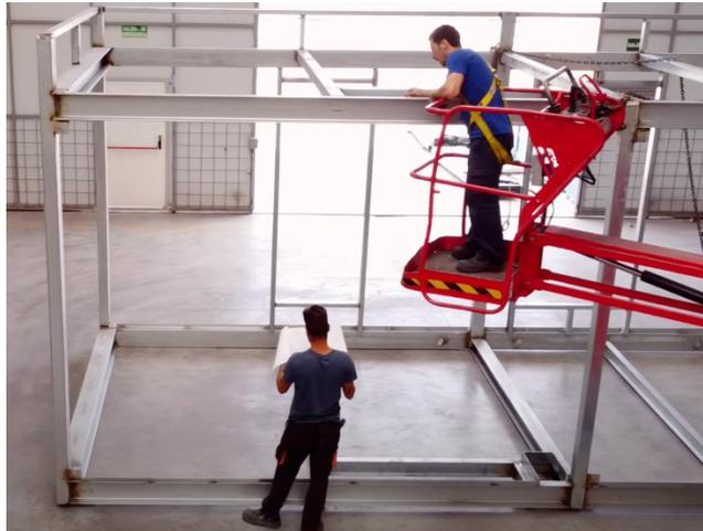
*Ilustración 76 Estructura metálica empleada en los módulos.*
