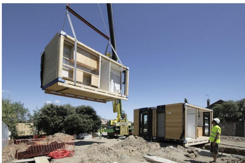
*Ilustración 53 Implantación en obra de un módulo de la empresa Modulab.*
