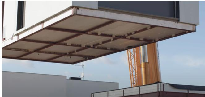
*Ilustración 63 Vista inferior de la estructura utilizada en las viviendas de la empresa KUB'S BY KIT'S.*
