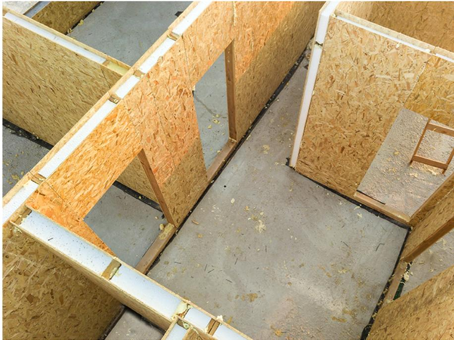
*Ilustración 28 Vivienda ejecutada mediante paneles SIP.*
