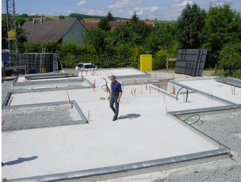
*Ilustración 55 Losa empleada para la cimentación de Typenhaus de e2a.*
