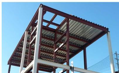
*Ilustración 22 Estructura prefabricada de acero.*
