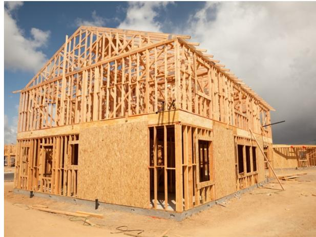
*Ilustración 17 Vivienda unifamiliar ejecutada con el sistema Platform Frame*
