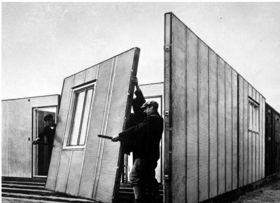
*Ilustración 27 Montaje de paneles de la Casa de Cobre, Casas que crecen, en Berlín (Gropius, 1931)*
