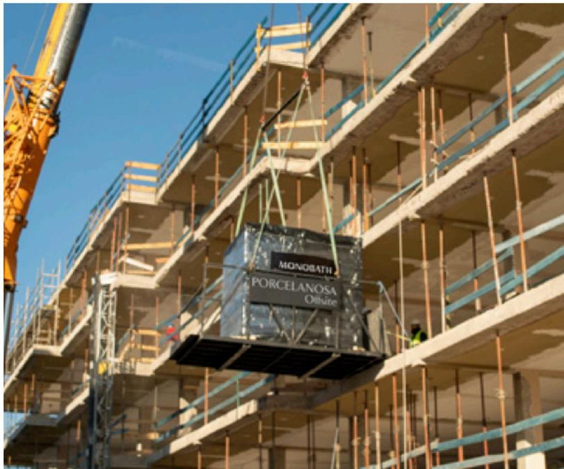
Ilustración 72 Izado del módulo.
