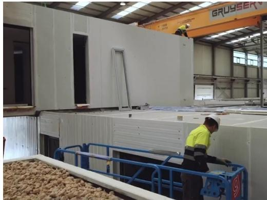
*Ilustración 68 Colocación de los paneles sándwich en obra.*
