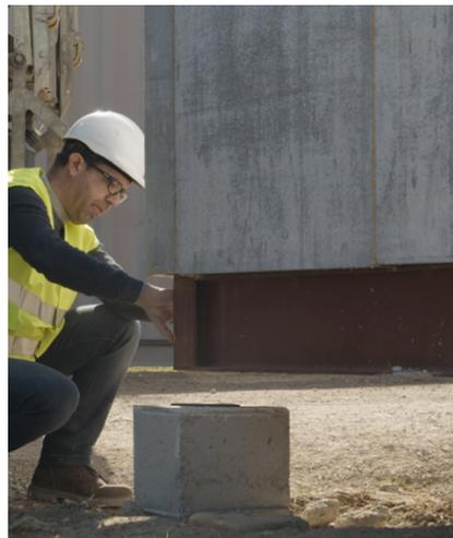
*Ilustración 64 Colocación de un módulo sobre cimentación.*
