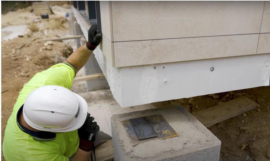
*Ilustración 66 Colocación de un módulo sobre cimentación por InHAUS.*
