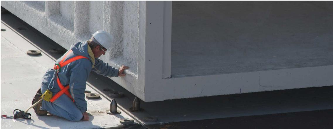
*Ilustración 50 Unión de dos módulos estructurales de hormigón eMii-C de Compact Habit.*
