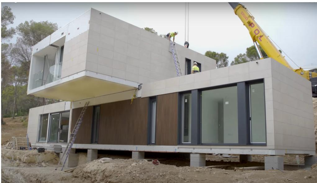
*Ilustración 65 Implantación de una vivienda modular de la empresa InHAUS en el solar.*
