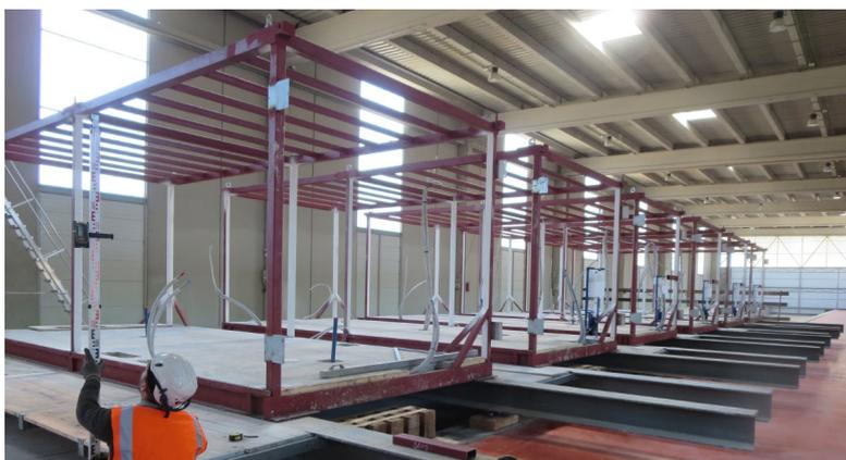
*Ilustración 42 Estructura interna correspondiente al sistema eMii-CS de la empresa Compact Habit.*
