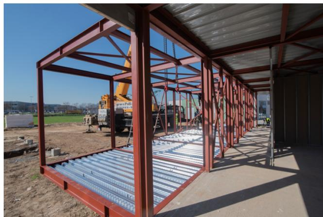
*Ilustración 62 Estructura utilizada en las viviendas de la empresa KUB'S BY KIT'S.*
