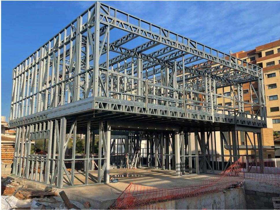
*Ilustración 19 Vivienda unifamiliar ejecutada con el sistema Steel Frame*
