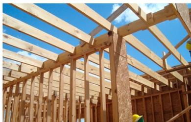
*Ilustración 21 Estructura prefabricada de madera.*
