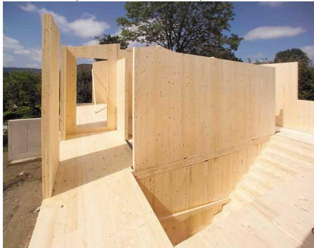
*Ilustración 31 Vivienda unifamiliar a partir de paneles de madera contralaminada.*
