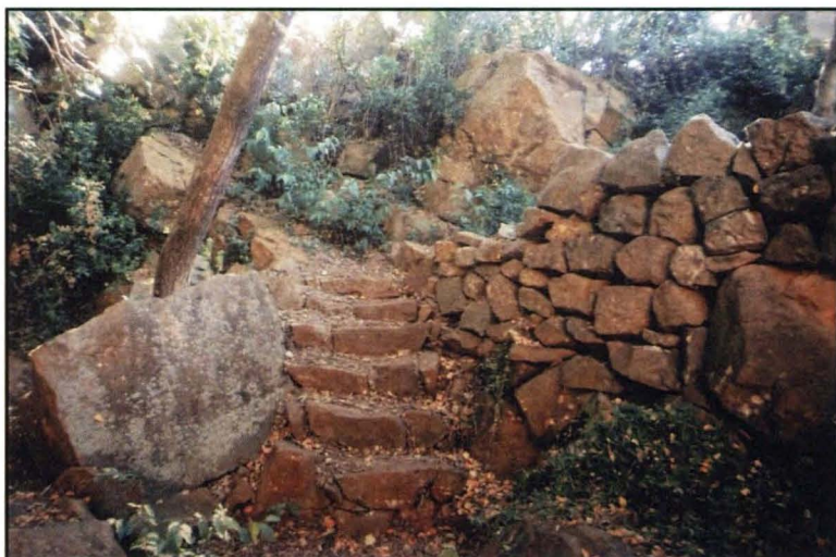
Figura 2: La Cova (Fondegulla). Treballs accés.
