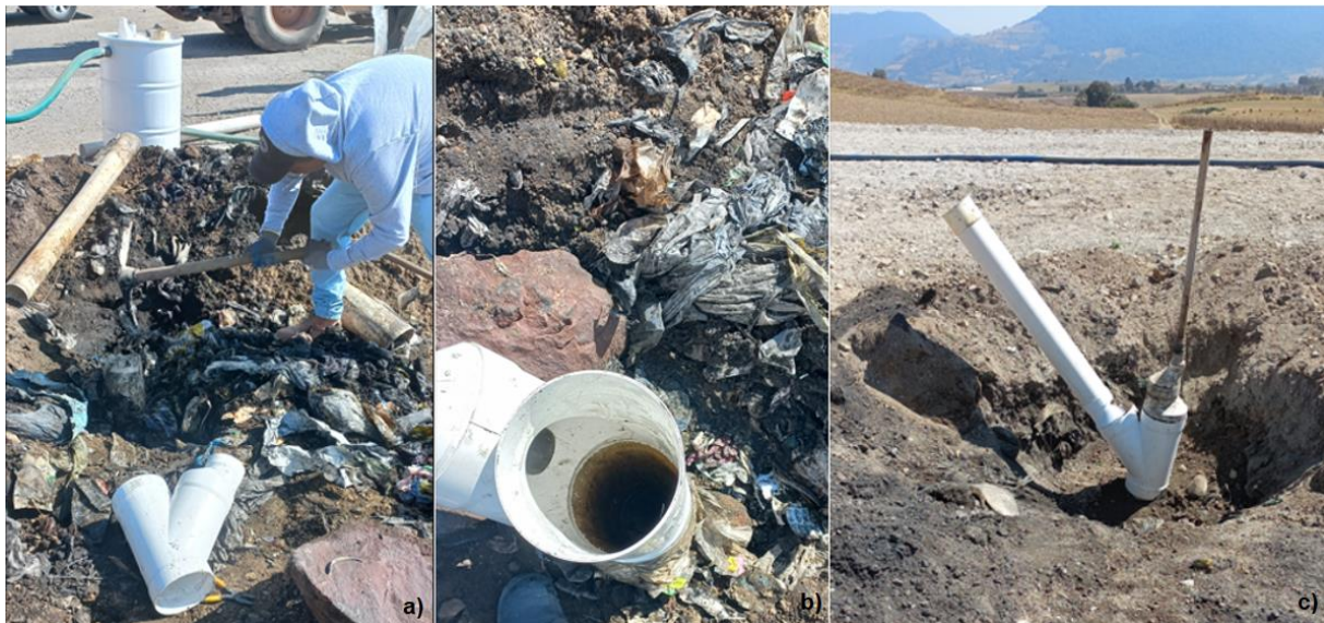
Figura 4. a) Destapado de pozo b) Montado de partes c) Pozo con Derivación Y
