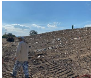
Figura 5b. Ejemplo de talud 3:1 bien compactado y con cobertura diaria (empujando y compactando los residuos desde abajo y con orden) (Turcott, 2021).
