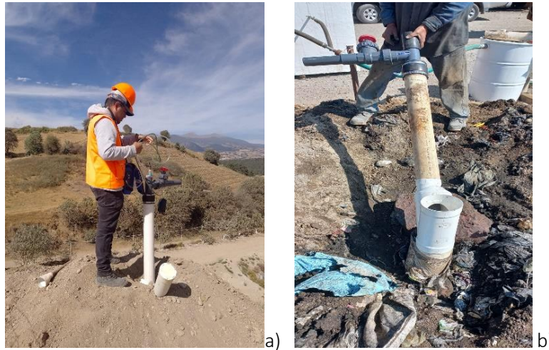
Figura 5. a) Lectura en salida vertical. b) Colocación de ACCU-FLO en Derivación Y.
