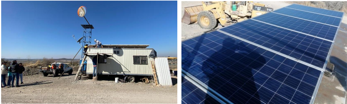
Figura 2. Caseta de cobro y supervisión inicial de los residuos, y paneles solares en “La Escombrera” en León, México.
