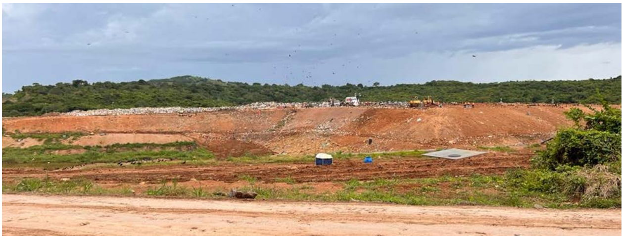
Figura 1. Vista general del Vertedero Controlado El Diamante
