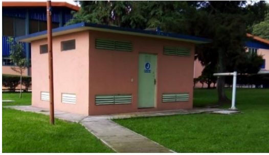
Figura 1. Edificio para almacenaje temporal de RP
