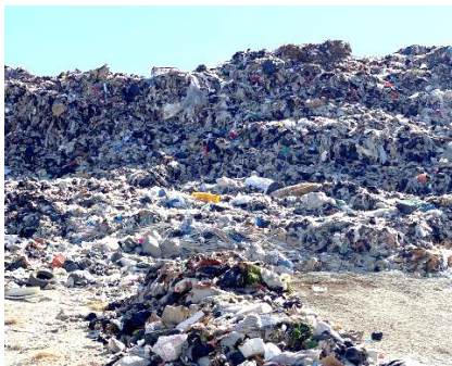
Figura 5a. Ejemplo de "balconeo" de residuos que crean taludes inestables y difíciles de corregir (empujar los residuos desde arriba, sin orden ni compactación). (Turcott, 2021).
