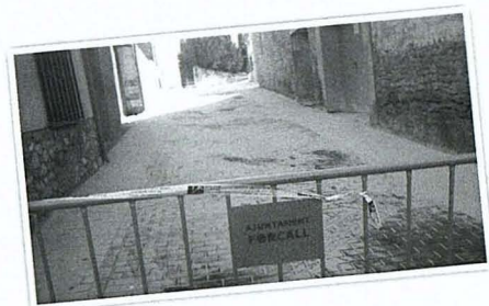
Adoquinado de la calle Tomás Salvador
