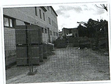
Ampliación de la residencia municipal.
