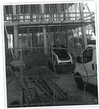
Las obras avanzan.
