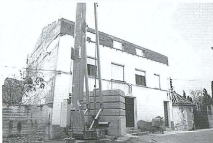
Obras a la "Casa del Metge"
