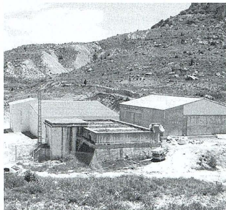
"Nuevo depósito de agua" Foto: Ismael Carbó.
