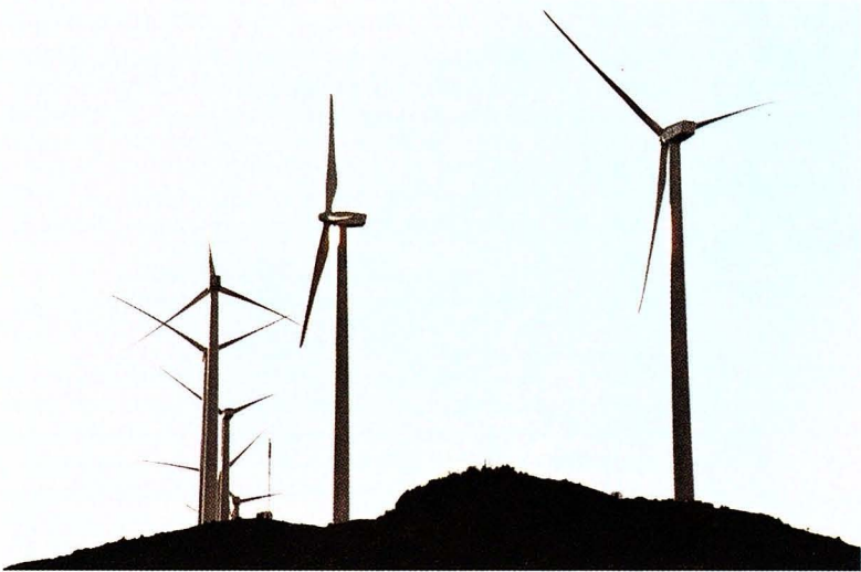
A la derecha observamos el primer aerogenerador que se instaló en el término municipal de Forcall, concretamente en el Parque Eólico de "Les Rafoies". Foto: Santi Aguilar.
