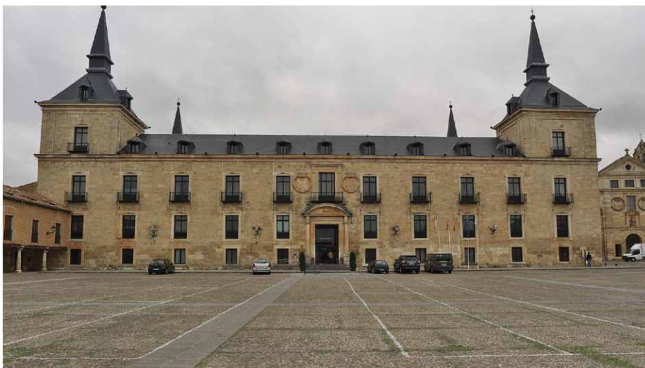
Imagen 3. Fachada principal del Palacio de Lerma hoy en día
