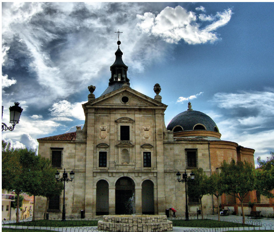
Imagen 4. Fachada principal del Convento de la Inmaculada Concepción de Loeches hoy en día
