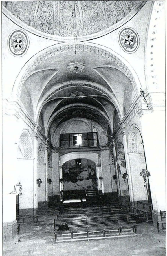
Nave de la iglesia del convento vista desde el altar.
