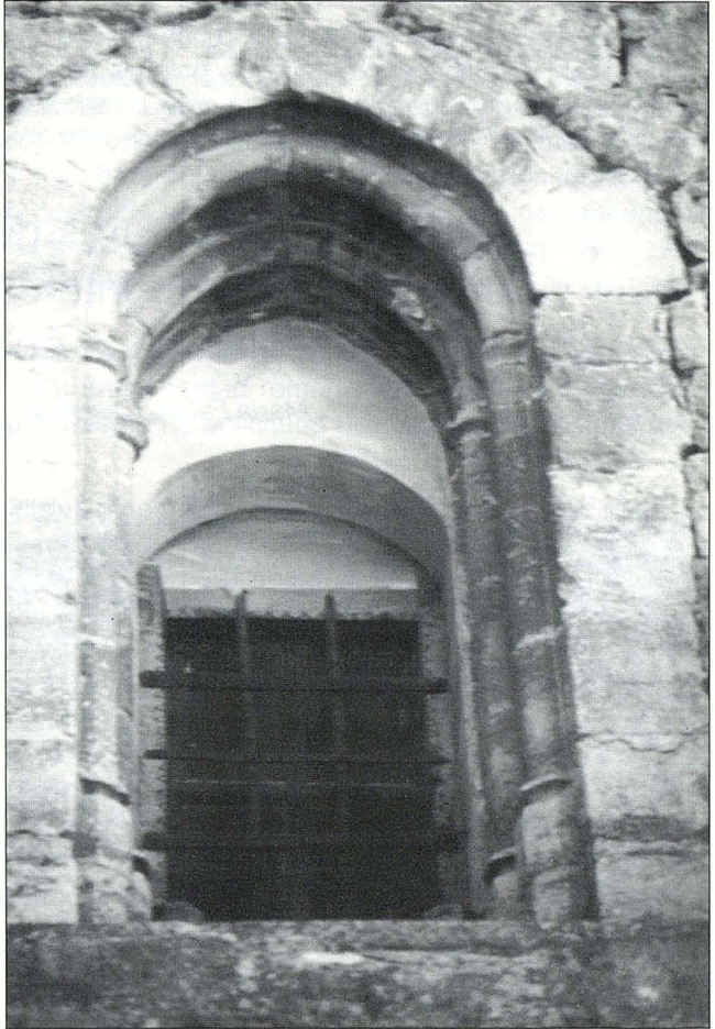
Detalle de una de las ventanas del ábside, probablemente la más antigua del templo gótico forcallano (fábrica de finales del siglo XIII o principios del XIV), por el estilo de su arquería, apenas ojival. Foto: Sergio Bordás.
