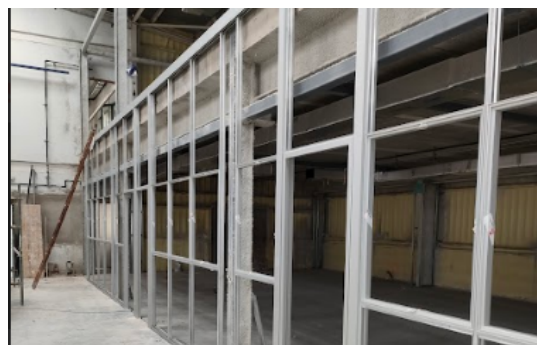
Imagen 107: Colocación de mamparas en la fachada del laboratorio. Estos trabajos los contrata directamente la propiedad por lo que lo único que se realiza es coordinar los trabajos con ellos para no molestarlos.
