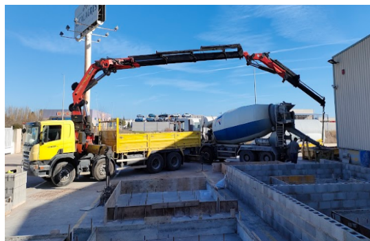
Imagen 57: Vertido de hormigón en los cubetos. Se realizan probetas a través de un laboratorio autorizado.
