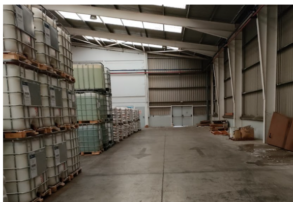
Imagen 11: Nave interior zona laboratorio
