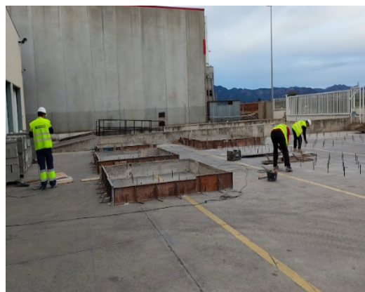
Imagen 37: Preparación de cubetos mediante encofrado recuperable y perforaciones en solera existente.
