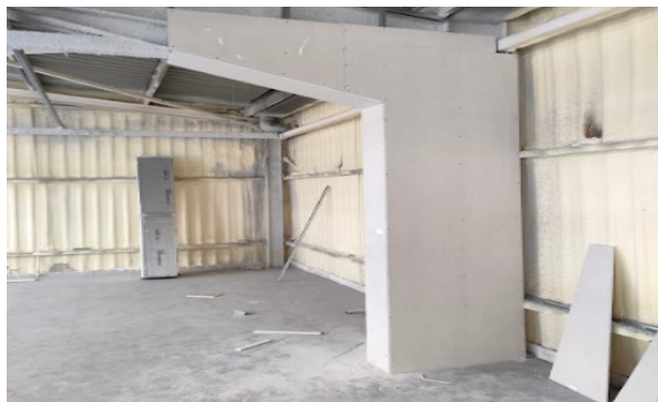
Imagen 116: Cajones de placa de yeso laminado con la perfilera correspondiente para esconder la estructura metálica de la nave.
