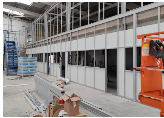
Imagen 115: Avances de la fachada de la zona de laboratorios y despachos.
