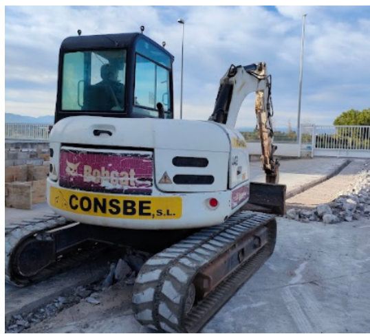
Imagen 59: Excavación de zanja para la canalización de red de aguas fecales de los aseos de la nave.
