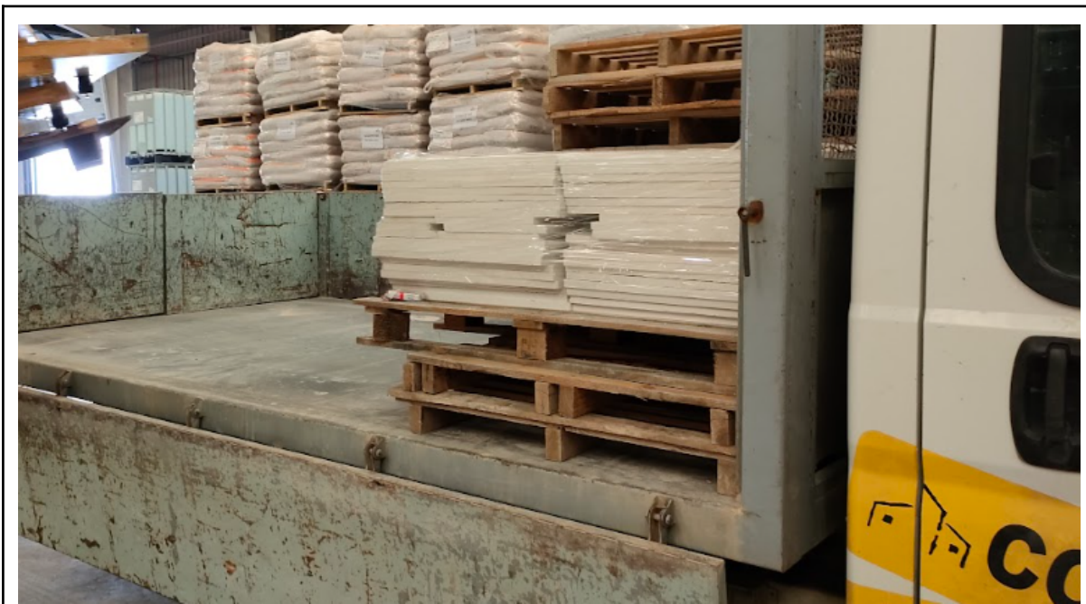
Imagen 23: Paletización y transporte de techo desmontable
