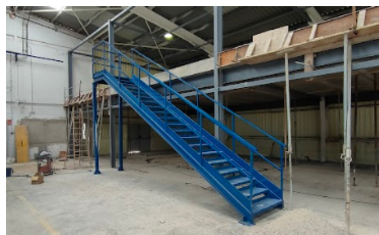
Imagen 93: Colocación de escalera para acceso a primera planta de laboratorios.
