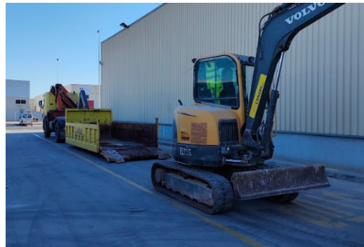
Imagen 77: Descarga de la mini-excavadora para realizar diversos trabajos en la obra.
