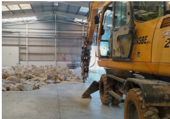
Imagen 40: Picado de solera mediante retroexcavadora en zona donde irán todas las canaletas de evacuación de aguas.
