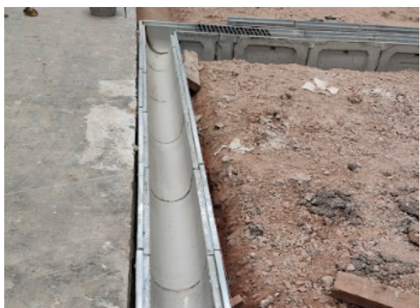
Imagen 96: Colocación de canaletas prefabricadas de gran resistencia preparadas para el tráfico pesado.
