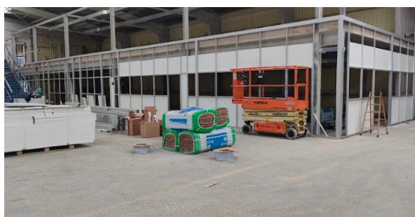
Imagen 112: Avances de la fachada de la zona de laboratorios. Se insiste a la empresa que está realizando los trabajos, en el orden y la limpieza para evitar accidentes entre nuestros o sus trabajadores
