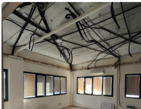
Imagen 42: Desmontaje de techo en las oficinas sin recuperación del material
