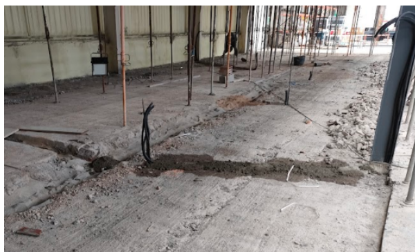
Imagen 90: Instalación de red de saneamiento e instalación eléctrica en planta baja de laboratorio.
