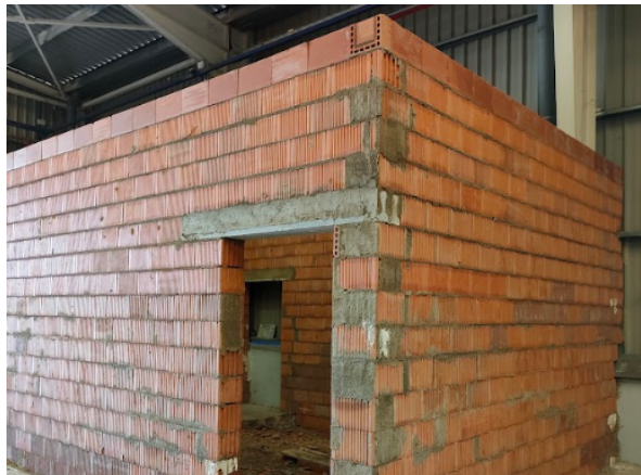
Imagen 52: Terminación de aseos en zona trasera de la nave con paredes de termoarcilla.
