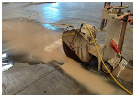
Imagen 39: Corte de solera en interior de la nave para posterior picado mediante retroexcavadora.
