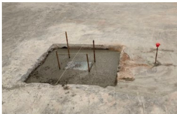
Imagen 48: Llenado de zapatas mediante hormigón y colocación de placas de anclaje para soldar pilares de la estructura del laboratorio.
