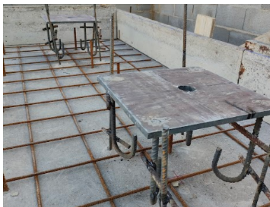
Imagen 55: Colocación de placas de anclaje perfectamente niveladas, soldadas a varillas de acero corrugado para evitar el desnivelado a la hora de verter el hormigón
