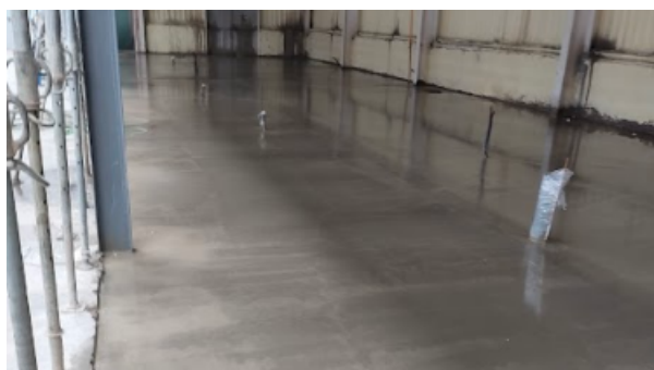
Imagen 92: Vertido de capa de mortero autonivelante en planta baja y primera planta para posterior colocación de pavimento.
