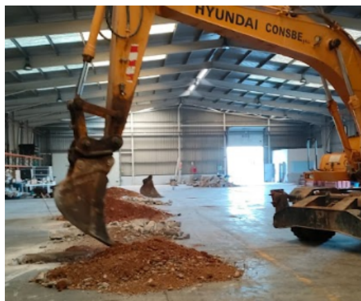
Imagen 43: Realización de zapatas para la posterior colocación de pilares en zona laboratorio
