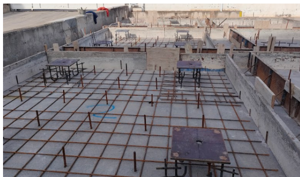
Imagen 56: A falta de la colocación de la malla electrosoldada en la parte superior, cubetos preparados para el vertido del hormigón..
