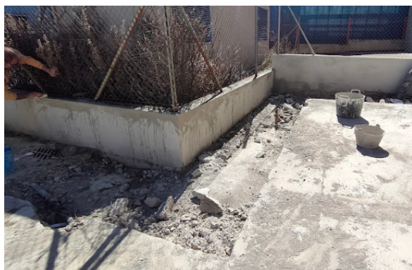
Imagen 110: Picado mediante compresor eléctrico en sitios donde la máquina no puede acceder para la realización de zanjas para evacuación de aguas pluviales de la nave,
