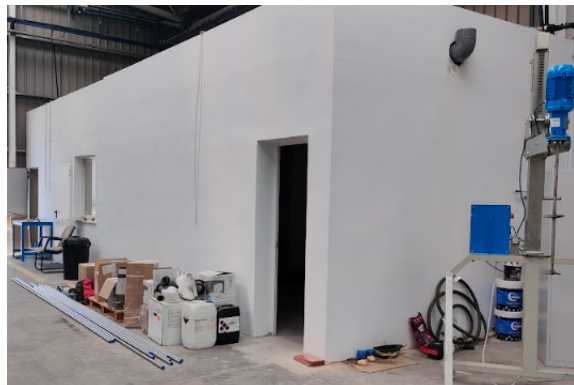
Imagen 121: Aseos y vestuarios zona nave
