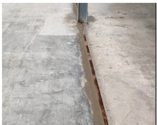
Imagen 97: Remates entre mortero autonivelante de la zona de laboratorio y solera existente de la nave.
