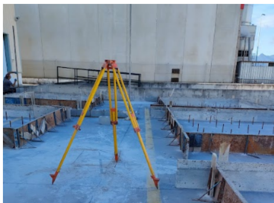
Imagen 36: Replanteo de niveles para la colocación de las placas de anclaje donde apoyan los depósitos. Encofrados para relleno de hormigón
