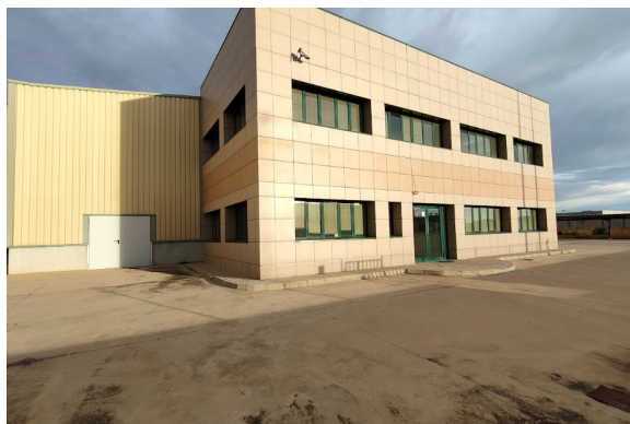
Imagen 7: Estado actual de la fachada de las oficinas y de la entrada principal
