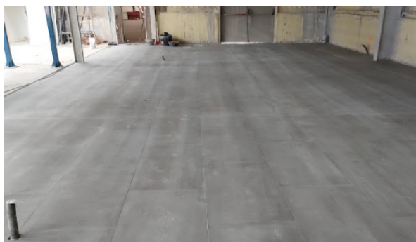
Imagen 106: Rejuntado de pavimento en planta baja de laboratorios. Tras pruebas de dos colores, se decide por parte de la propiedad colocar como material de rejunte el gris perla.
