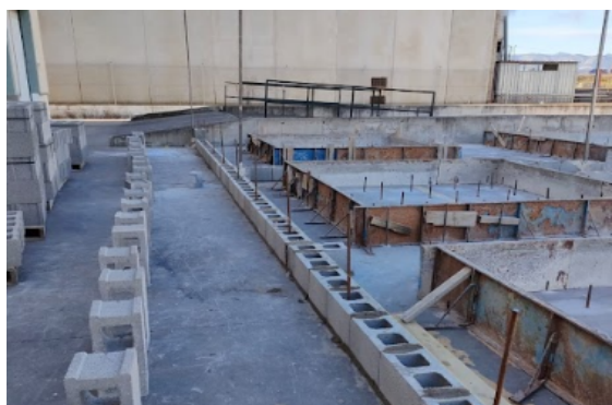
Imagen 38: Realización de paredes perimetrales ancladas a la solera para evitar derrumbes.
