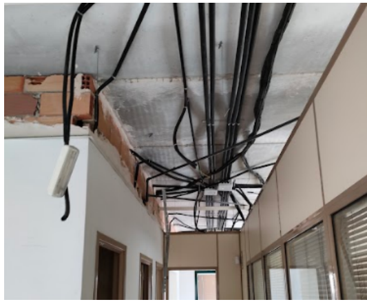
Imagen 53: Desmontaje de techos en la primera planta para clasificación de materiales y traslado a vertedero.
