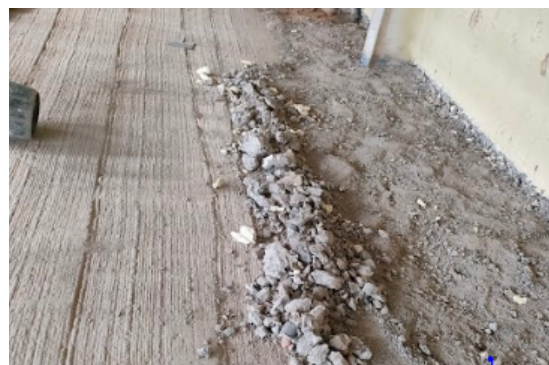
Imagen 91: Picado de solera mediante martillo eléctrico en zonas de difícil acceso para la fresadora mecánica.
