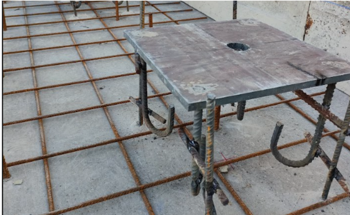
Imagen 18: Soldado de placas de anclaje
