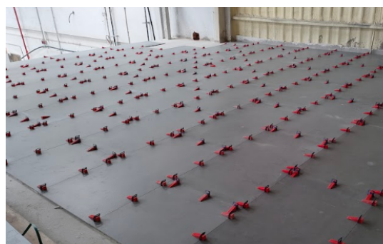
Imagen 109: Colocación de pavimento en la primera planta de laboratorios.
