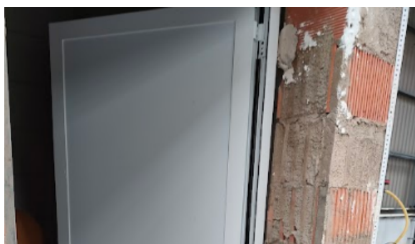
Imagen 108: Colocación y falcado de puertas en aseos.
