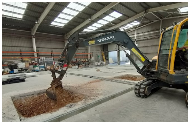
Imagen 114: Trabajos que no estaban contemplados en el presupuesto inicial, puesto que la propiedad y la ingeniería no lo habían completado.
