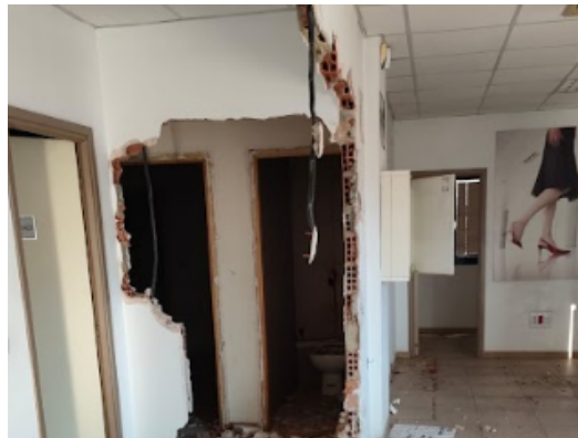
Imagen 41: Picado manual de paredes medianeras en oficinas con retirada de escombros a contenedor
