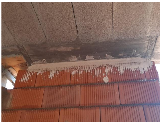
Fig 70. sellado de juntas con yeso.
