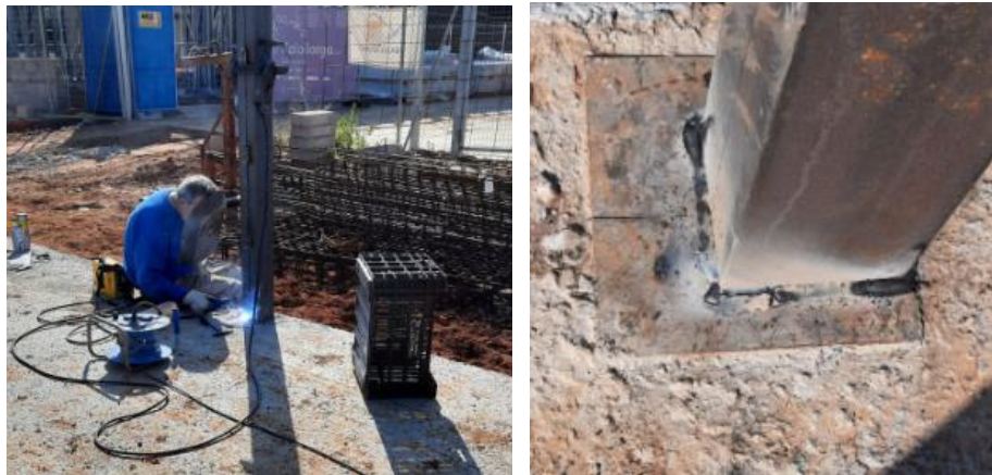
Fig 127. Soldadura del pilar metálico a la placa de anclaje.
