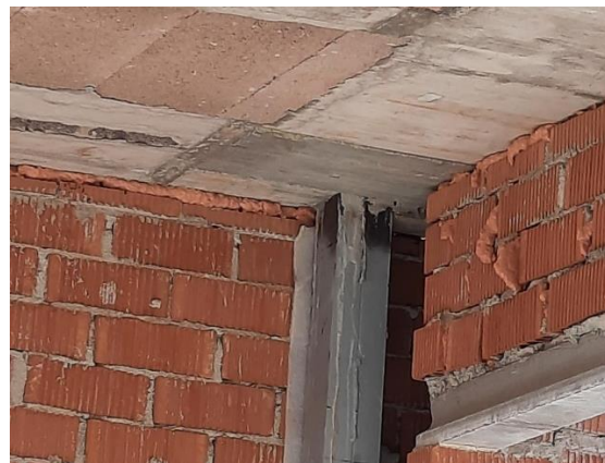
Fig 71. sellado de juntas con espuma de poliuretano
