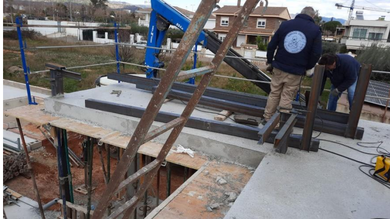
Fig 138. Soldadura de las vigas metálicas.
