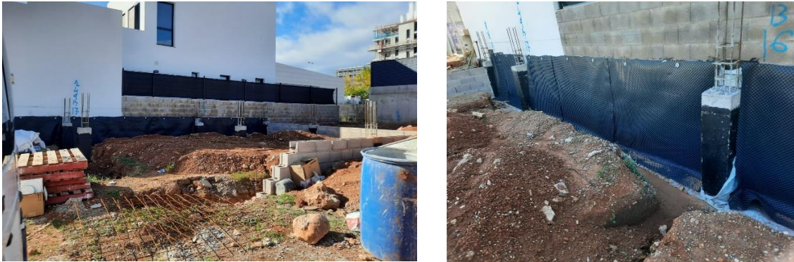
Fig 96. Estado de la obra al inicio del seguimiento.
