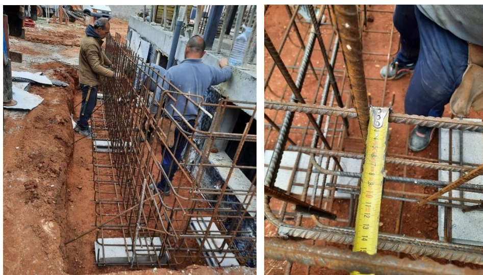
Fig 136. Colocación de la armadura del patio.
