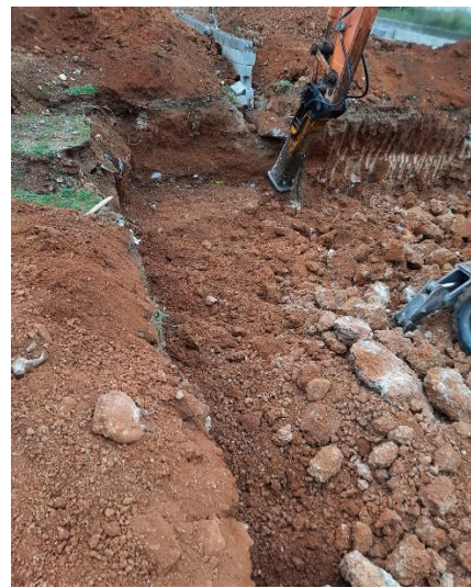
Fig 25. Excavación del sótano. (Terreno de arcilla combinada con costra de roca de poco espesor)
