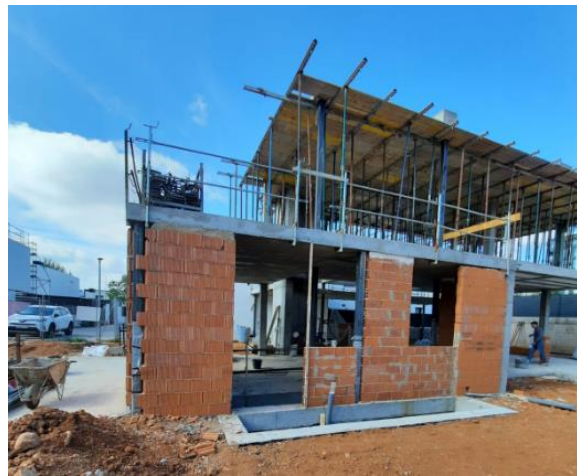
Fig 69. Ejecución de las fachadas.
