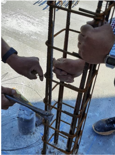
Fig 61. Armadura del pilar.
