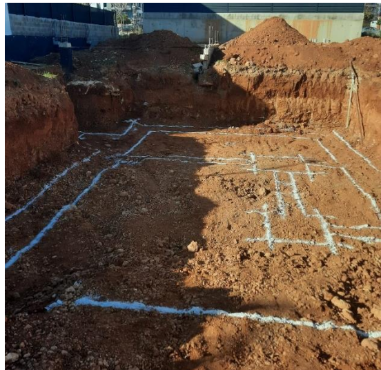
Fig 101. Replanteo de la cimentación.
