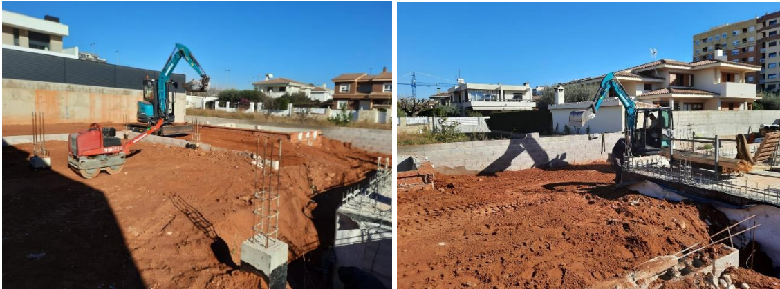
Fig 121. Nivelación del terreno.
