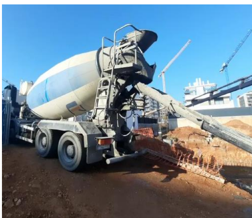
Fig 106. Llegada de la hormigonera.
