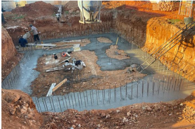
Fig 110. Estado final de la cimentación.
