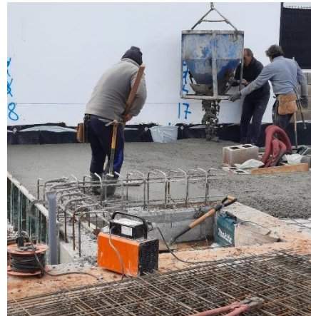
Fig 125. Ejecución de la solera Planta Baja (impermeabilización y hormigonado).
