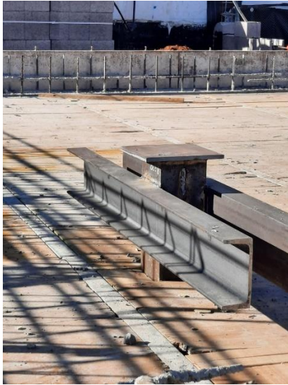
Fig 59. Unión de 2 perfiles UPN en los pilares.
