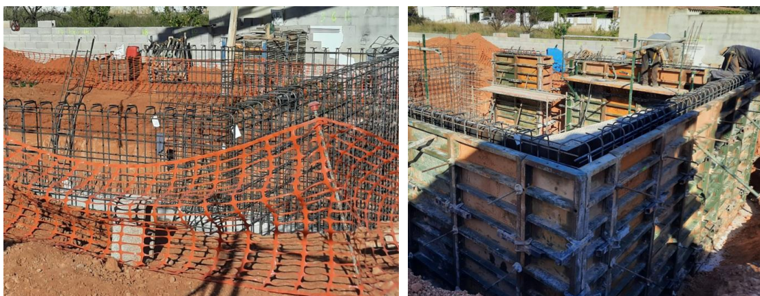
Fig 113. Colocación de la armadura y el encofrado metálico de los muros flexoresistentes.
