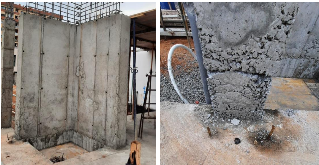
Fig 134. Desencofrado de los pilares y muros de hueco de ascensor.
