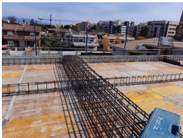
Fig 148. Distribución de vigas de acero corrugado.
