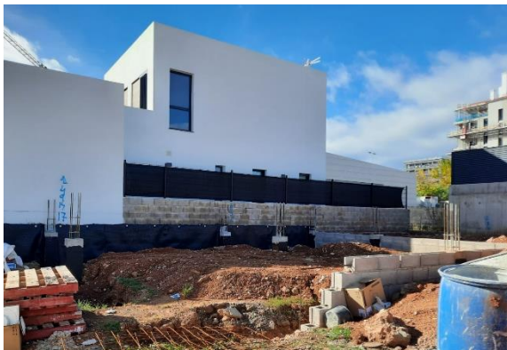
Fig 33. Primera parte de cimentación ejecutada.
