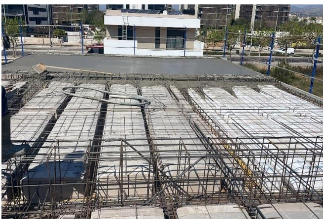
Fig 150. Hormigonado forjado planta cubierta.
