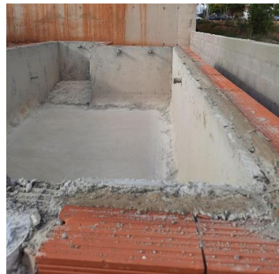
Fig 34. Ejecución de la piscina
