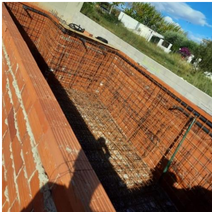
Fig 97. Armadura de la piscina.
