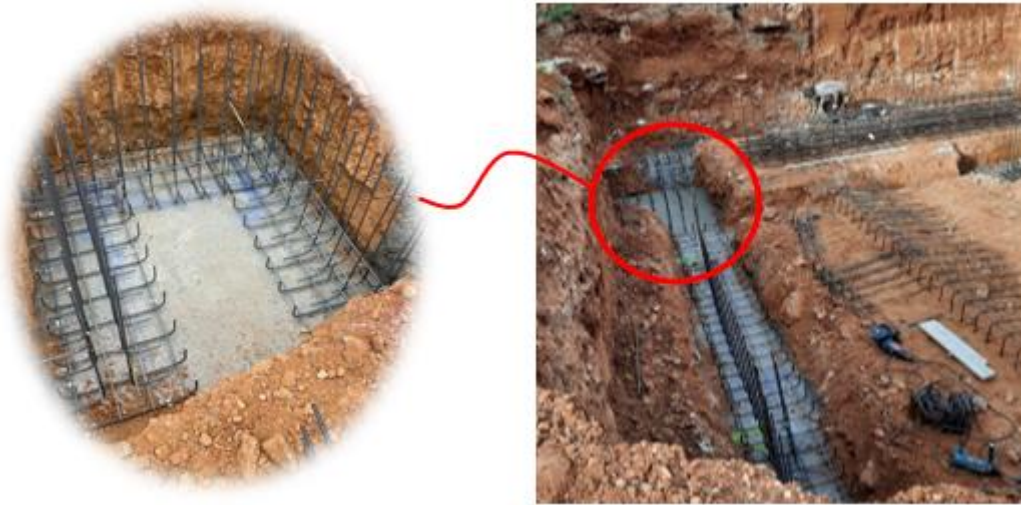
Fig 104. Armadura del foso de ascensor.
