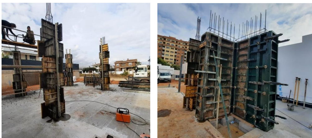
Fig 130. Encofrado metálico y hormigonado de los pilares y muros del hueco de ascensor.
