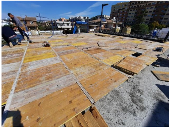
Fig 140. Encofrado de madera del forjado.
