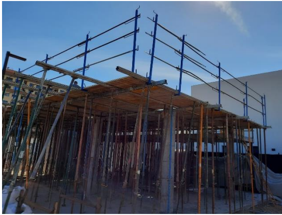
Fig 140. Encofrado de madera del forjado.
