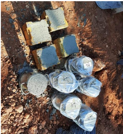
Fig 109. Probetas de hormigón.
