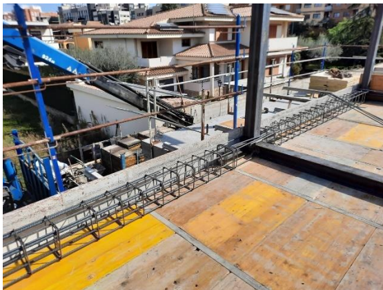
Fig 143. Distribución de los pilares y vigas metálicas y de acero corrugado.
