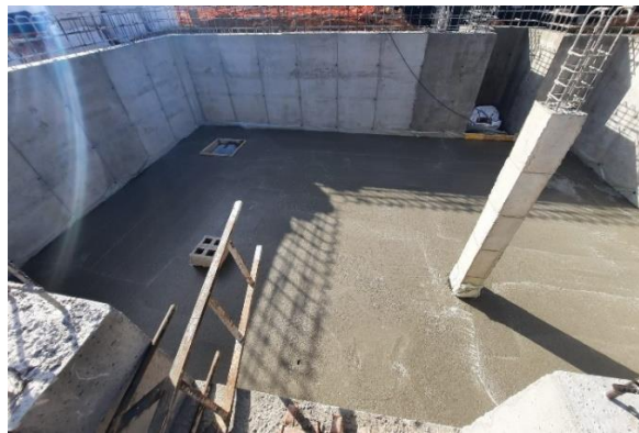
Fig 118. Solera ejecutada.
