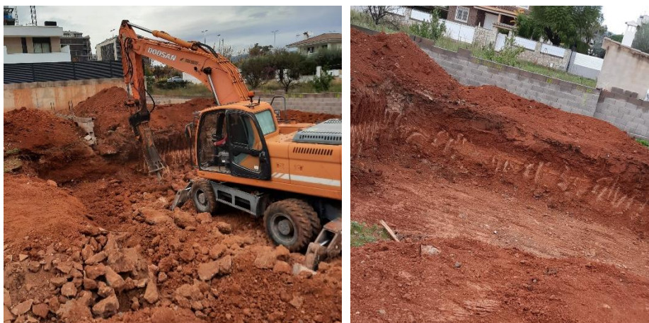
Fig 99. Excavación del sótano.
