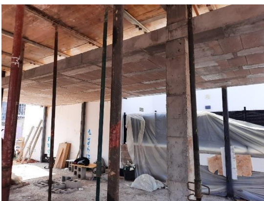
Fig 149. Desencofrado del forjado bajo planta 1°.
