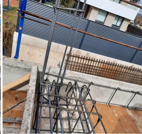
Fig 145. Arranque del pilar.
