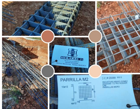
Fig 103. Armadura/etiquetas de armadura de la cimentación.
