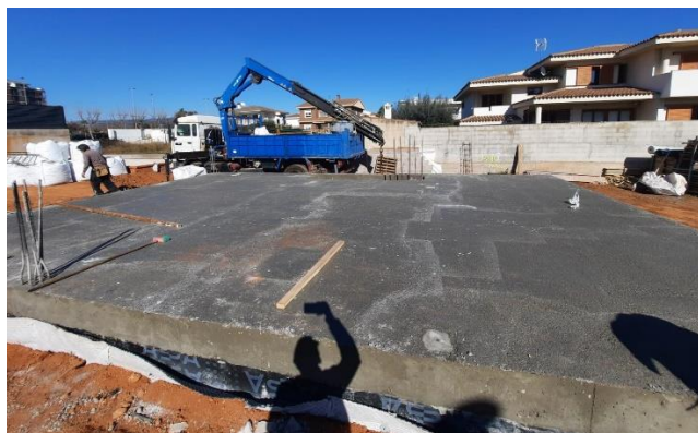
Fig 122. Nivelación del terreno.
