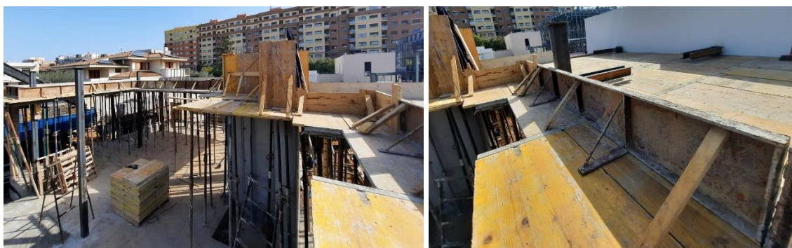
Fig 135. Encofrado de las cubiertas de la 1ª planta.
