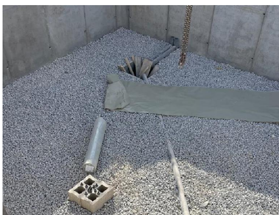
Fig 54. colocación de la lámina Polietileno transparente.
