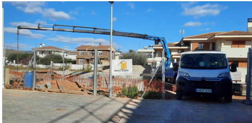
Fig 87. Vallado perimetral de la parcela.
