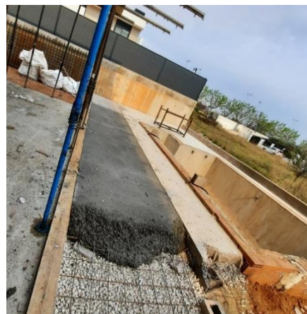
Fig 151. solera de hormigón.
