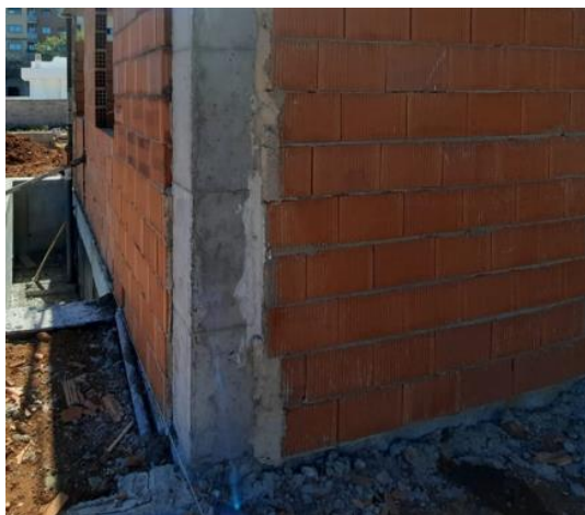
Fig 155. Reconstrucción Fachada Este (Cocina).
