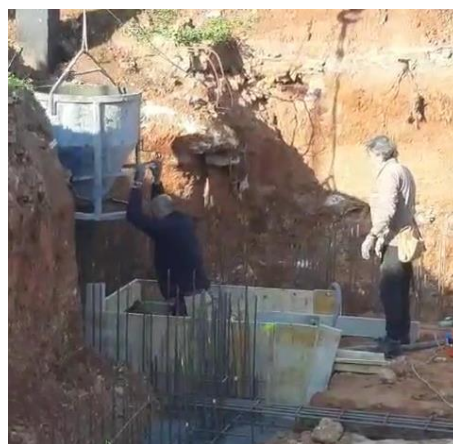
Fig 107. Hormigonado con cubilote.
