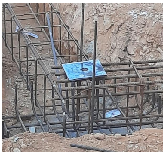
Fig 112. Placa de anclaje del pilar metálico.
