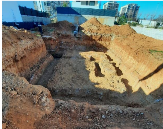
Fig 102. Excavación de la cimentación.
