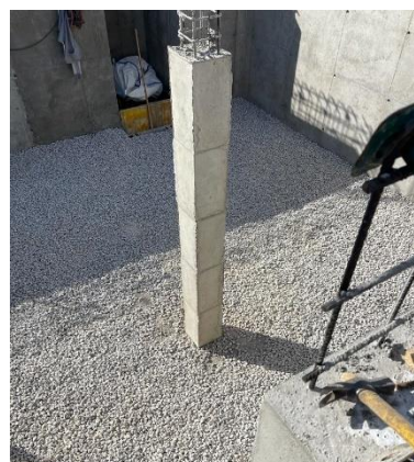
Fig 55. Base compacta de zahorras.
