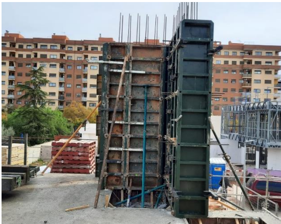
Fig 146. Encofrado metálico de los pilares y muros del hueco de ascensor.
