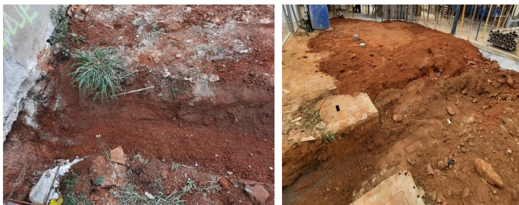
Fig 137. Abertura de zanjas.
