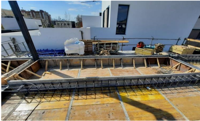
Fig 141. Encofrado del hueco de escaleras.
