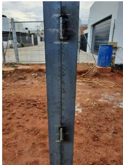
Fig 60. Soldadura a tope de los pilares.
