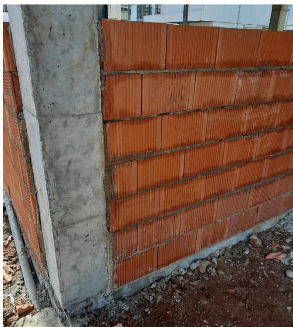
Fig 154. Fachada Este (Cocina).
