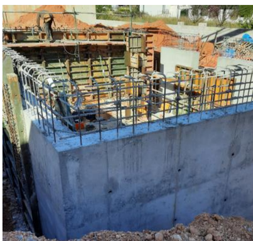
Fig 116. Desencofrado de los muros del sótano.
