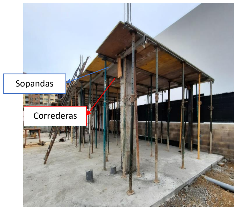
Fig 133. Encofrado del forjado.
