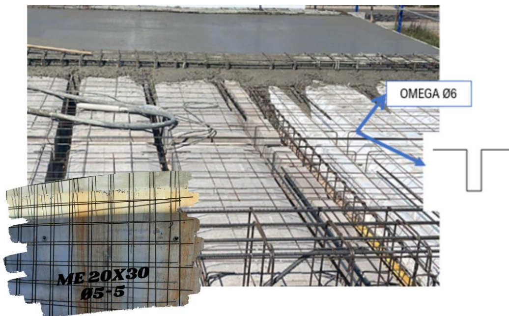
Fig 66. Forjado planta cubierta.
