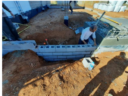
Fig 124. Encuentros entre cimentación y muros.
