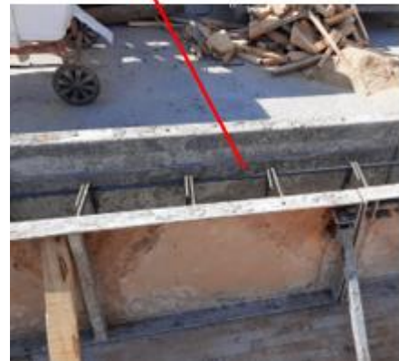
Fig 142. marcaje del canto de forjado.
