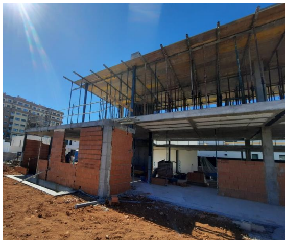
Fig 156. Construcción de paredes.
