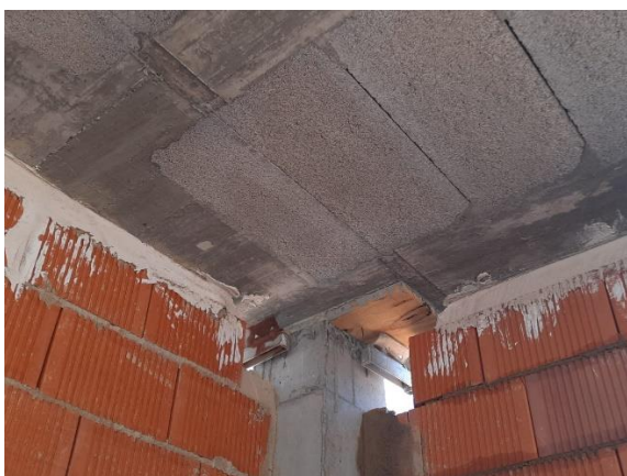
Fig 157. Sellado de juntas con yeso.
