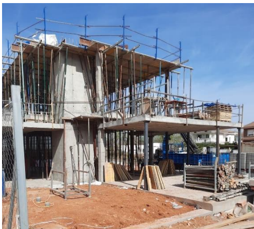
Fig 147. Encofrado de forjado planta cubierta.
