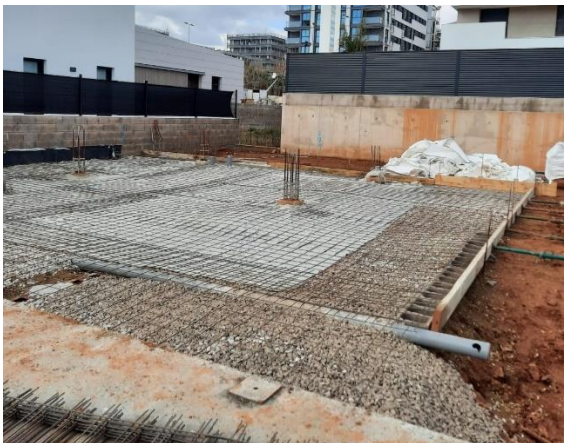
Fig 125. Ejecución de la solera Planta Baja (impermeabilización y hormigonado).
