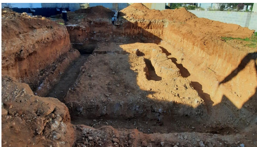
Fig 46. Excavación de la cimentación.
