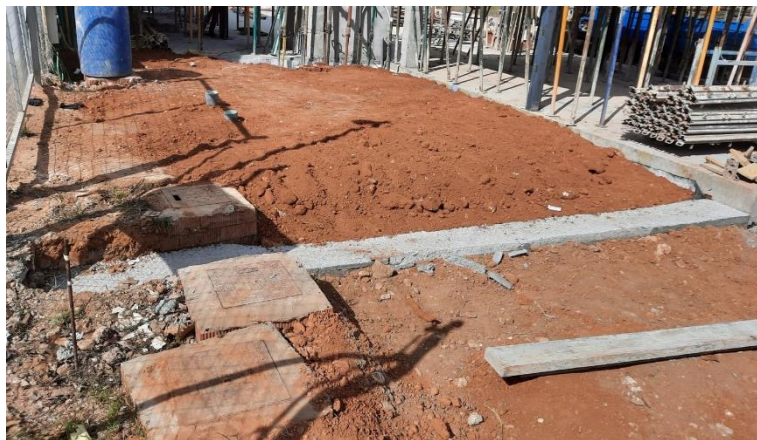
Fig 139. Arranque del muro perimetral de la parcela.
