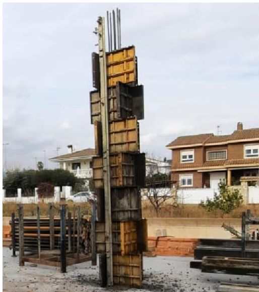
Fig 57. Encofrado metálico del pilar. metálicas.
