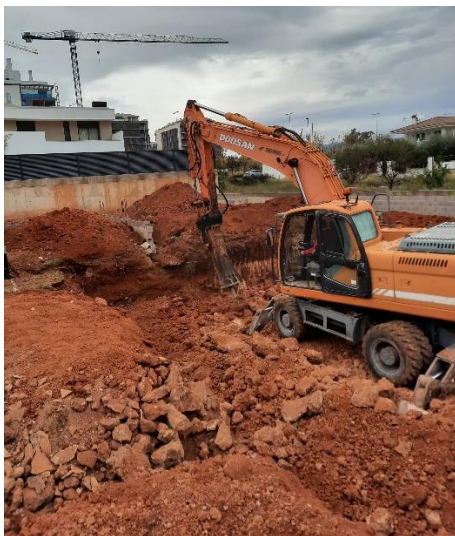
Fig 25. Excavación del sótano. (Terreno de arcilla combinada con costra de roca de poco espesor)
