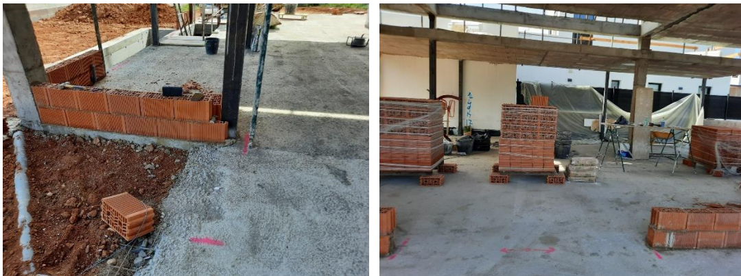
Fig 153. Replanteo de fachadas y huecos.
