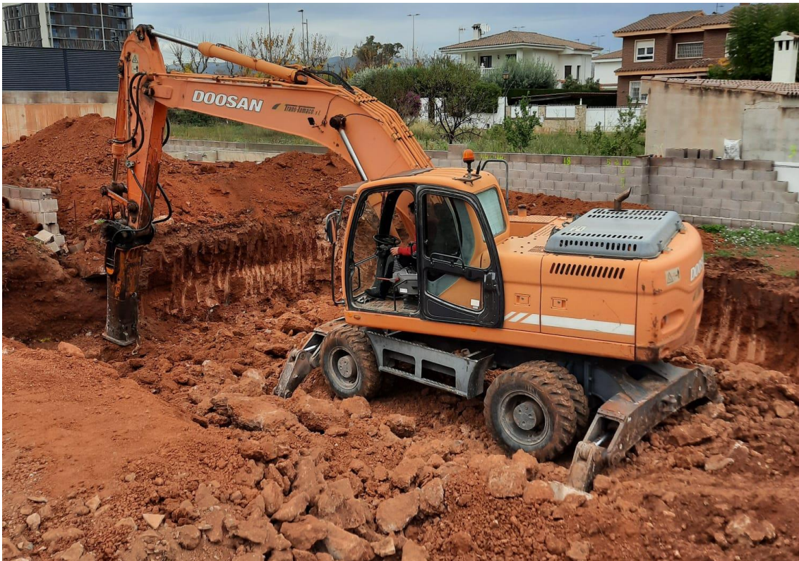
Fig 44. Excavación con retroexcavadora.
