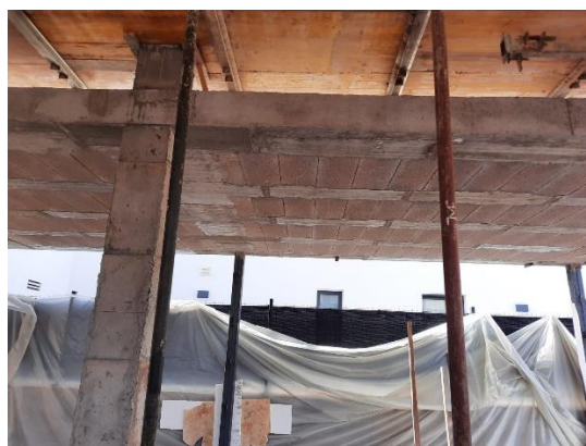
Fig 149. Desencofrado del forjado bajo planta 1°.
