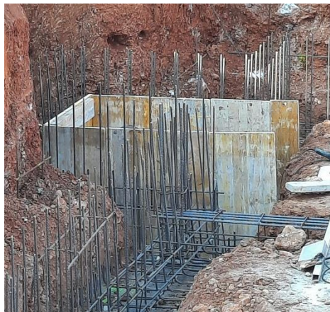
Fig 105. Encofrado del foso de ascensor.
