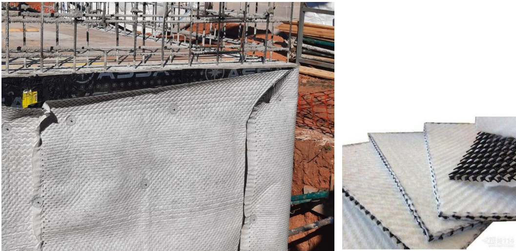
Fig 51. Geocompuesto tipo sándwich.
