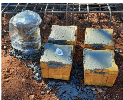
Fig 115. Probetas de control de calidad.
