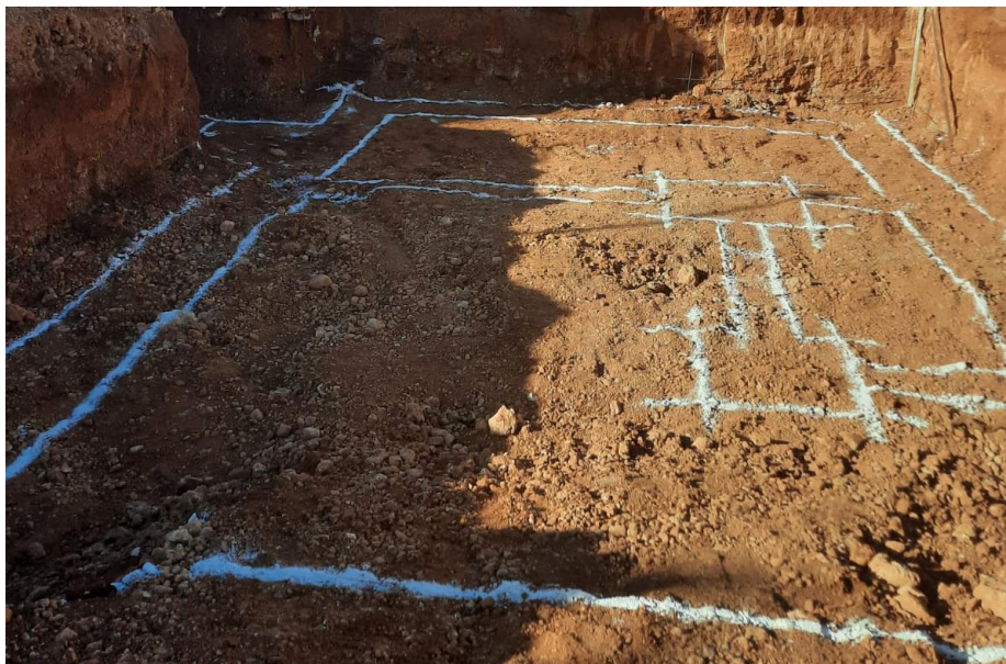
Fig 45. Replanteo de la cimentación.
