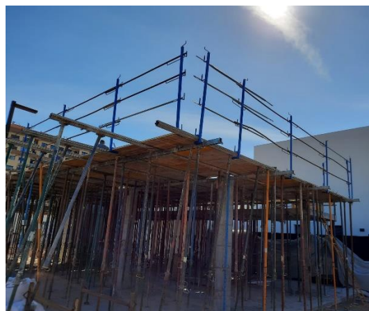
Fig 62. Encofrado de madera del forjado.
