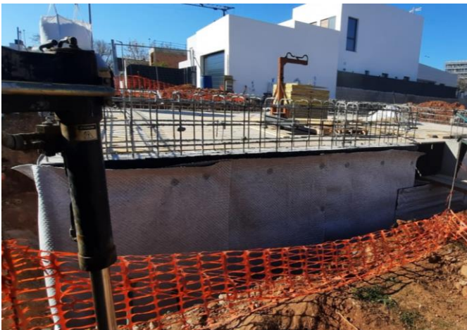
Fig 119. impermeabilización y drenaje.
