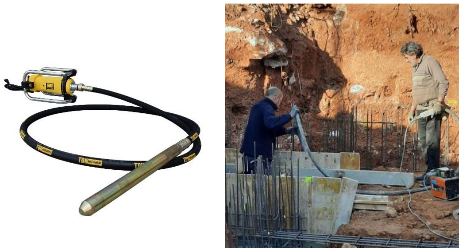
Fig 72. Vibrador eléctrico. (Compactación del hormigón) Fuente: www.raiker.com
