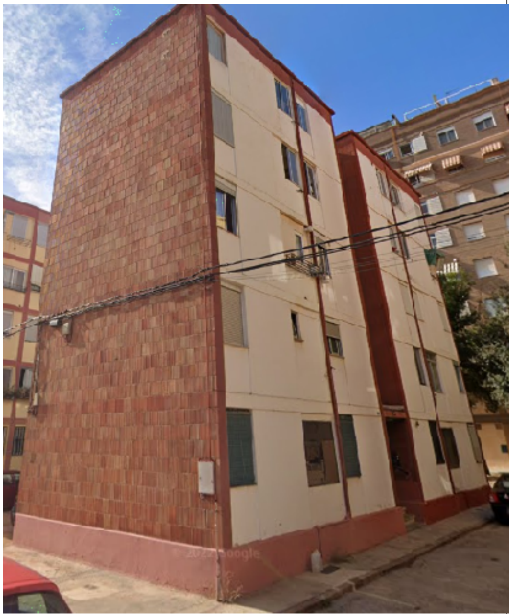
Fotografía de la fachada principal
