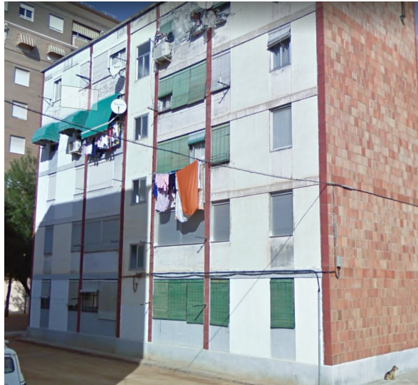
Figura 14. Foto edificio fachada trasera.
