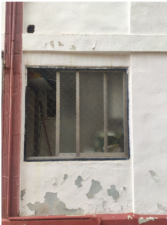
Figura 21. Ventanas de aluminio sin Rotura de Puente Térmico. Fachada Trasera.
