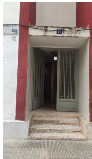
Figura 18. Puerta acceso principal.
