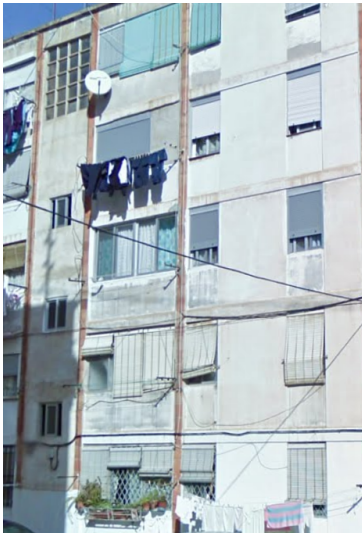
Figura 22. Foto fachada trasera
