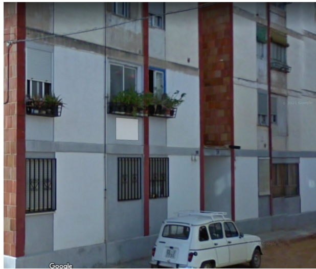
Figura 23. Foto fachada principal
