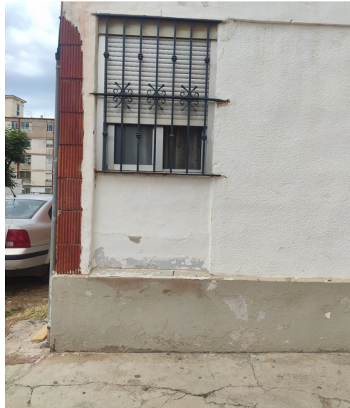
Figura 20. Ventanas de aluminio sin Rotura de Puente Térmico. Fachada Delantera.
