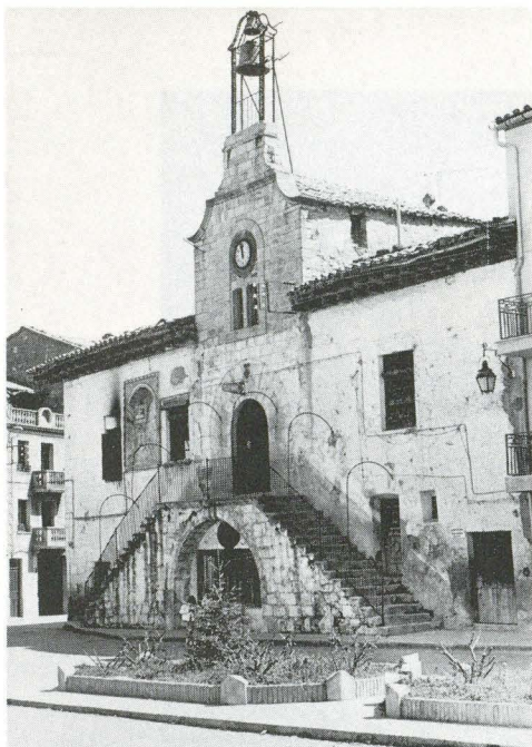
Fachada de la antigua Casa de la Vila en vías de restauración. De principios del s. XVII. Elemento original, sus escaleras voladizas exteriores. Arch. J. Eixarch
