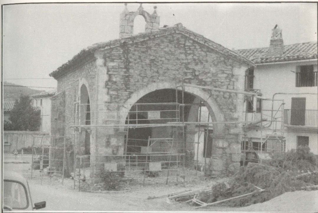
Ermita de St. Lluís.- En plena labor de restauración.
