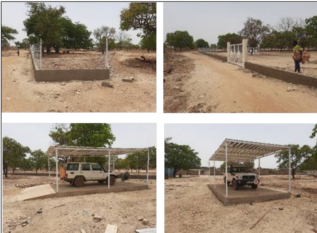
Figura 6. Trabajos de infraestructura en la sede del Comité provincial de la CRBF en Sapouy
