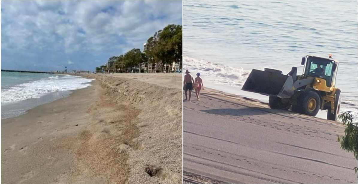
Figura 46. A la izquierda, escarpe originado por erosión de la berma. A la derecha, una pala excavadora intentado eliminar los escalones a primera hora de la mañana.
