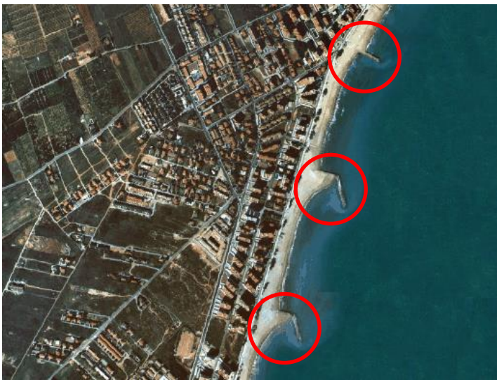
Figura 14. Foto aérea de la playa del Heliópolis en 1997. Rodeados de un círculo rojo los nuevos espigones.
