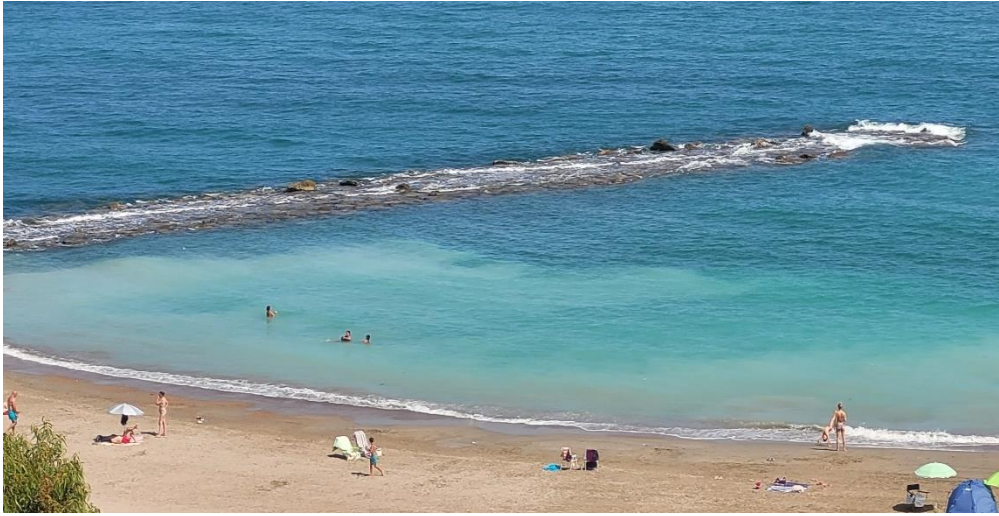
Figura 51. Agua con sedimentos a barlovento. Espigón Norte de la célula E.
