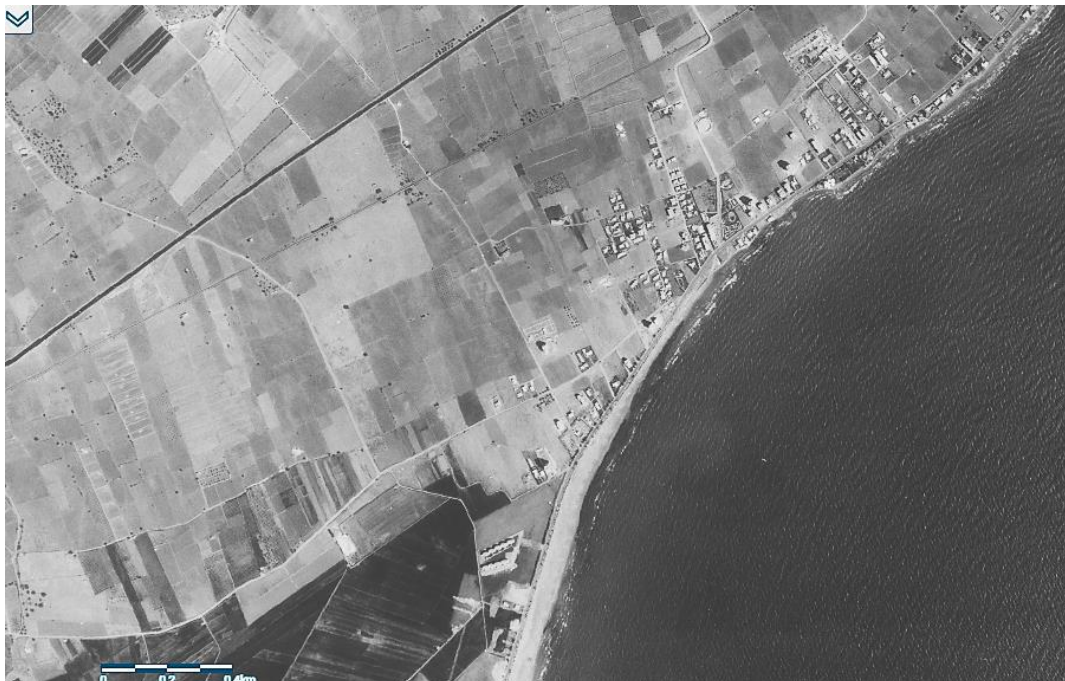
Figura 10. Foto aérea de 1967 de la zona meridional de Els Terrers y la septentrional del Heliópolis, donde se puede apreciar el comienzo del boom inmobiliario. En la zona inferior se pueden distinguir los apartamentos Heliópolis y La Panderola, construidos a escasos metros de los campos de arroz, en color más oscuro.
