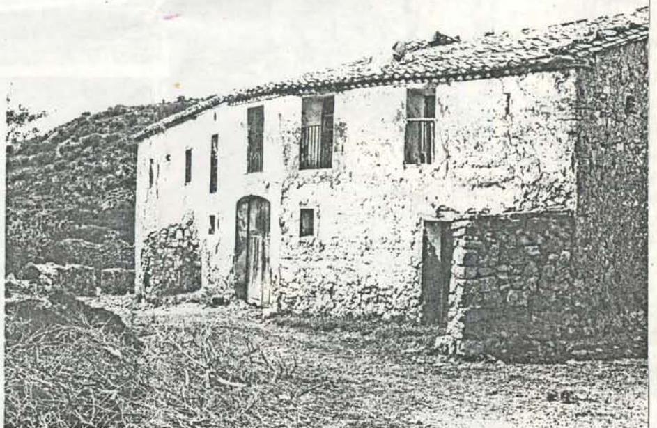
Fachada Este. Obsérvese el cambio de dirección de la casa añadida. Bóveda de cubrición del pozo adosado a la fachada de la casa antigua.
