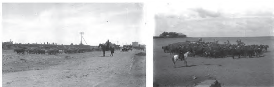
Fig. 3. El trabajo de la tropería en La Tablada Nacional. En la de la izquierda se aprecia el Camino de las Tropas -empedrado- y al fondo la fachada del edificio principal. El grupo de obreros del fondo está instalando una de las balanzas industriales. SODRE - Archivo Nacional de la Imagen y la Palabra.
