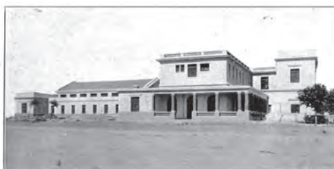
Fachada lateral oeste del edificio nuevo
