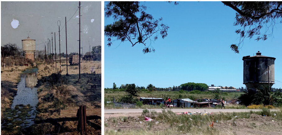
Fig. 9. Fases de arruinamiento y reutilización de la estación de ferrocarril de La Tablada. Izquierda, estación abandonada a mediados de los años 80. Derecha, vida cotidiana del nuevo asentamiento Las Vías. Se observan algunas estructuras precarias junto al depósito de agua y al fondo el edificio principal de La Tablada Nacional. Archivo de la Comisión de Sitio de Memoria.
