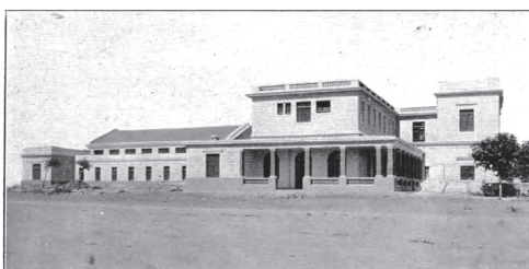
Fachada lateral oeste del edificio nuevo
