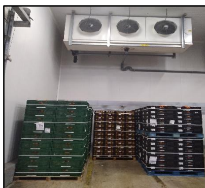
Imagen 5: Imagen de la cámara de preenfriado (Imagen de la Cooperativa San Isidro de Benicarló).
