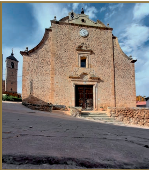
Fachada de la parroquia de Torrehermosa
