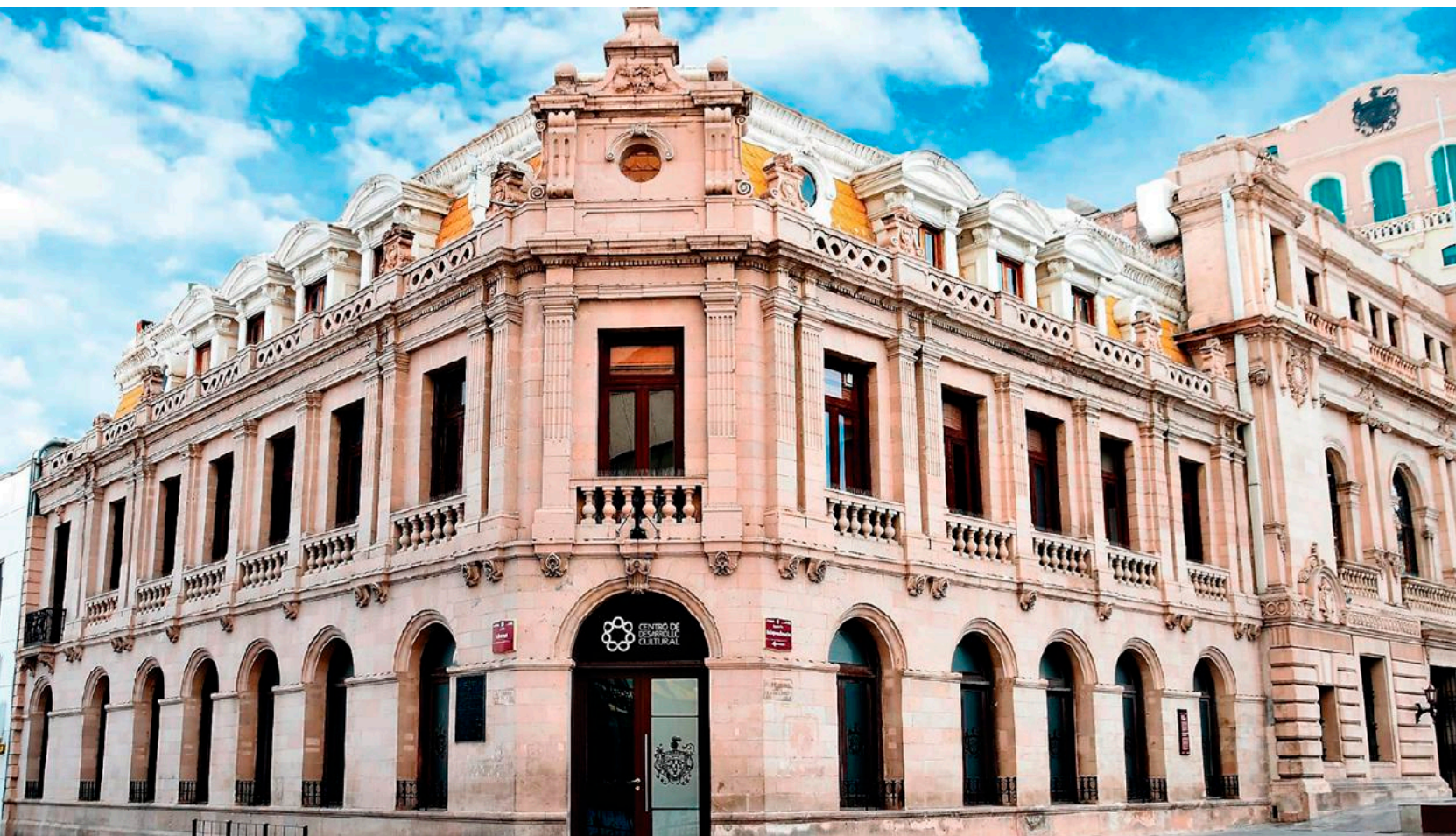
Fachada exterior del CDC – Centro de Desarrollo Cultural. 2021. Fotografía: Joss Polanco.
