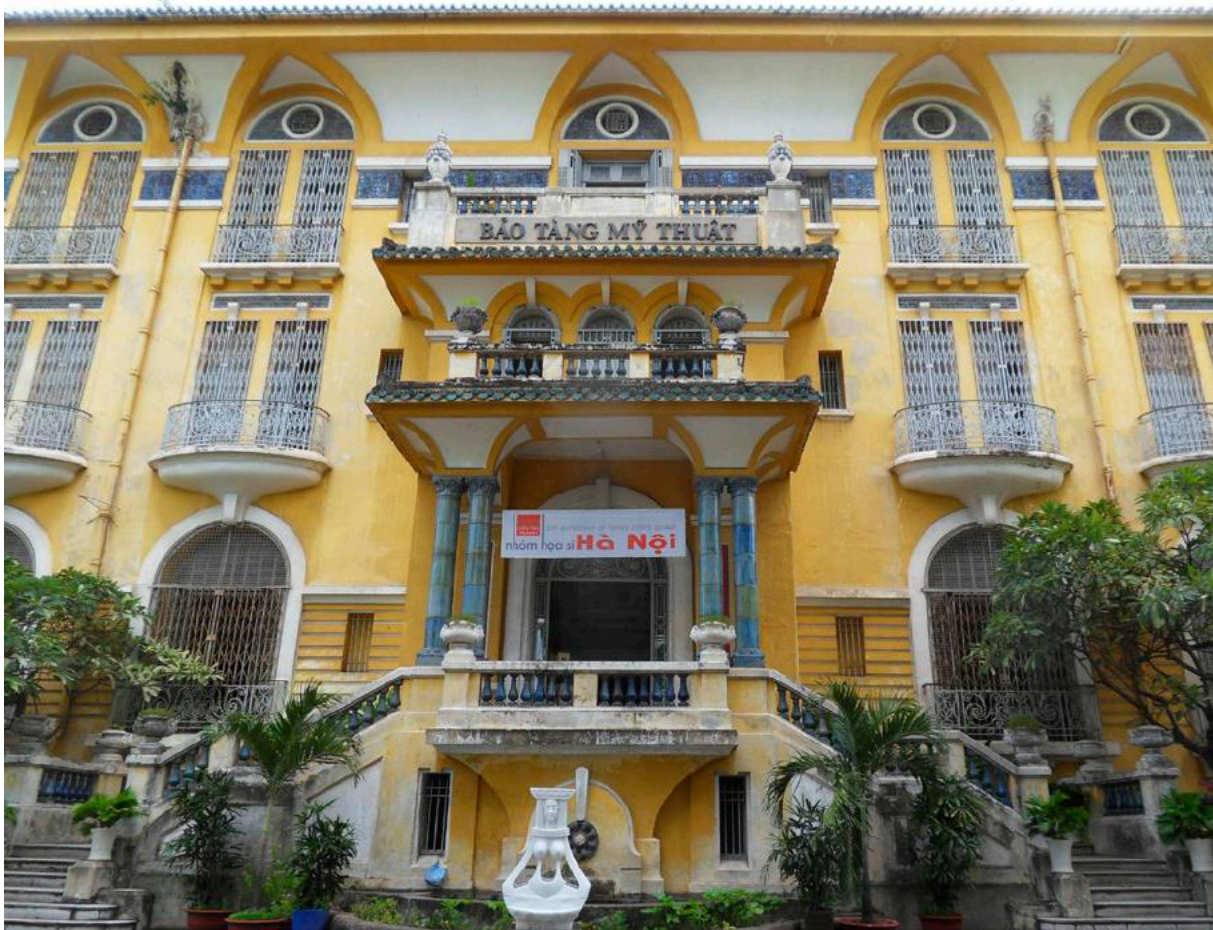
Fachada principal del Museo de Bellas Artes de Ciudad Ho Chi Minh, antes de su restauración. Se aprecia el recubrimiento de cal hidráulica típica de edificios coloniales como este, construido entre 1925 y 1934. Fotografía de la autora.
