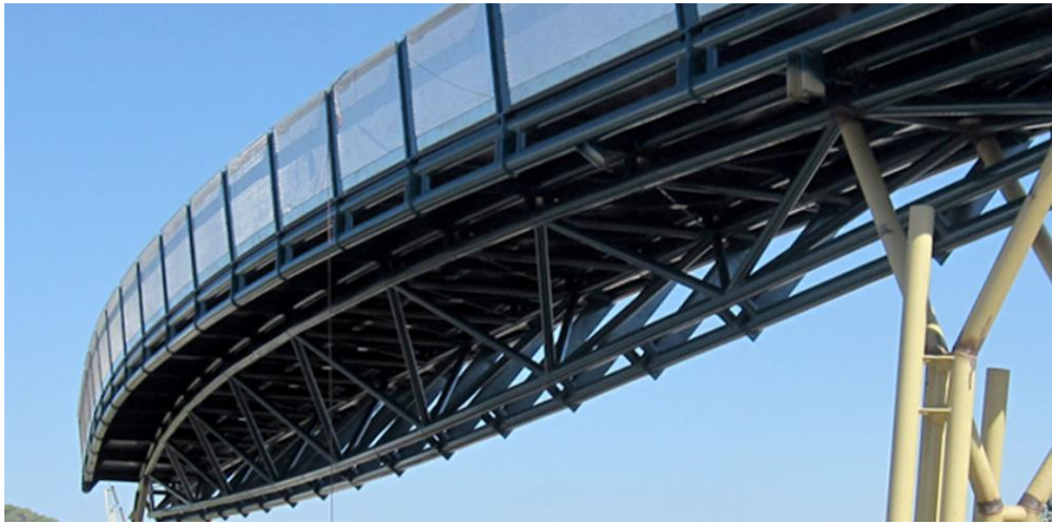
Imagen 6 - Pasarela construida con metal.
