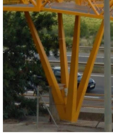
Imagen 5 - Pilar rampa este.
