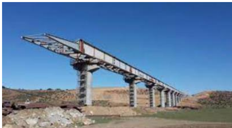
Imagen 13 – Pasarela de tipología de vigas y pórticos.
