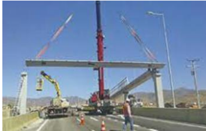
Imagen 9 - Pasarela construida con hormigón prefabricado.
