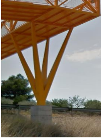
Imagen 4 - Pilar rampa Oeste.
