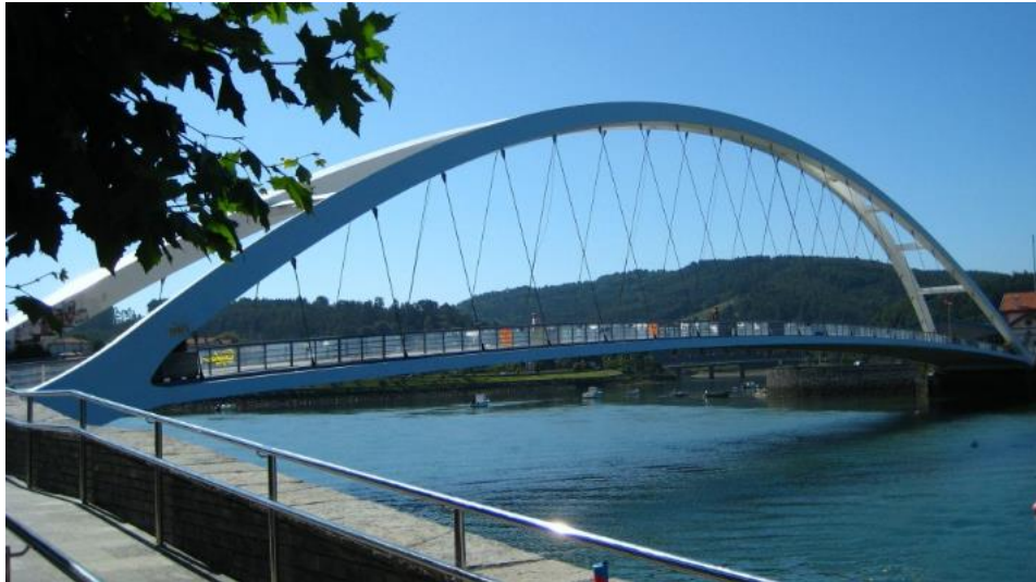
Imagen 14 – Pasarela de tipología de arcos.
