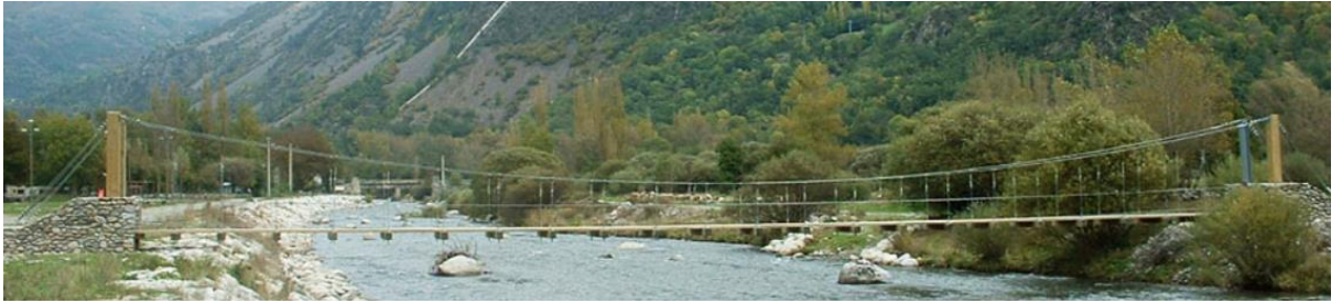
Imagen 11 – Pasarela de tipología colgante.
