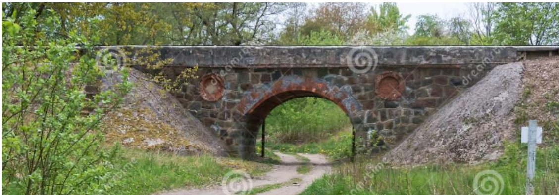
Imagen 7 - Pasarela construida con piedra.
