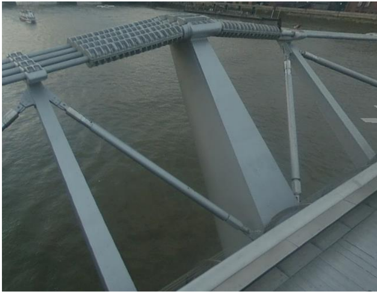
Imagen 17 – Dispositivos viscosos del Millennium Bridge.
