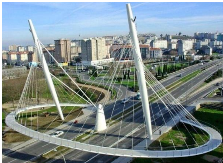
Imagen 12 – Pasarela de tipología atirantada.
