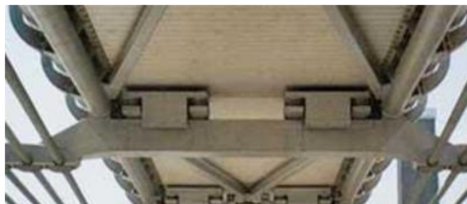
Imagen 18 – Amortiguadores de masa sintonizada del Millennium Bridge.
