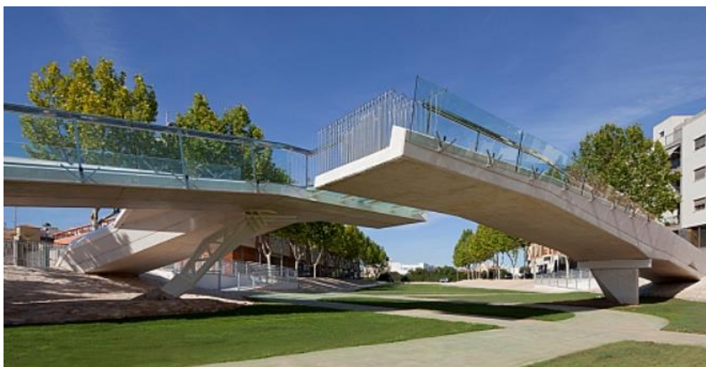
Imagen 8 - Pasarela construida con hormigón.
