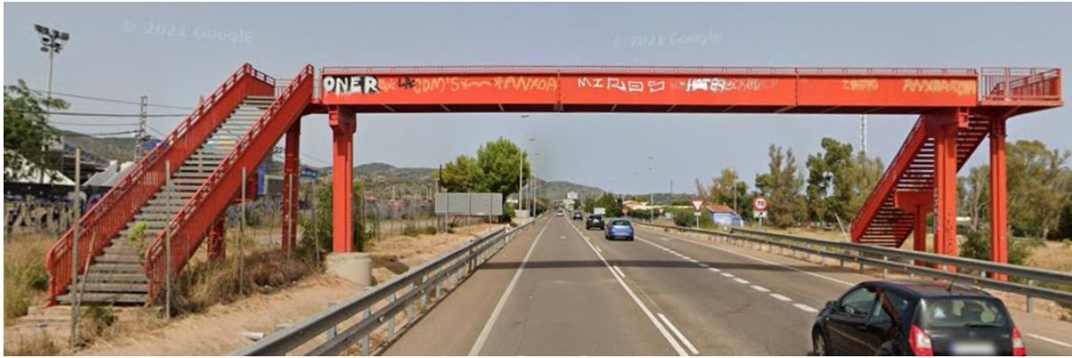
Imagen 16 – Pasarela peatonal situada en Benicasim, Castellón.
