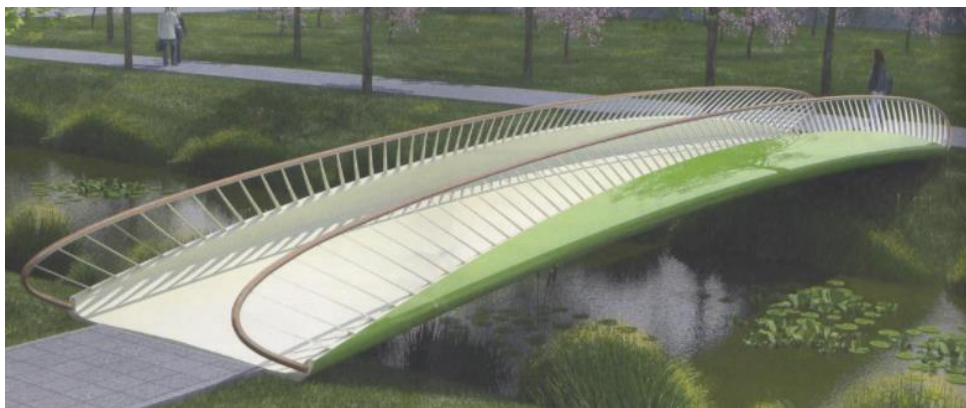
Imagen 10 - Pasarela construida con plásticos y fibras.
