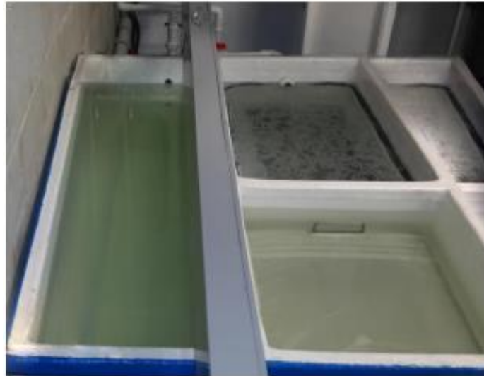
Figura 46. Tanque sedimentador de lodos. Fuente: Verlek
