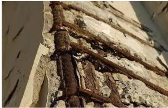
Figura 1.1. Problemas de corrosión en hormigón armado.
