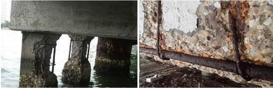
Figura 2.20. Ejemplos de corrosión en hormigón armado
