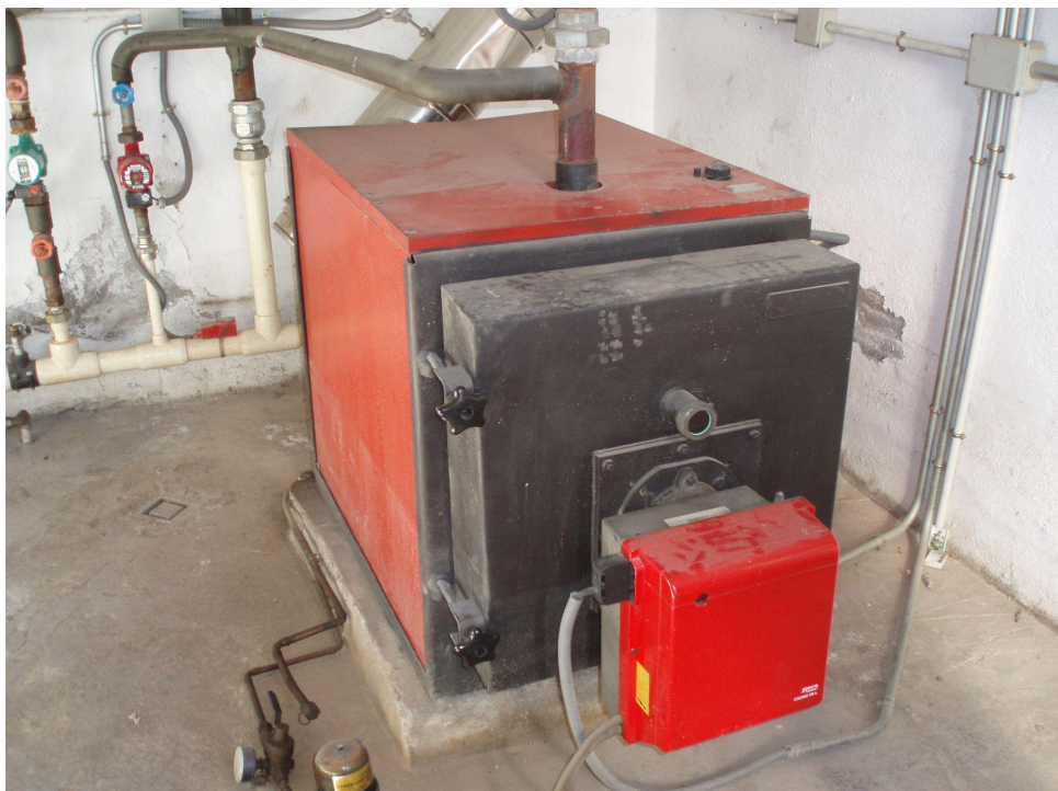
Imagen 8. Cuerpo y quemador de la caldera .
