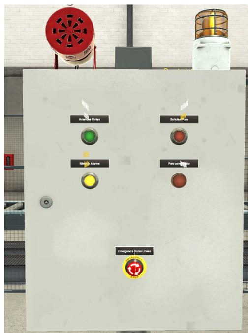
Figura 73: Pulsador de Silencio de Alarma activo (apaga alarma, mantiene luz)
