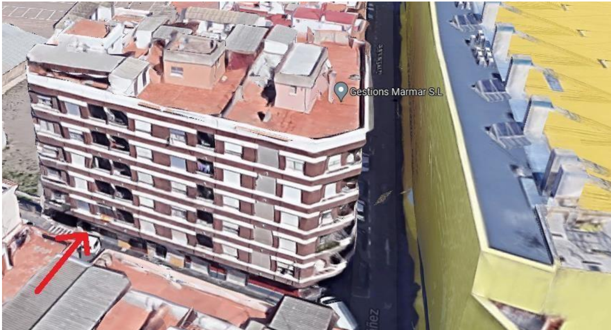
imagen 03. Vista isométrica del edificio. Google maps.
