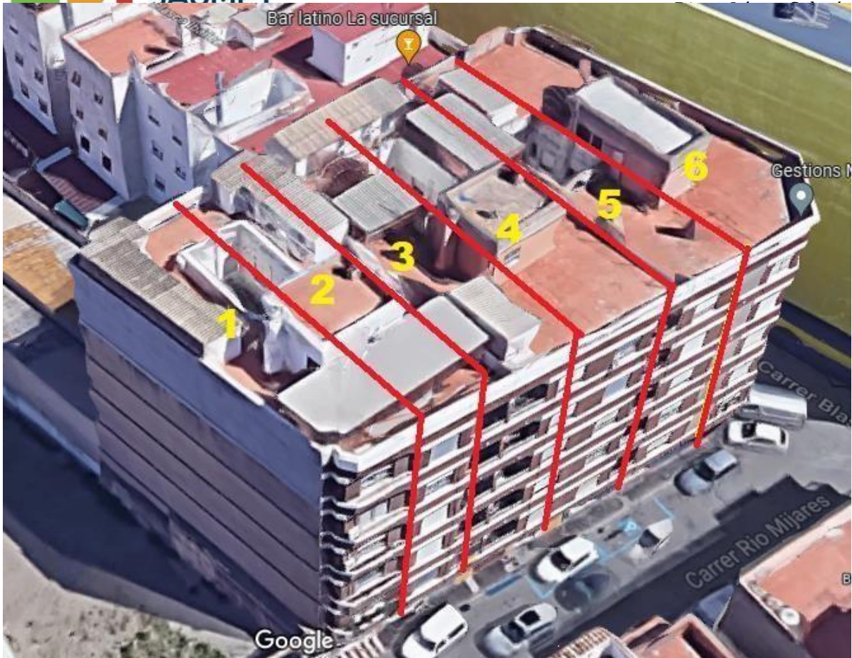
imagen 05. vista isométrica de las partes del edificio a demoler. Google maps.
