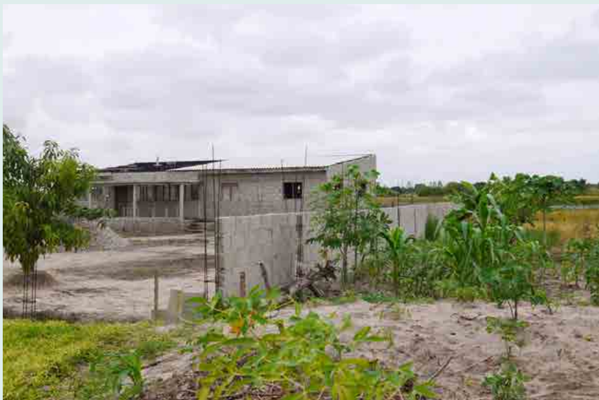
Figura 6. Vista de una vivienda construcción junto con huertos de otra propiedad.
