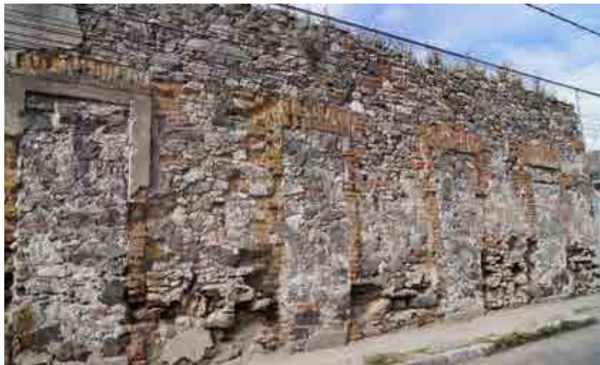
Ilustración 4. Fachada de la antigua casa de «La Locería» o «La Bolsa del Diablo», 24 Poniente 519 o 7 Norte 2208, en el Barrio del Refugio, año 2013. (Fotografía de Adriana Hernández Sánchez.)
