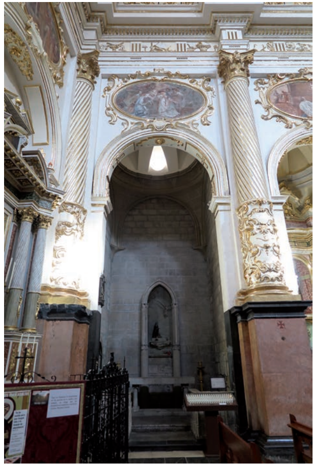
Fig. 3: Capilla de Santa Rita, Iglesia de San Martín Obispo y San Antonio Abad, revoque del 2009, Valencia. Fotografía del autor.
