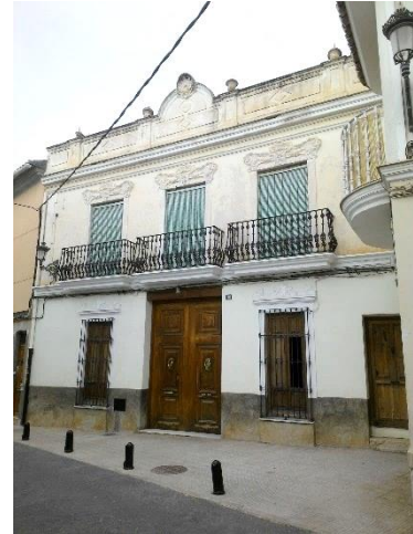
Il·lustració 50 Pça/Santa Bàrbara, 7, any de construcció 1900
