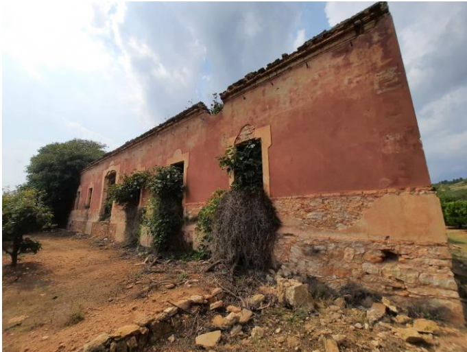
Il·lustració 17 Alqueria de Tasso - façana principal
