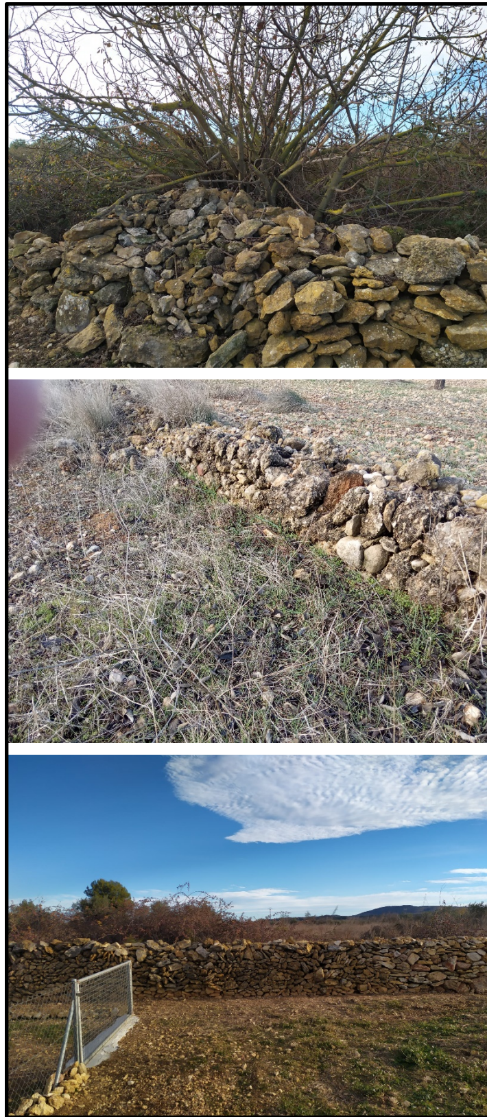
Fotos 8: Muros de piedra seca a reponer o ampliar en altura. Fotografía propia.
