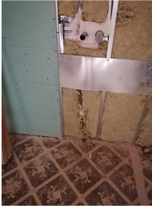
Imágenes 104-105: Colocación de placa y refuerzo en paramentos aislados.
