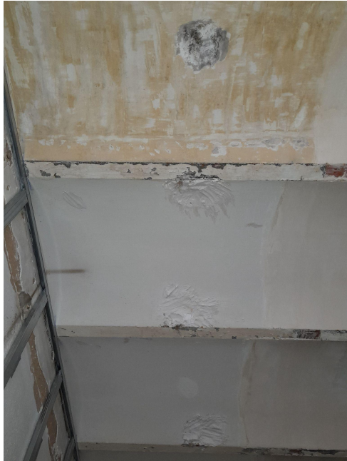
Img 80: Revoltones con pelladas de mortero. Img 81: Revoltones limpiados y picados.
