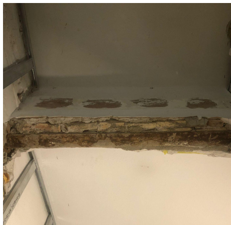
Imagen 98: Dintel metálico existente.
