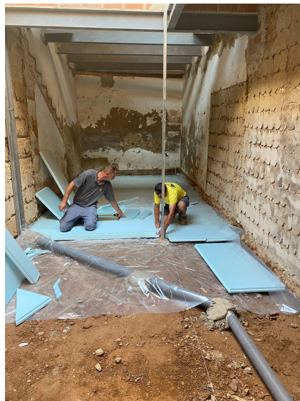
Imagen 67: Niveles, colocación de colector enterrado y de subbase de la solera.
