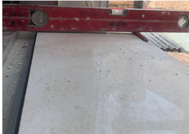
Imagen 137: Vierteaguas con pendiente de mármol Capri.
