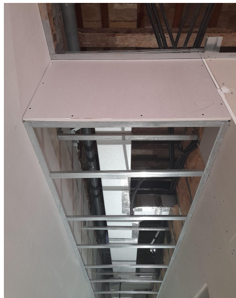
Imagen 123: Tabica vertical en cambio de altura pasillo-habitación principal.
