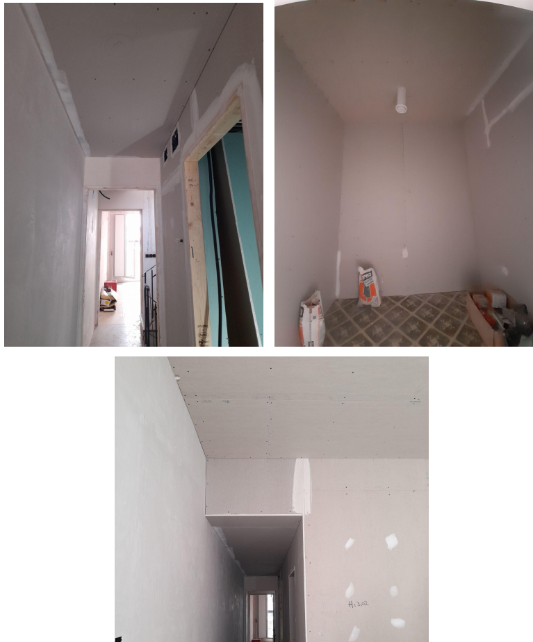
Imágenes 124-125-126: Colocación de placa y elementos de ventilación en falsos techos.
