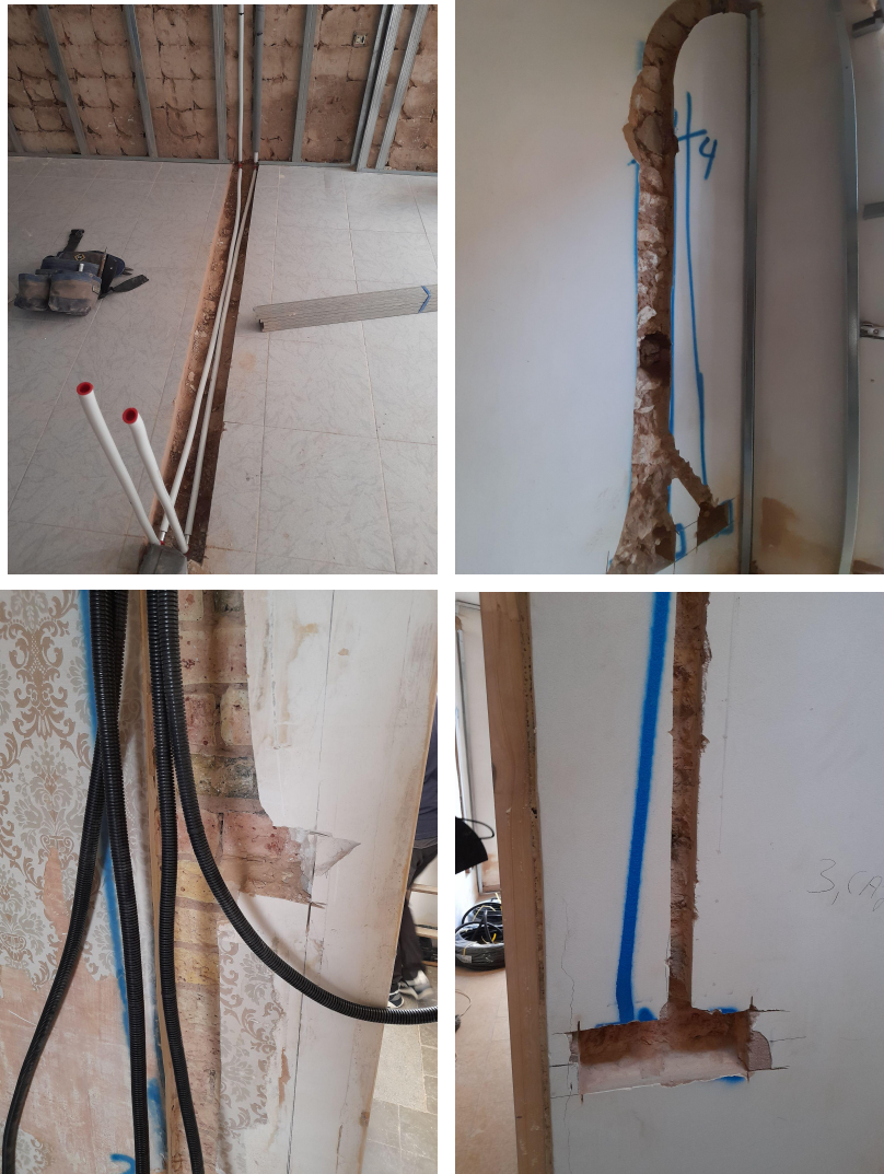
Imágenes 76-77-78-79: Apertura de vanos y regatas en paramentos sin trasdosar.
