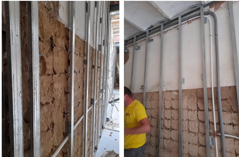
Imágenes 65-66: Colocación de perfilera para trasdosado sin aislamiento.
