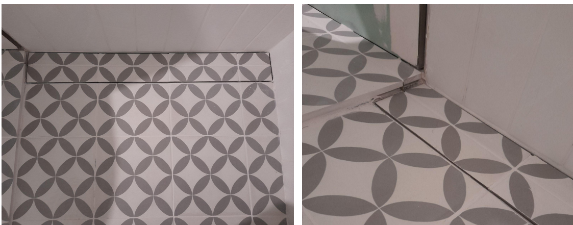
Imágenes 153-154: Plato de ducha in situ con pavimento formato 20x20 cm, pavimento integrado en rejilla y su respectiva pendiente.
