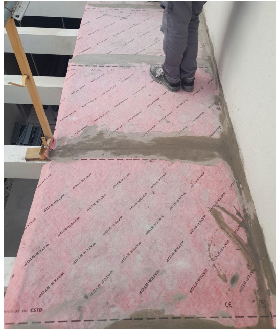
Imagen 131: Impermeabilización de pasillo P1 con lámina tipo EVAC.
