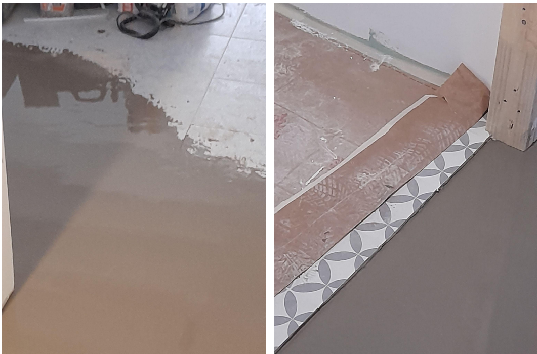
Imágenes 149-150: Autonivelante en capa fina Weber top floor.
