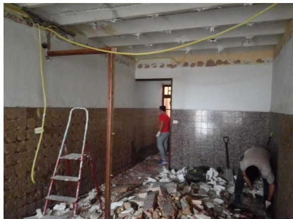
Imagen 62: Demolición de carpinterías interiores.
