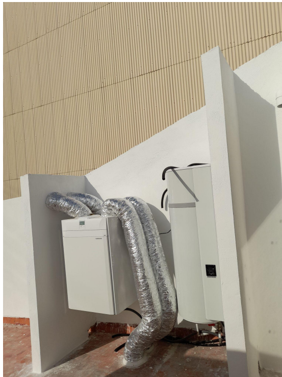
Imagen 128: Caseta de máquinas terminada, a falta de chapa grecada superior.
