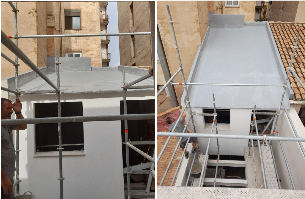
Imágenes 96-97: Impermeabilización de cubierta a base de pintura al clorocaucho.
