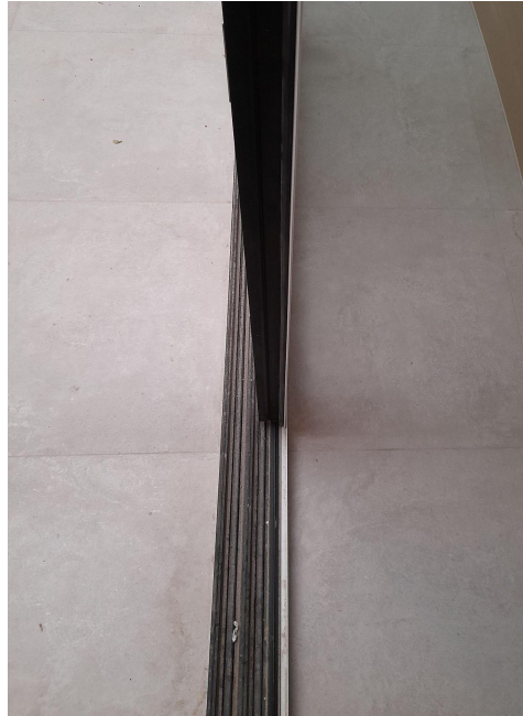
Imagen 155: Izquierda pavimento por el exterior. Derecha pavimento interior zona pasillo PB.
