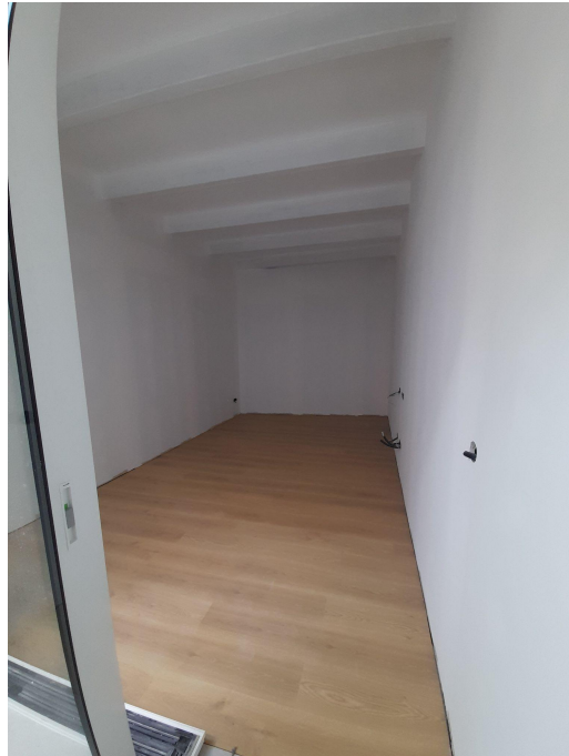
Imagen 164: Colocación de laminado en salón PB y pintura de vigas y forjado ligero.
