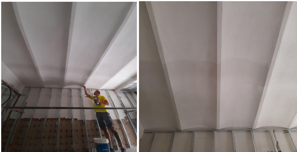
Imagen 87: Guarnecido del techo de revoltones.
