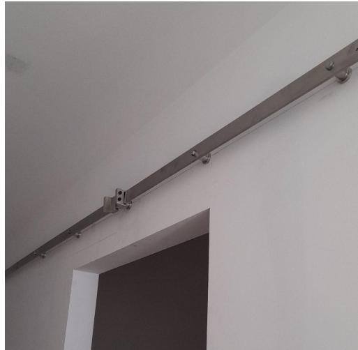
Imagen 173: Guía de acero inoxidable para puerta corredera de madera maciza.
