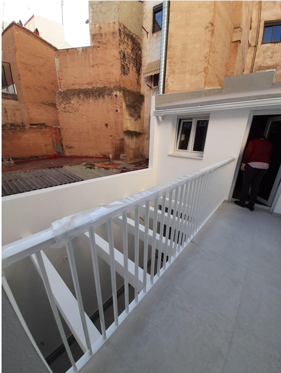
Img 171: Barandilla metálica pasillo P1.
