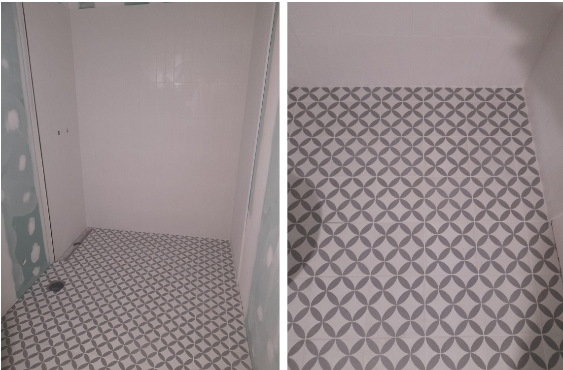
Imágenes 151-152: Pavimento formato 20x20 cm colocado y rejuntado en baño PB.
