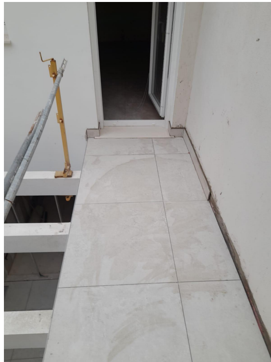
Imagen 133: Colocación de pavimento y rodapié en patio. Imagen 134: Colocación de pavimento y rodapié en pasillo P1.
