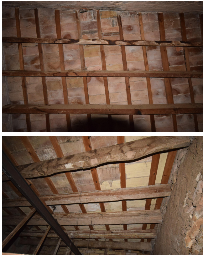
Imágenes 27 y 28: Entrevigado de madera. Viga metálica de refuerzo.
