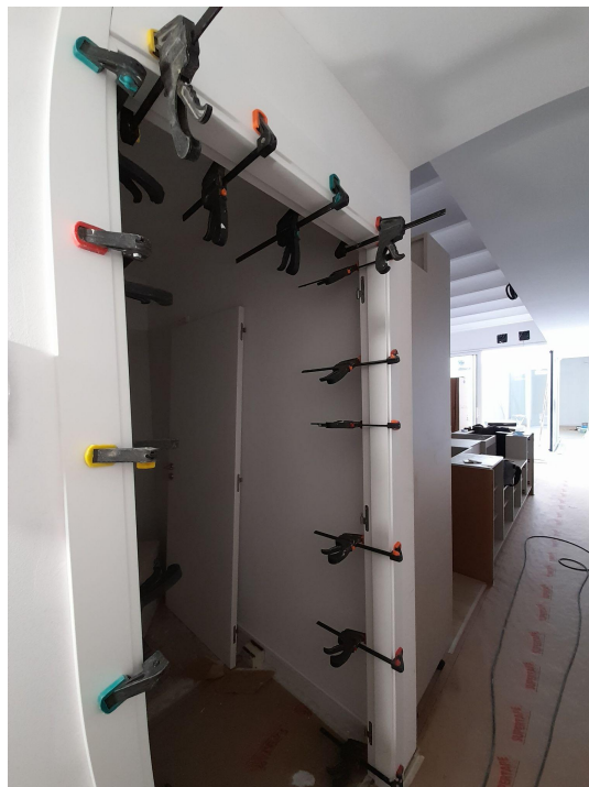
Imagen 165: Colocación de carpintería interior de madera.
