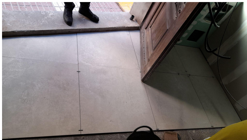
Imagen 156: Pavimento cerámico a la entrada de la vivienda.
