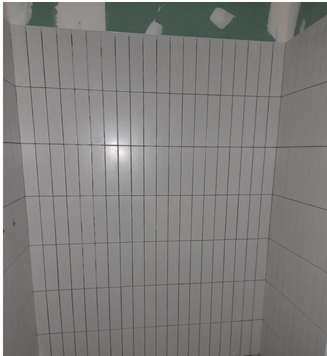
Imagen 147: Colocación de alicatado formato 7.5x30 cm en baños.
