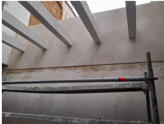
Imagen 84: Segunda mano de enfoscado del vano recayente a patio.
