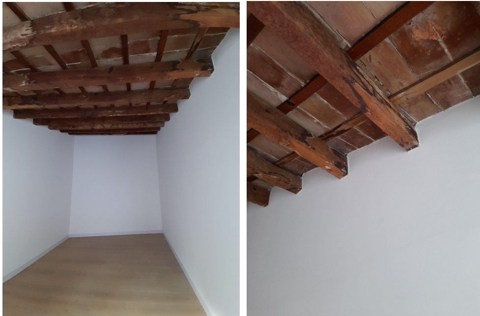
Imágenes 169-170: Trasdoso finalizado y pintado en sala de almacén. Remate final de trasdosado en viguetas de madera.
