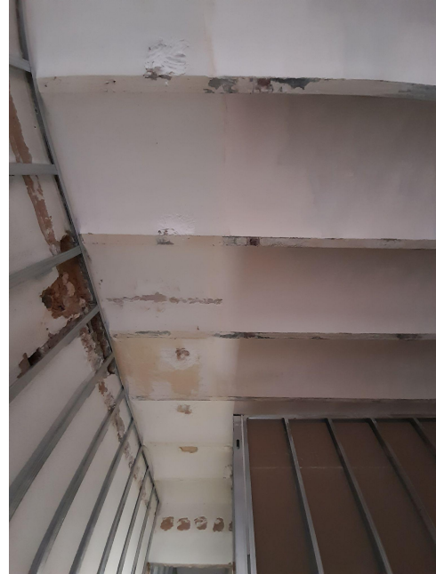
Img 80: Revoltones con pelladas de mortero. Img 81: Revoltones limpiados y picados.
