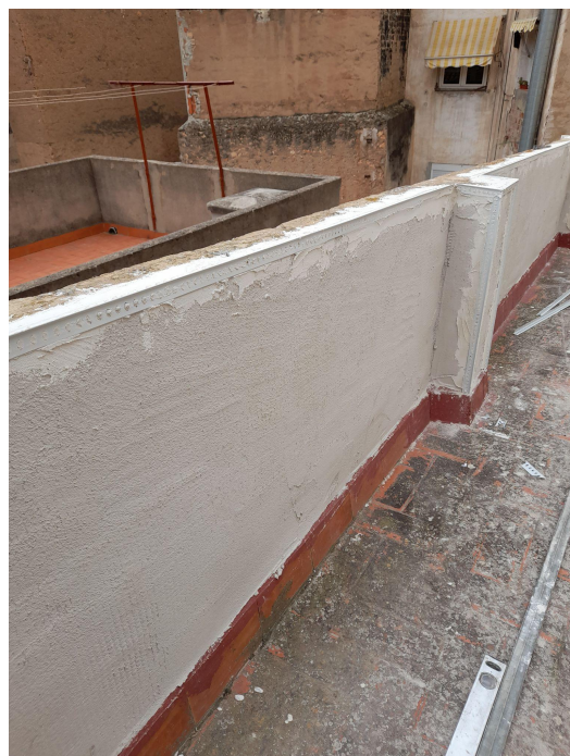
Imagen 112: Enfoscado de petos y antepechos de cubierta transitable.
