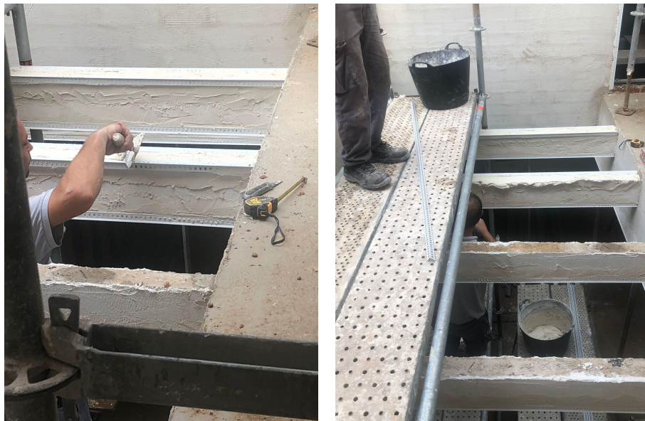
Imágenes 90-91: Enfoscado de viguetas existentes con cantoneras.
