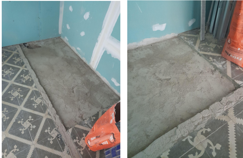
Imágenes 143-144: Pavimento rebajado para la creación de pendientes con mortero.
