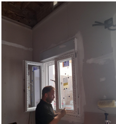
Imagen 120: Colocación de ventana dormitorio principal a falta de remate estético con perfil angular contra trasdosado.
