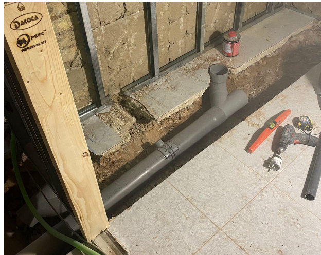
Imagen 68: Colector enterrado planta baja.
