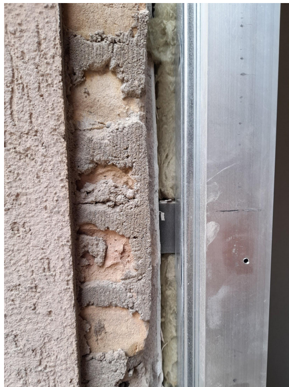
Imagen 75: Colocación de premarco de carpintería exterior, y remate de aislamiento y trasdosado en premarco de ventana.
