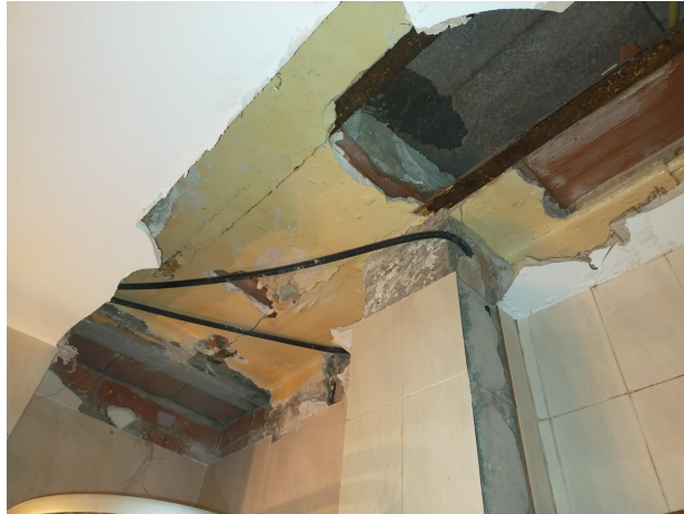
Imagen 29: Pilar y pseudo forjado existentes.
