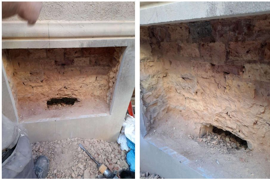
Imágenes 158-159: Picado y apertura de perforaciones en zona de zócalo de piedra en fachada principal para albergar hornacina.
