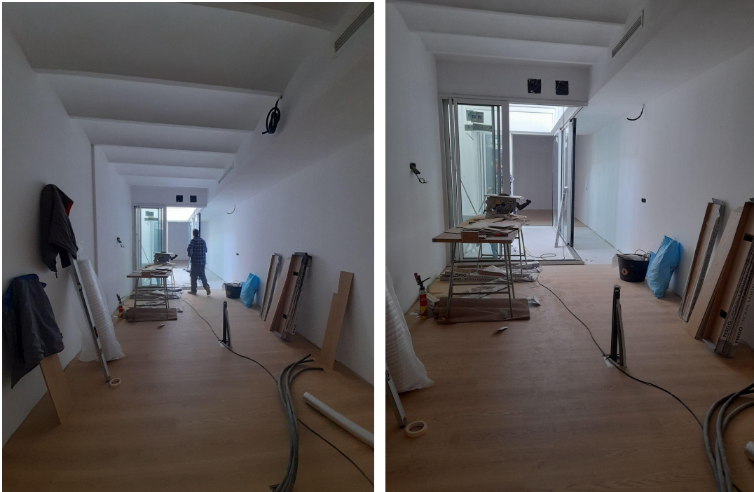
Imágenes 162-163: Colocación de laminado en cocina-comedor PB.
