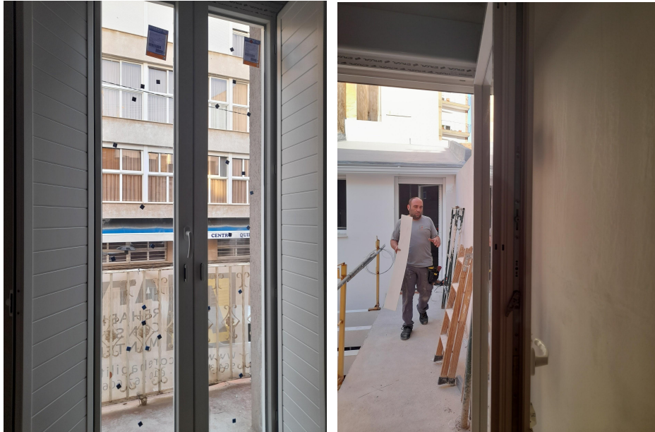
Imágenes 118-119: Colocación de balconeras.
