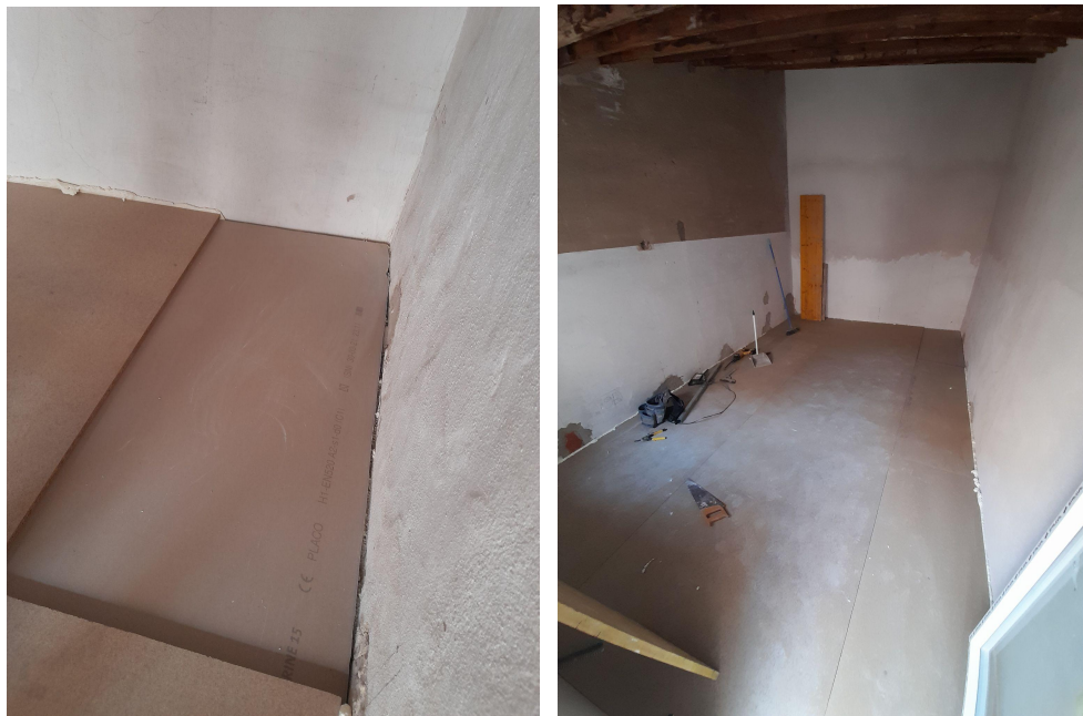
Imágenes 138-139: Ejecución de forjado ligero sala almacén.
