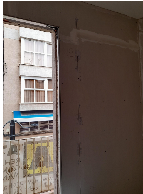
Imágenes 106-107: Colocación de placa en zonas húmedas. Remate de placa contra premarco.
