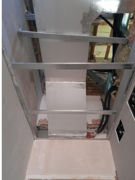
Imagen 102: Ejecución de conductos in situ y estructura de falso techo.
