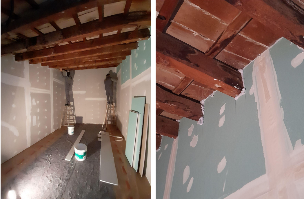
Imágenes 167-168: Ejecución de trasdosado en sala de almacén. Remate de trasdosado en viguetas de madera.
