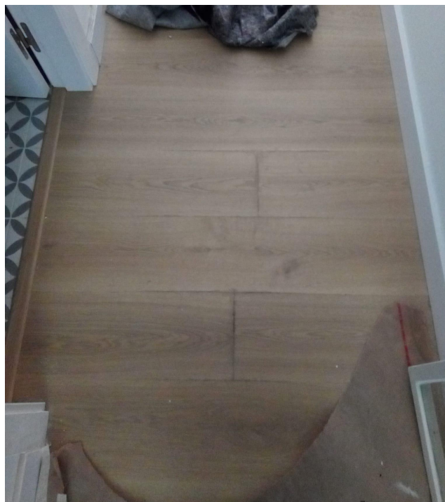
Imagen 177: Resultado del laminado tras la inundación.
