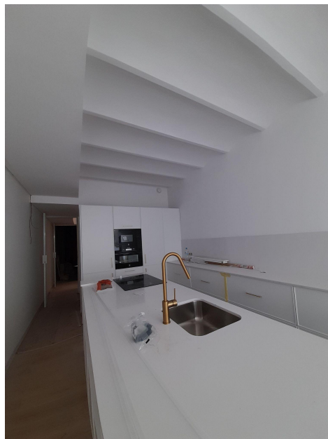
Imagen 174: Montaje de cocina, piedra de encimera y fregadero.
