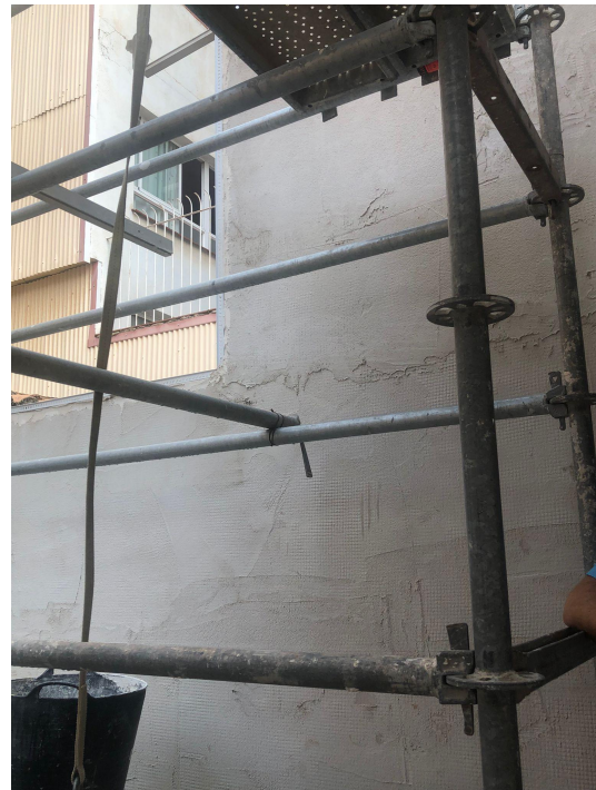
Imagen 83: Ejecución de enfoscado.
