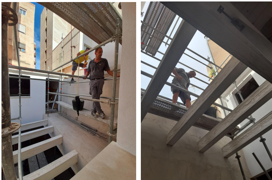
Imágenes 198-199: Trabajos en altura sobre andamio de borriquetas.
