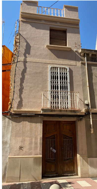
Imagen 4: EA- Fachada principal vivienda.
