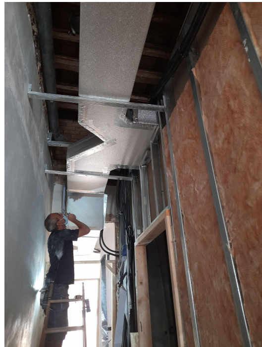
Imagen 101: Ejecución de conductos in situ.
