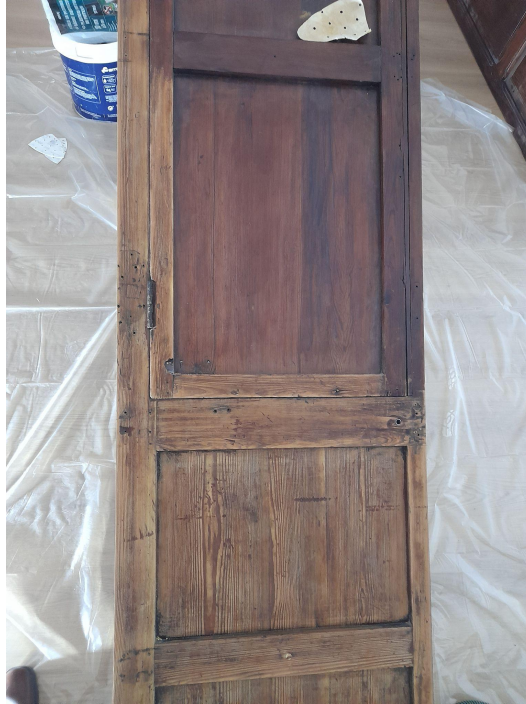
Imagen 175: Hoja de puerta corredera antes y después del lijado.
