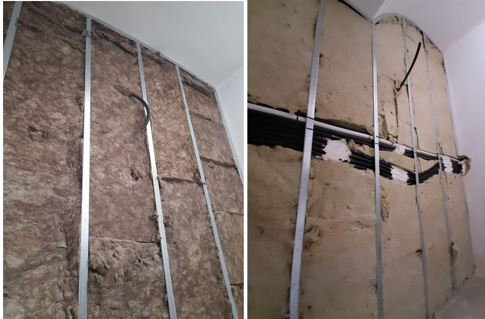
Imágenes 88-89: Falcado de instalaciones y colocación de lana mineral.
