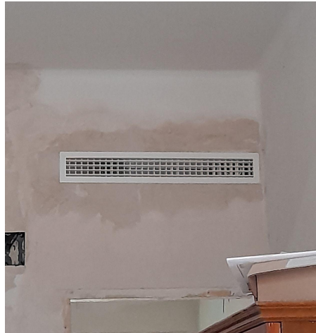
Imagen 127: Instalación de las rejillas en paramentos de ladrillo.
