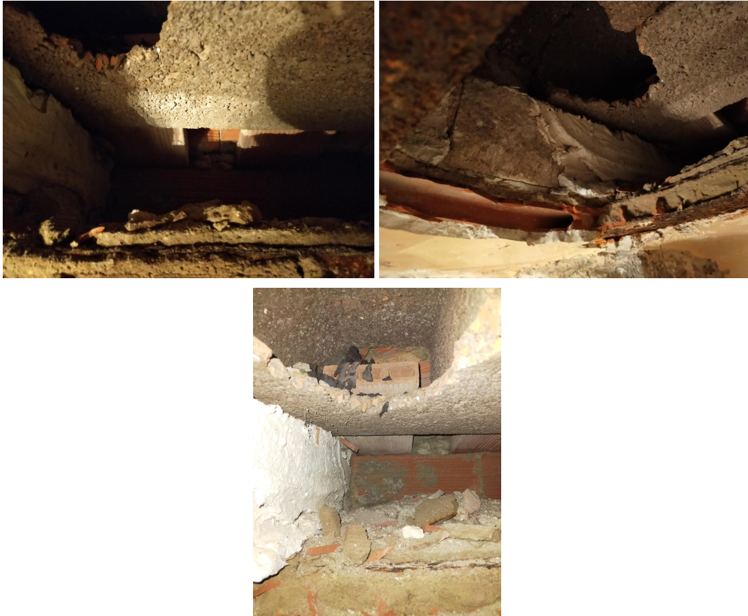
Imágenes 31-32-33: Fotografías ilustrando la sección del pseudo forjado a demoler.
