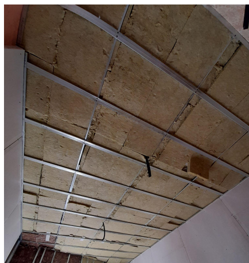
Imagen 117: Lana mineral para aislamiento en falsos techos.
