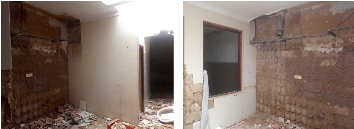
Imágenes 60-61: Demolición de revestimientos y tabiquería existente.
