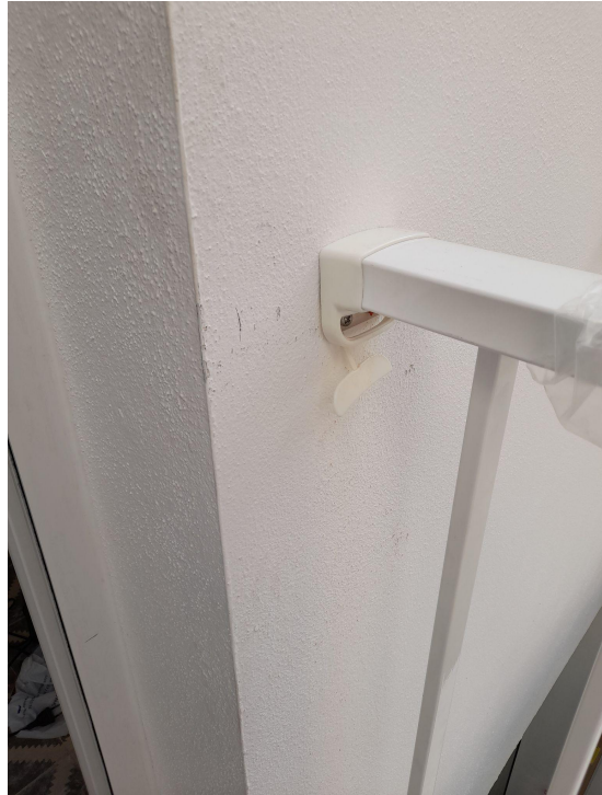
Img 172: Anclaje de barandilla de pared a pared.
