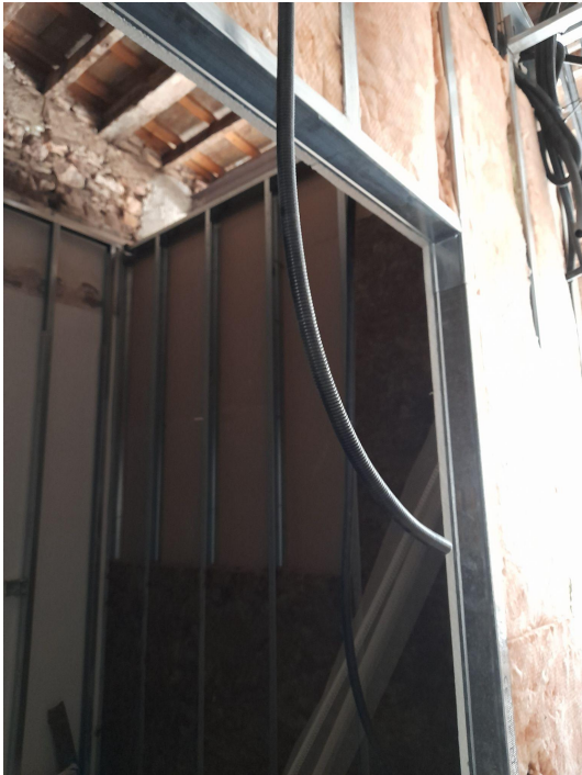
Imagen 100: Aislamiento en tabiquería
