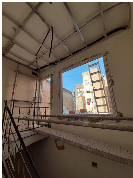
Imagen 201: Montaje de andamio.
