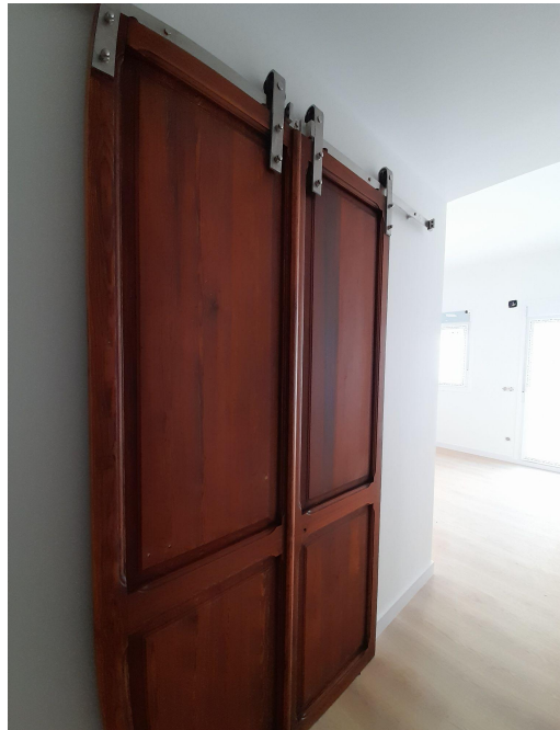
Imagen 176: Puerta corredera restaurada, colocada con guía de acero inoxidable.
