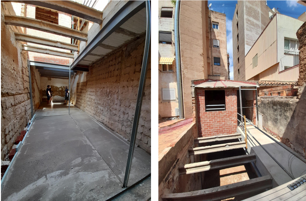
Imágenes 71-72: Cegado de fachada recayente en patio y hormigonado del forjado de pasillo P1.
