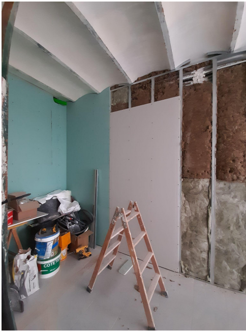
Imágenes 104-105: Colocación de placa y refuerzo en paramentos aislados.
