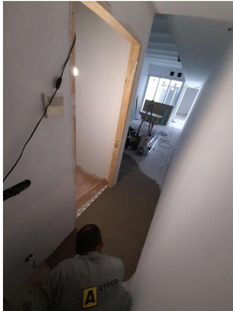
Imagen 148: Albañil vertiendo autonivelante en planta baja.
