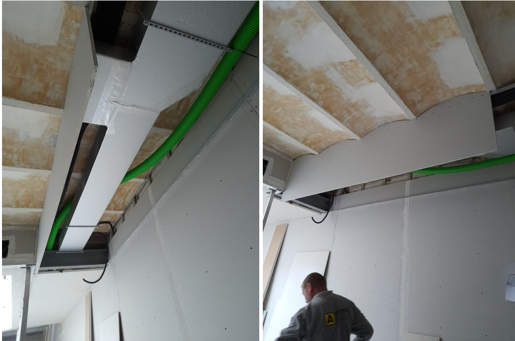
Imágenes 121-122: Tabicas verticales para colocación de rejillas en pasillo planta baja.
