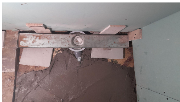
Imagen 145: Formación de pendiente con mortero.
