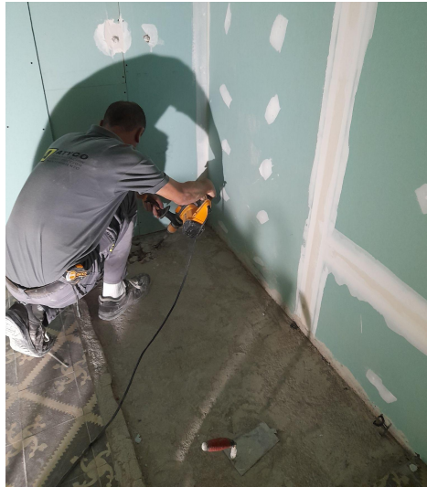
Imagen 142: Picado de pavimento existente para creación de pendiente en plato de ducha.
