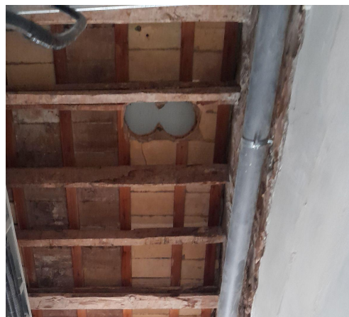
Imagen 110: Apertura y tapado de perforaciones para conductos.
