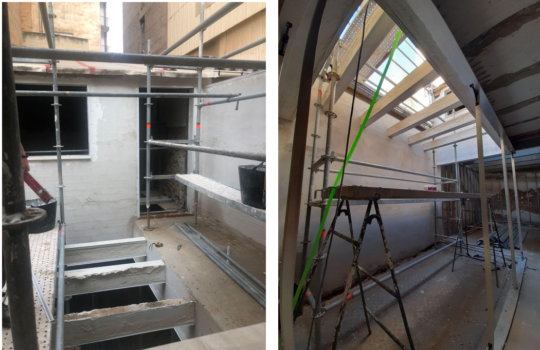
Imágenes 92-93: Fase de enfoscados exteriores.
