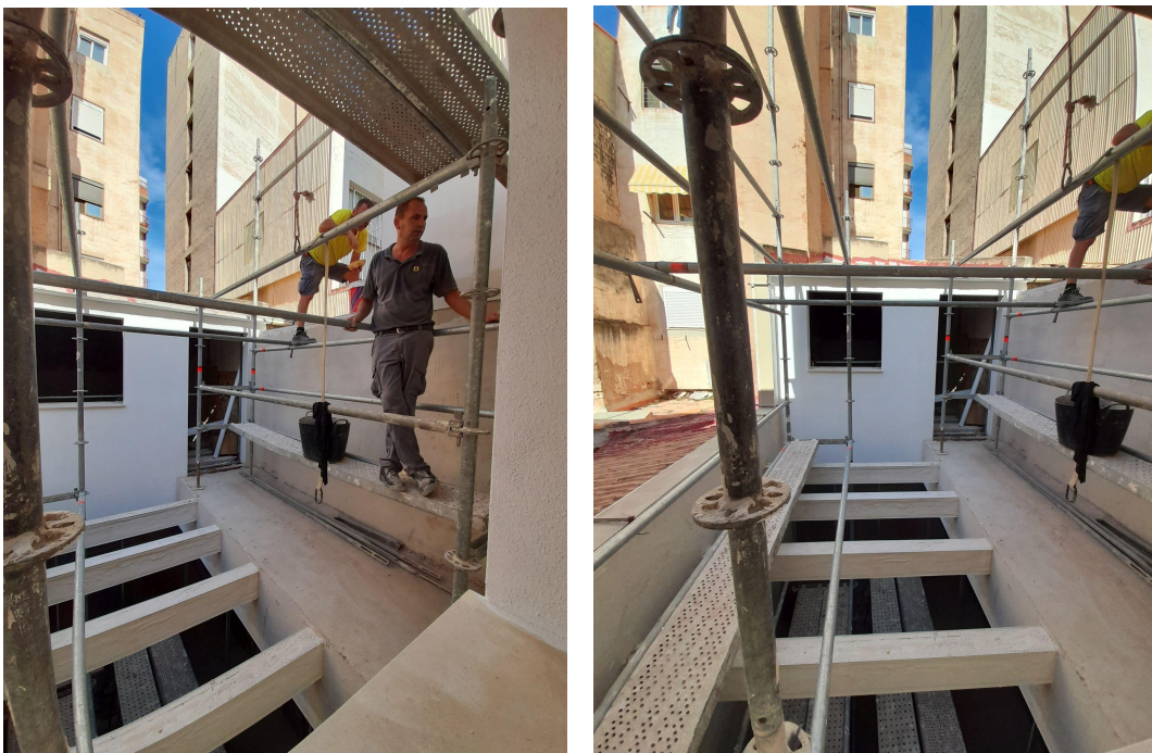
Imágenes 94-95: Primera mano de pintura anti goteras.
