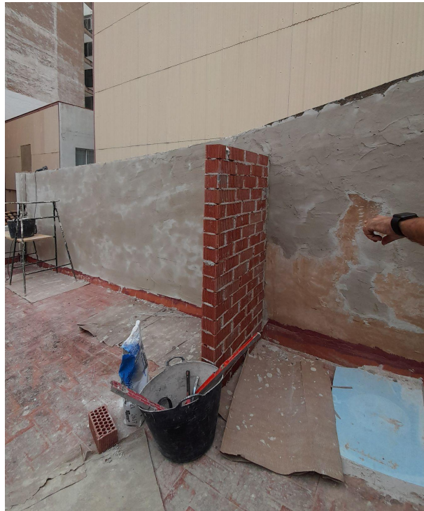
Imagen 111: Ejecución de caseta de maquinaria.
