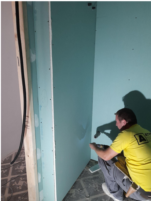
Imágenes 106-107: Colocación de placa en zonas húmedas. Remate de placa contra premarco.
