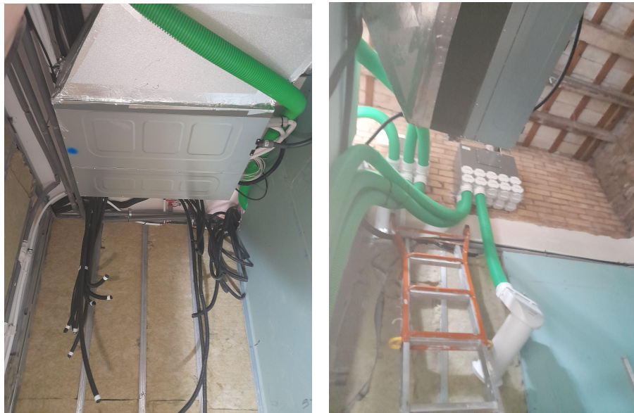
Imágenes 113-114: Instalación de ventilación y unidad interior de máquina sobre falso techo en baños.
