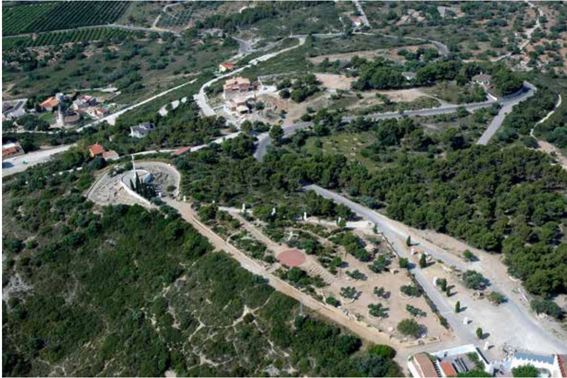
Fig. 1.3.- Vista aérea de la ubicación del Puig de la Misericòrdia
