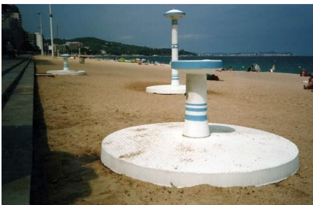
Imagen 83. Ducha y lavapiés de hormigón
