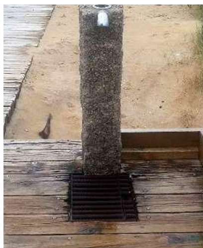
Imagen 90. Lavapiés de piedra y cemento
