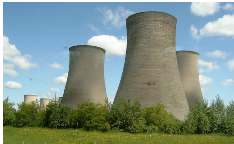
Figura 2.34: Torre de enfriamiento
