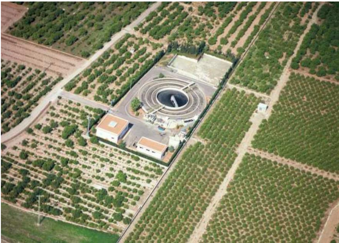
Figura 1. Fotografía aérea de la EDAR Almenara.
