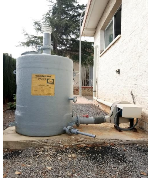
Figura 13. Torre de adsorción.
