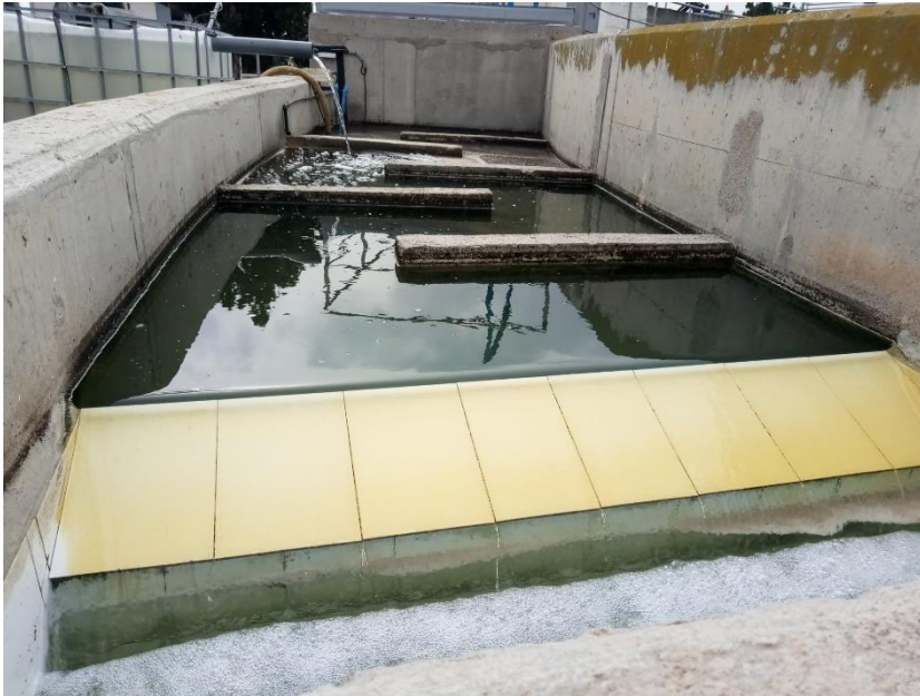
Figura 9. Laberinto de cloración.
