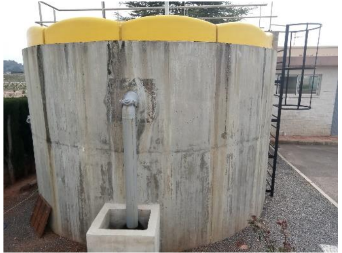
Figura 11. Espesador de fangos.
