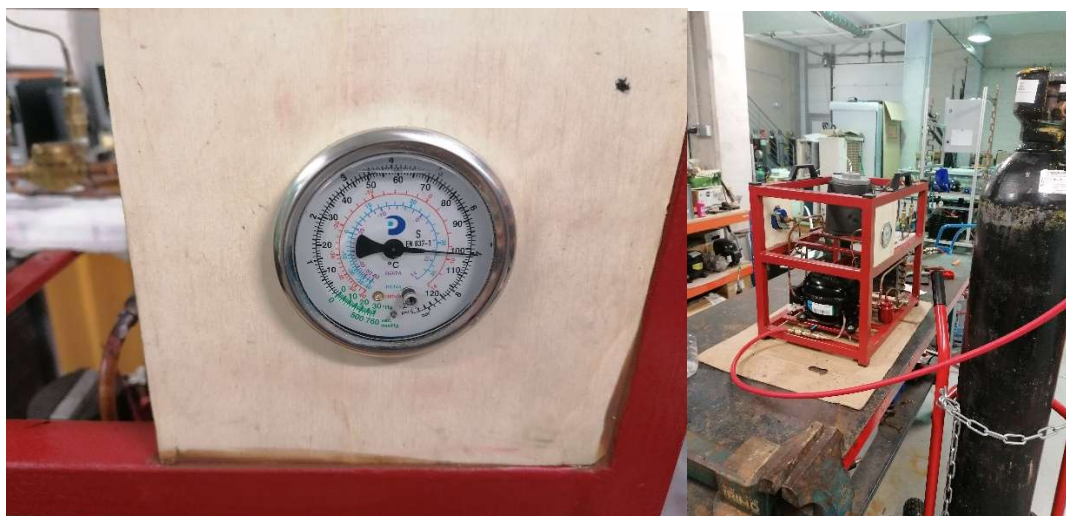
Figura 47. Prueba de estanqueidad.
