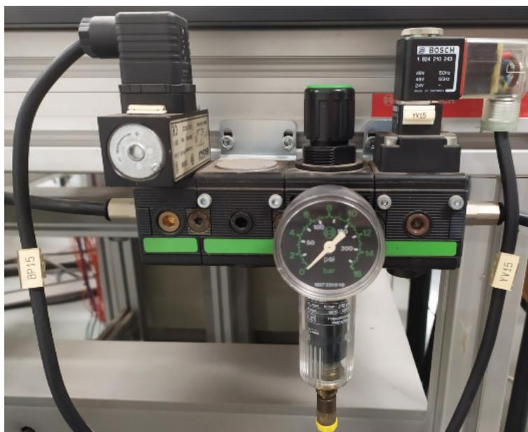
Figura 1.19: Sistema de regulación de aire a presión del sistema de transferencia de palets
