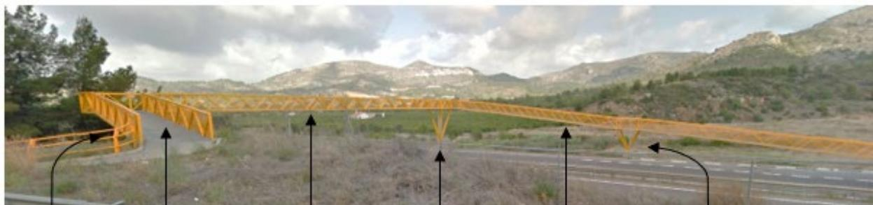
Pilar Izquierdo Rampa Izquierda Parte Central Pilar Derecho A Rampa Derecho A, B, C y D Pilar Derecho B
