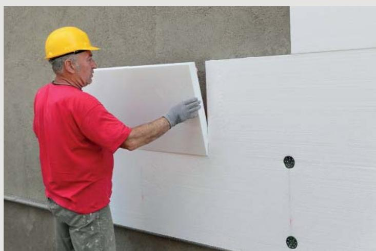
Figura 4.14.- Colocación de paneles EPS. Fuente: Placomat.
