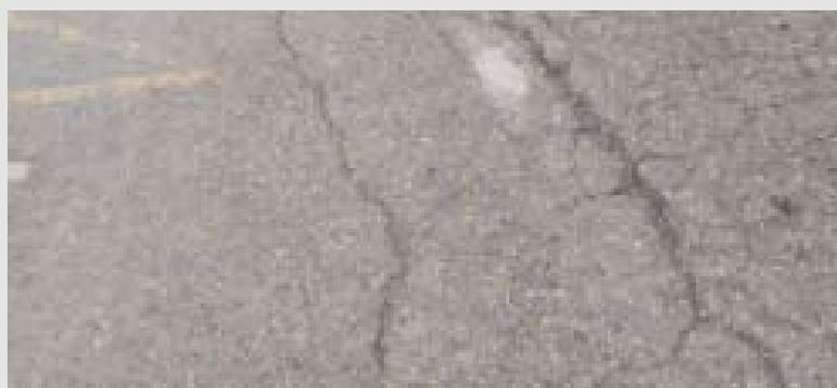
Figura 4.27.-Pavimento de asfalto. Culla. Fuente: Autora.
