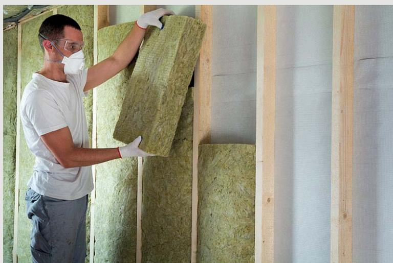
Figura 4.7.- Lana de roca. Fuente: Provaiser.
