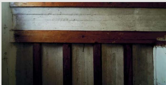
Figura 3.13.-Forjado encofrado de yeso con vigas y viguetas de madera, Placeta de la Iglesia, Villafraanca. Fuente: Cátedra Diputación de Centros Históricos e Itinerarios Culturales (2018).
