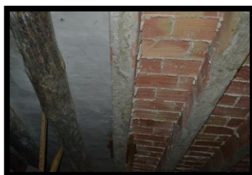
Figura 4.69. Bigueta encofrada amb rajola. (Font: Autor.)
