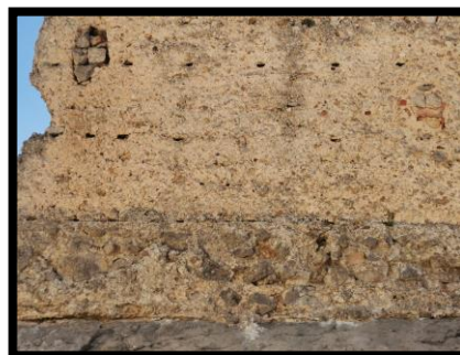
Figura 3.10. Detall mur de tàpia. (Font: Autor.)
