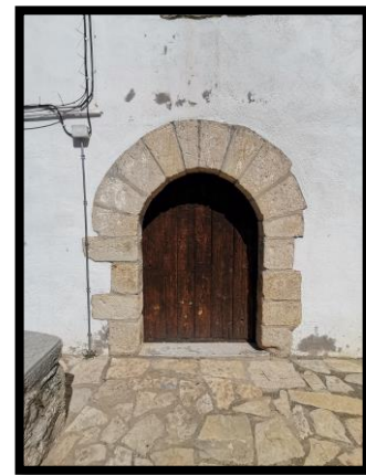
Figura 3.25. Arc de Mig Punt. (Font: Autor.)
