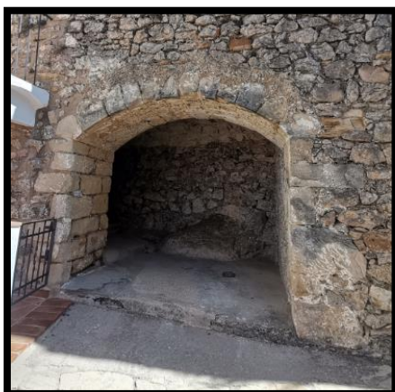
Figura 3.29. Arc Rebaixat. (Font :Autor.)
