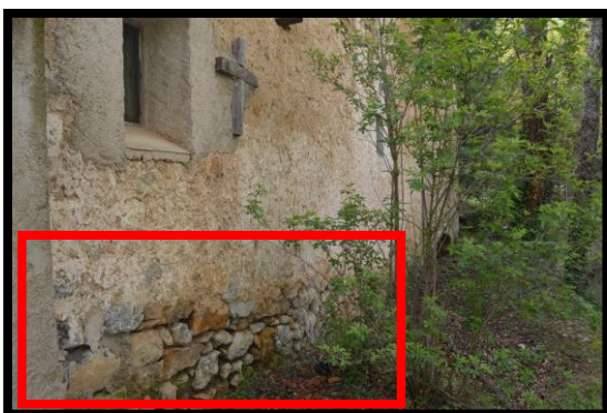
Figura 4.57. Façana de maçoneria. (Font: Autor.)
