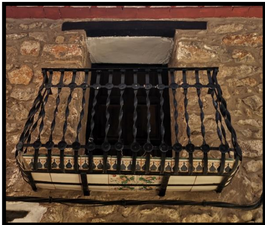
Figura 3.46. Balcó de ferro amb llosa de ceràmica. (Font: Autor.)
