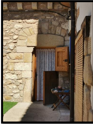
Figura 3.32. Arc de Descàrrega. (Font: Autor.)
