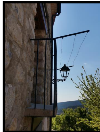
Figura 3.47. Balcó de ferro amb llosa d'argamassa. (Font: Autor.)
