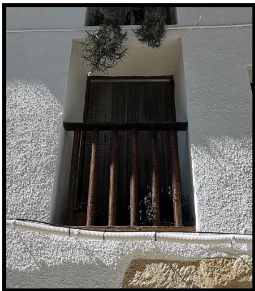
Figura 3.42. Balcó de fusta alineat a la façana. (Font: Autor.)
