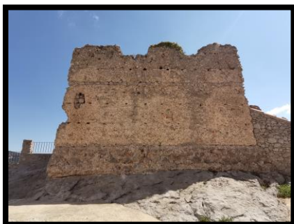
Figura 3.9. Mur de tàpia a Xodos. (Font: Autor.)
