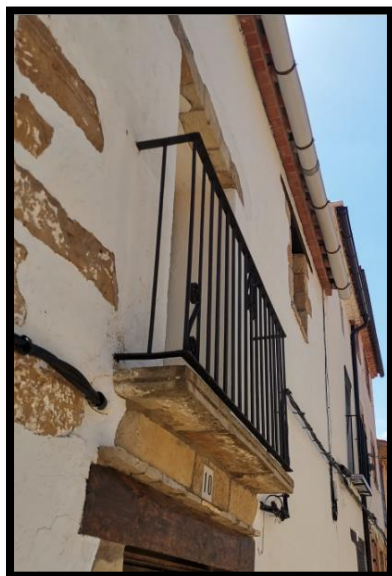
Figura 3.48. Balcó amb llosa de pedra. (Font: Autor.)
