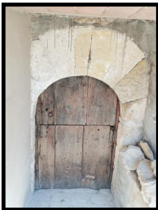
Figura 3.23. Arc de Mig Punt. (Font: Autor.)
