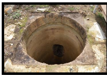
Figura 4.9. Entrada d'aigua al cub. (Font: Autor.)
