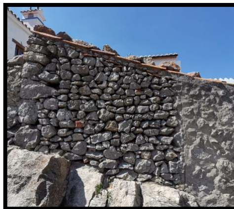
Figura 3.12. Mur de pedra en sec a Xodos. (Font: Autor.)
