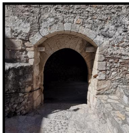
Figura 3.30. Arc Rebaixat. (Font :Autor.)
