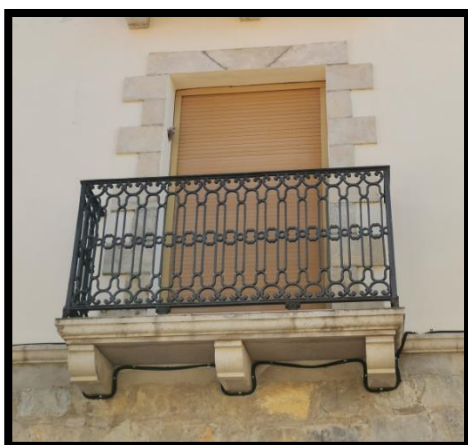
Figura 3.44. Balcó amb llosa de pedra (Font: Autor.)
