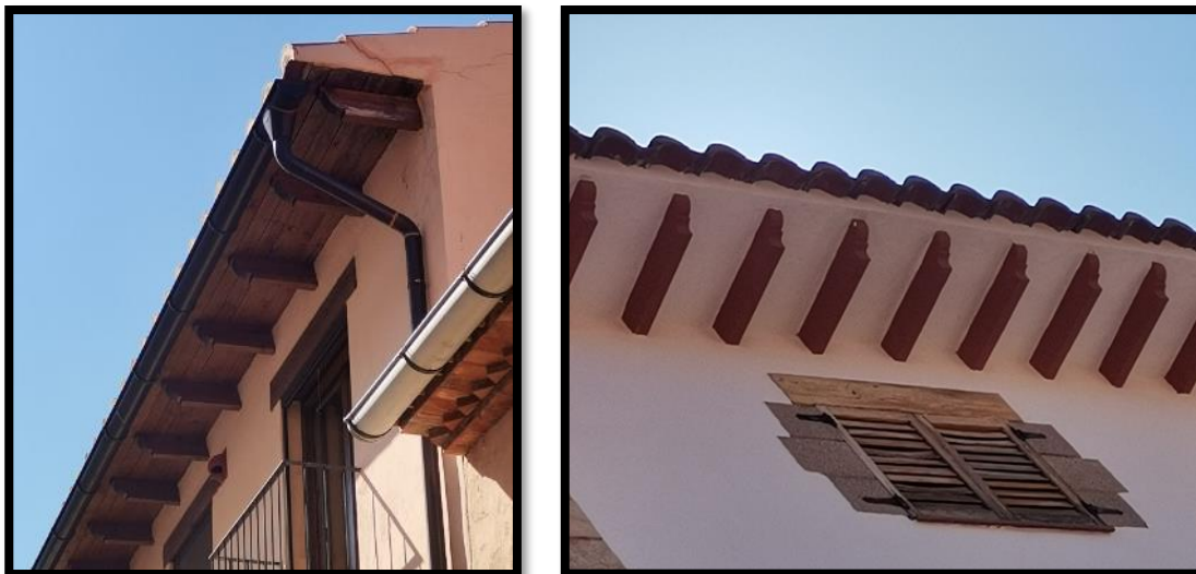
Figura 3.54. Ràfec de fusta simple. (Font: Autor.)
