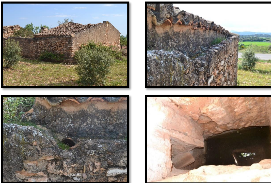
Figura 2.4. Recollida d'aigües pluvials en un mas d'alta muntanya. (Font: Autor.)
