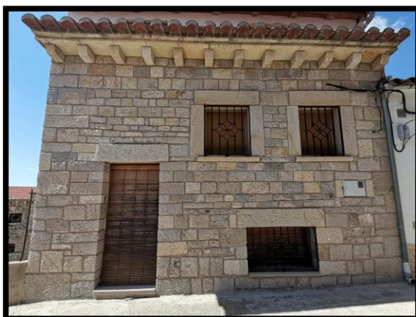
Figura 3.14. Façana de carreus a Xodos. (Font: Autor.)
