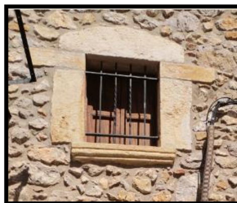
Figura 3.39. Llinda de Pedra en Finestra de Xodos. (Font: Autor.)
