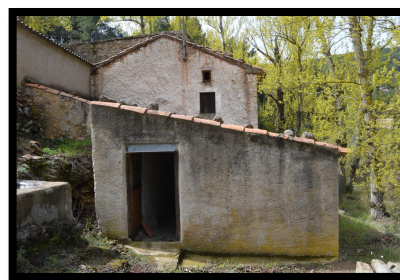
Figura 4.62. Mur de rajola i morter de ciment. (Font: Autor.)
