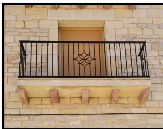
Figura 3.45. Balcó sobre llosa de pedra. (Font: Autor.)
