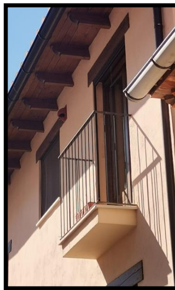
Figura 3.49. Balcó amb llosa de formigó armat. (Font: Autor.)
