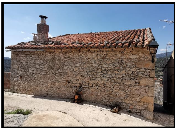
Figura 3.11. Mur de maçoneria a Xodos. (Font: Autor.)
