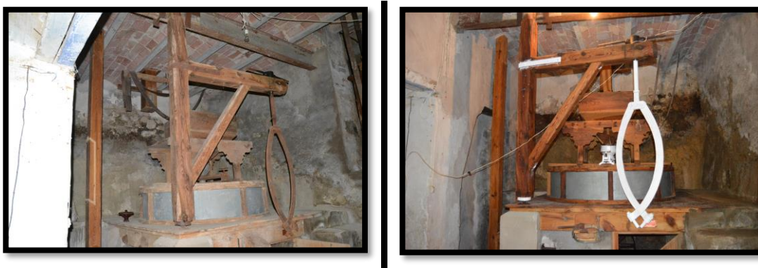
Figura 4.50. Treballs de manteniment en la maquinaria del molí. (Font: Autor.)
