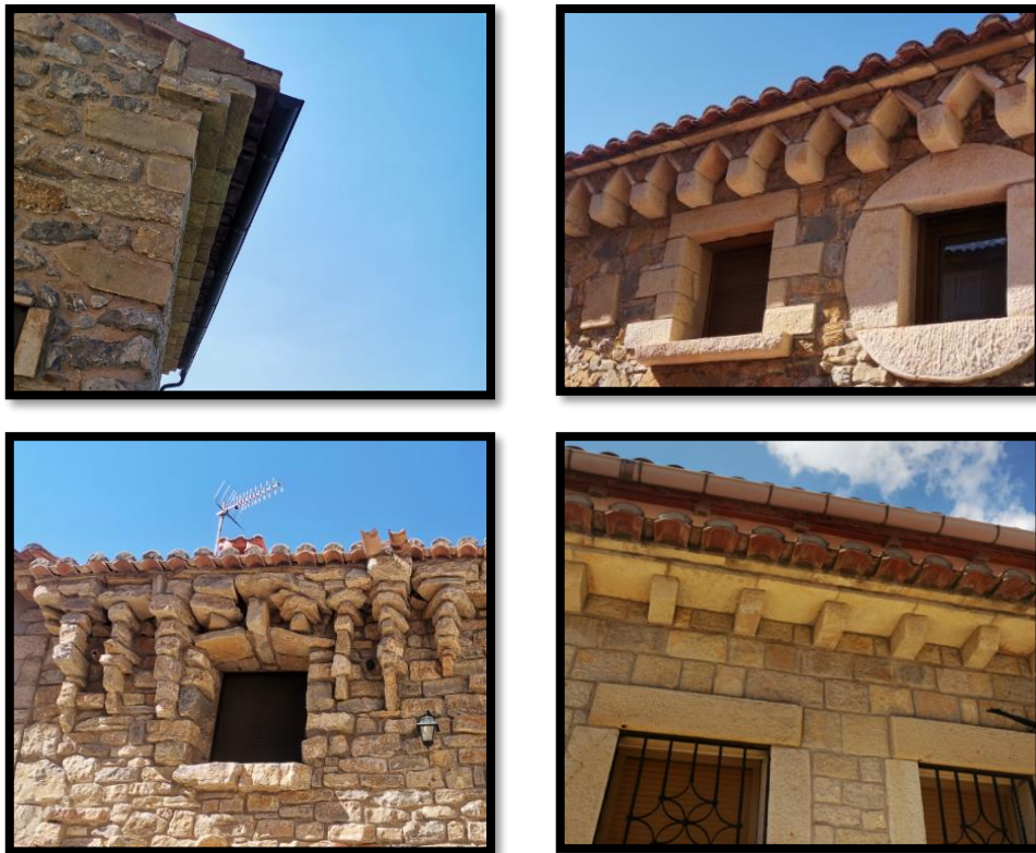
Figura 3.52. Ràfecs de pedra a Xodos. (Font: Autor.)
