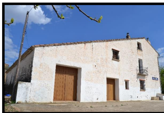
Figura 2.3. Vessants de coberta dels masos comuns. (Font: Autor.)
