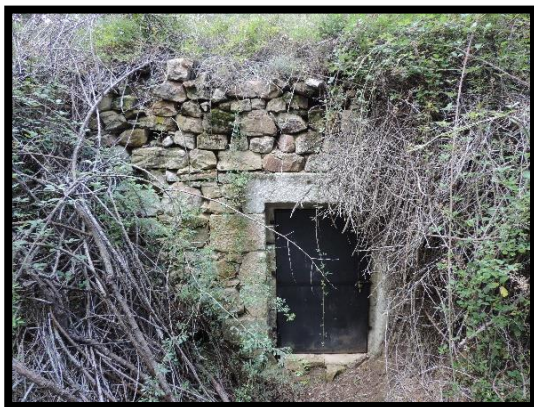
Figura 2.8. Porta de la nevera del Penyagolosa. (Font: Càtedra de Centres Històrics i Itinerants Culturals de la UJI.)
