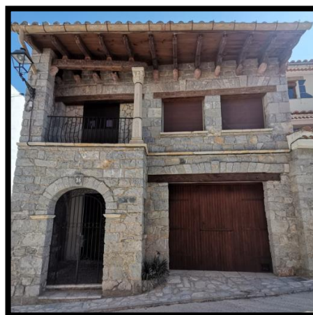
Figura 3.15. Façana de carreus a Xodos. (Font: Autor.)
