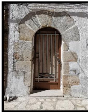
Figura 3.24. Arc de Mig Punt. (Font: Autor.)
