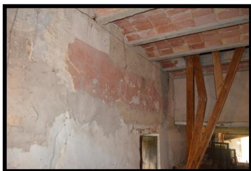
Figura 4.25. Nou forjat, i envà de separació entre plantes. (Font: Autor.)
