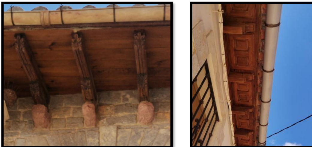
Figura 3.56. Ràfecs de fusta amb treballs de talla. (Font: Autor.)
