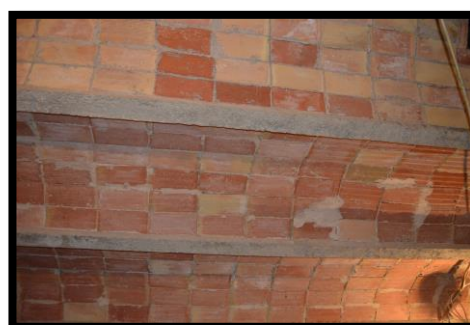
Figura 4.64. Bigueta pretesada amb entrebicat de revoltó de volta de rajola. (Font: Autor.)
