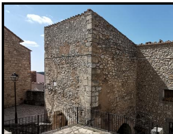
Figura 3.17. Cantonada reforçada amb carreus a Xodos. (Font: Autor.)
