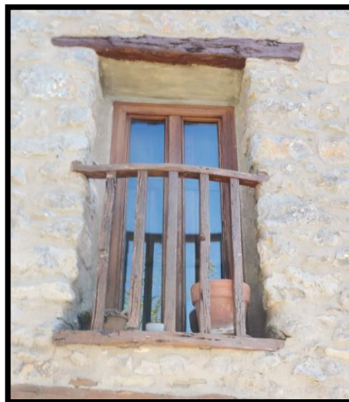
Figura 3.43. Balcó de fusta alineat a la façana. (Font: Autor.)
