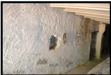
Figura 4.11. Façana original. (Font: Autor.)
