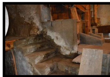
Figura 4.61. Revestiment de morter de ciment. (Font: Autor.)
