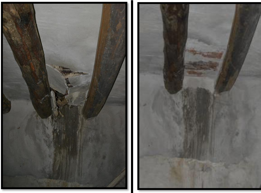
Figura 4.51. Reparació del enfonsament del teulat. (Font: Autor.)
