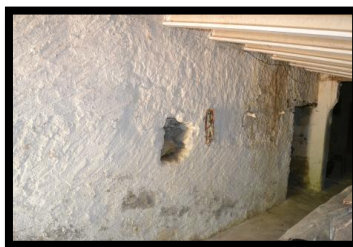
Figura 4.60. Revestiment de morter de calç. (Font: Autor.)
