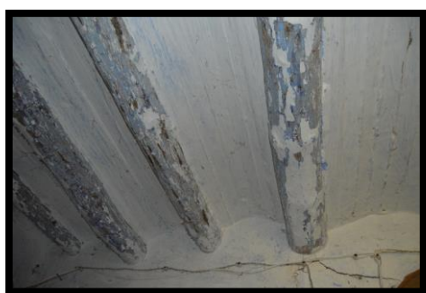
Figura 4.63. Bigueta de fusta amb entrebicat de guix. (Font: Autor.)
