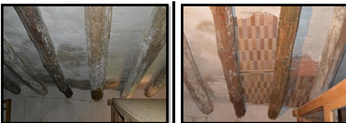
Figura 4.52. Substitució de la bigueta i reparació de la coberta. (Font: Autor.)
