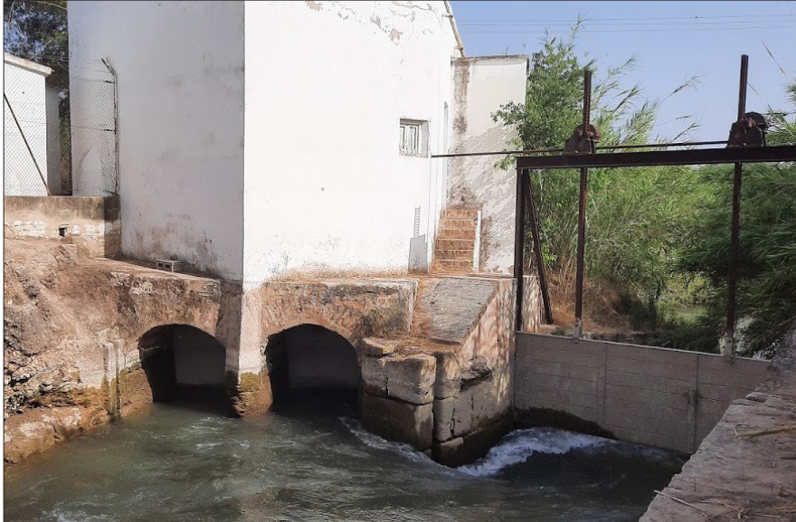
FIGURA 2: BOCA O GOLA Y ALMENARA DE LA ACEQUIA DE MESTALLA. A LA IZQUIERDA LA ENTRADA DEL CANAL, CON LAS COMPUERTAS CERRADAS, Y ENCIMA LA CASETA MODERNA QUE PROTEGE EL MECANISMO DE ELEVACIÓN DE LAS COMPUERTAS PARA EVITAR MANIPULACIONES. A LA DERECHA LA ALMENARA CON LA COMPUERTA ABIERTA, QUE ES EL CANAL POR DONDE VUELVE AL RÍO EL AGUA QUE TOMA DE MÁS EL AZUD
