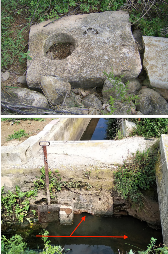
FIGURA 1: ARRIBA UN ROLL O ULL EN LA ACEQUIA DE ALÈDUA (LLOMBAI, VALÈNCIA). ES UN ORIFICIO PICADO EN UNA PIEDRA QUE SE INCRUSTA EN EL LATERAL DE LA ACEQUIA, POR DONDE ENTRA EL AGUA A UN CANAL SECUNDARIO. EN ESTE CASO LA PIEDRA ESTÁ TIRADA EN EL FONDO DEL CANAL TRAS UNA REFORMA QUE LA SUSTITUYÓ POR UNA COMPUERTA. ABAJO UN ROLL DE LA ACEQUIA DE ANDARELLA, EN LA HUERTA DE VALÈNCIA. AQUÍ LA PIEDRA ESTÁ IN SITU , INCRUSTADA EN EL LATERAL DE LA ACEQUIA. CASI NO SE APRECIA EL ORIFICIO POR ESTAR CUBIERTO DE AGUA, PERO ES SU TAMAÑO EL QUE MIDE LA CANTIDAD DE AGUA QUE CORRESPONDE AL NUEVO CANAL
